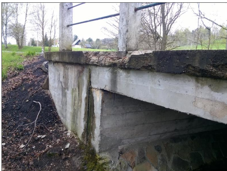
Rozpad římsy na výtokové straně
