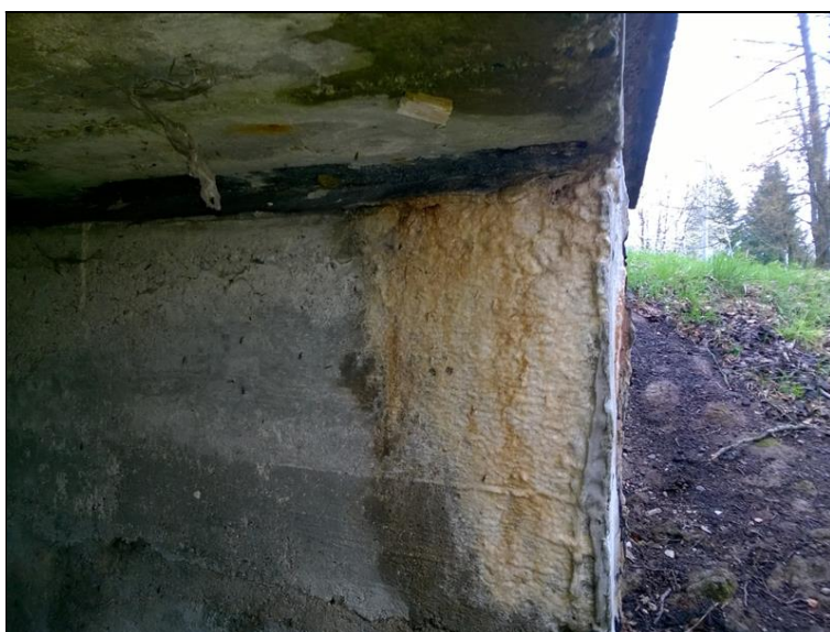
Projevy zatékání na opěry
