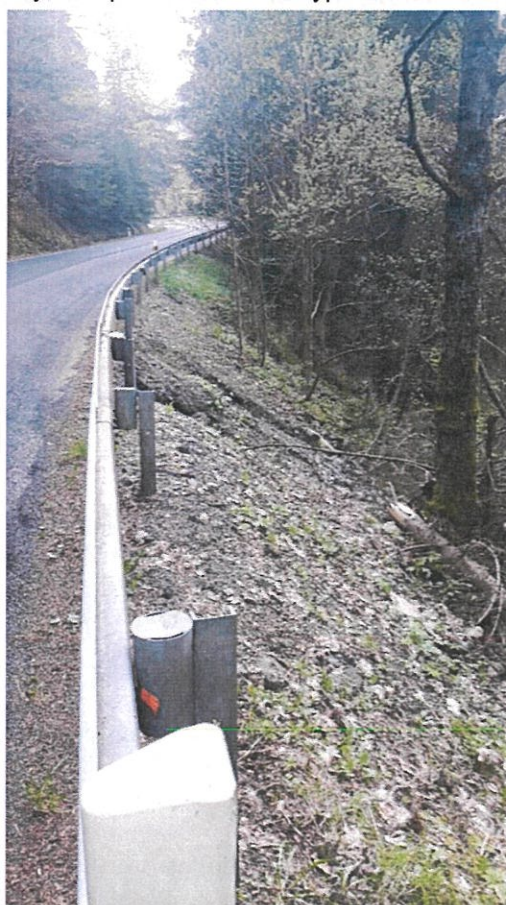
Obrázek 1 – Násypová strana komunikace – erozní rýhy
