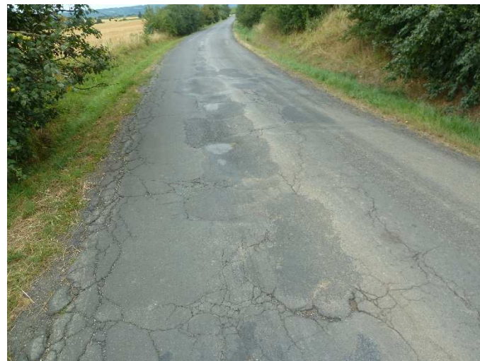
Detail poruchy vozovky
