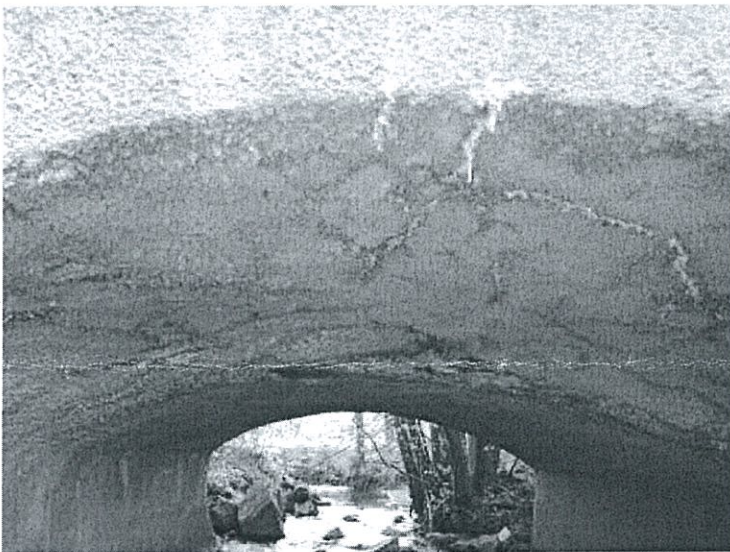
Podhled NK - trhliny v torkretové omítce, výluhy pojiva, odpad torkretu
