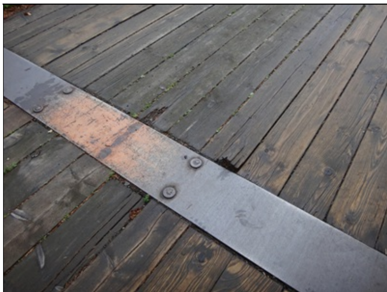
Poruchy pojezdových dřevěných prvků mostovky
