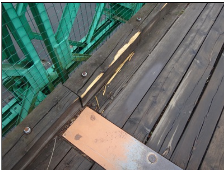
Poruchy odrazných dřevěných obrubníků
