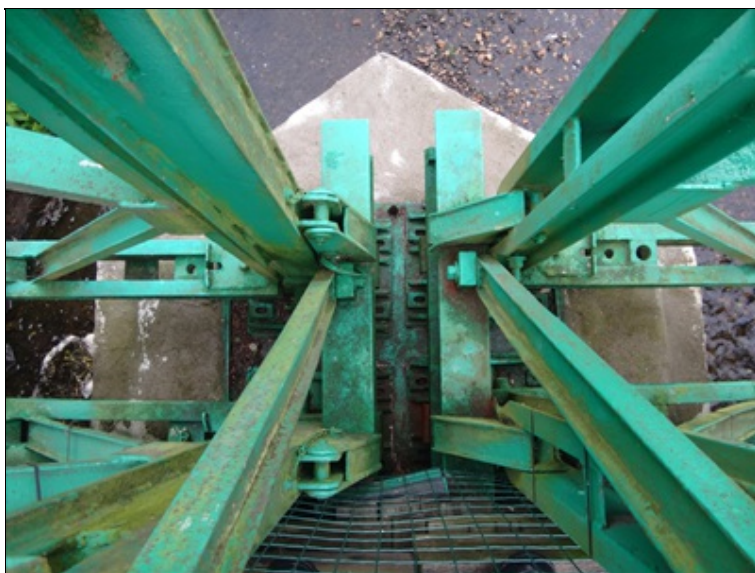
Detail uložení na pilíři 3
