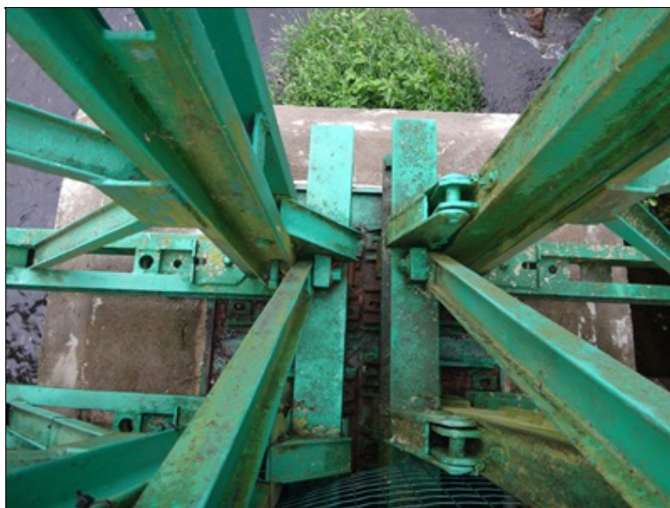
Detail uložení na pilíři 2
