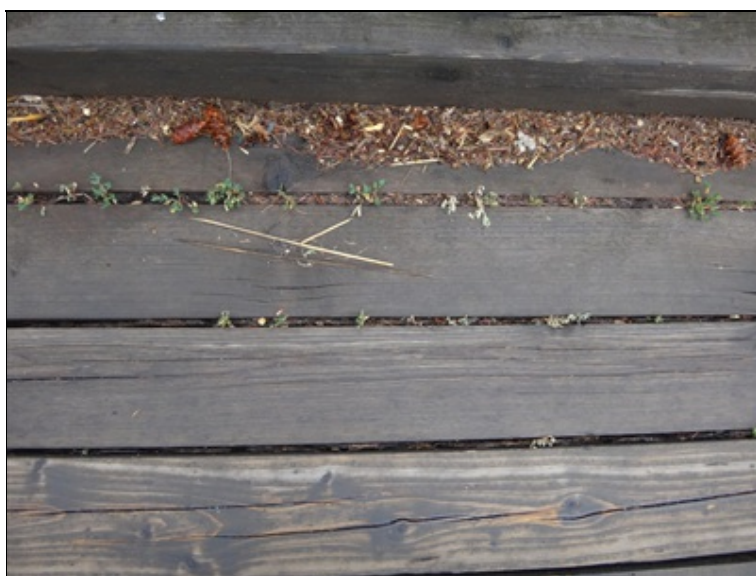
Poruchy jezdových prvků mostovky
