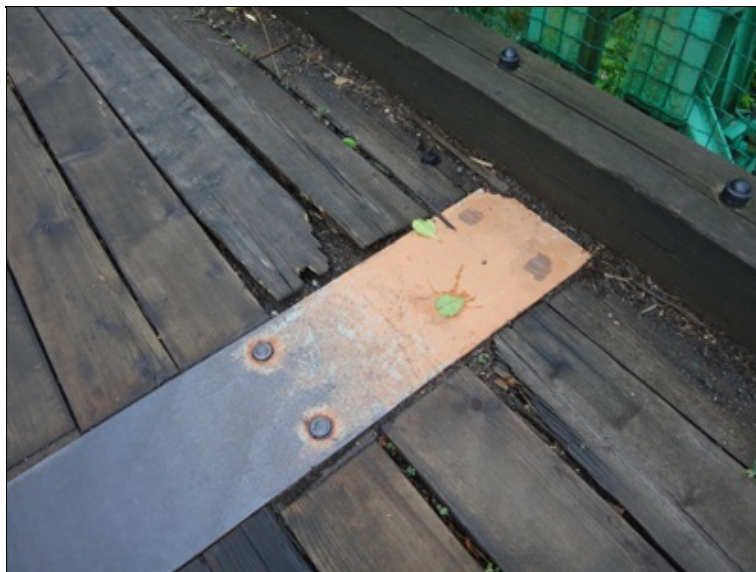
Poruchy jezdových prvků mostovky
