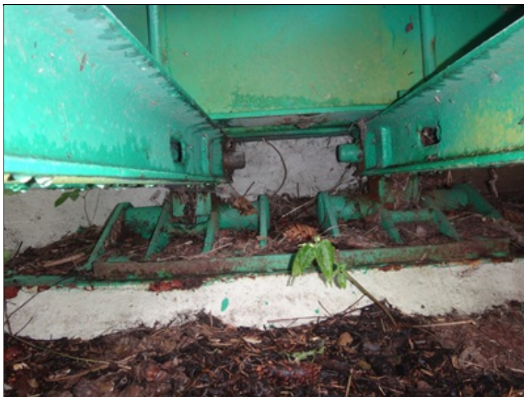
Uspořádání na úložném prahu pravobřežní opěry
