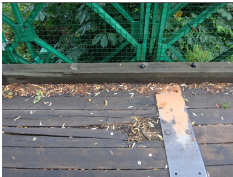
Poruchy jezdových prvků mostovky
