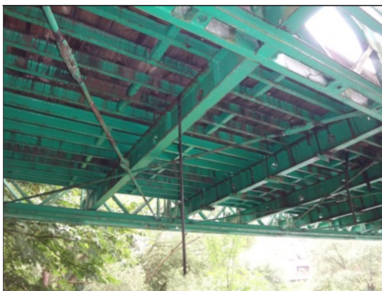
Podhled NK, vysunuté tlumící pásky
