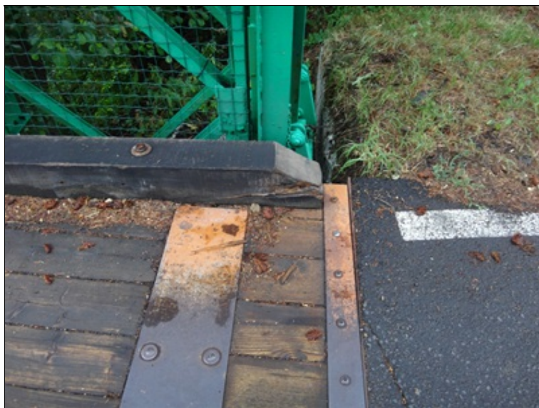
Detail a poruchy ukončení mostovky
