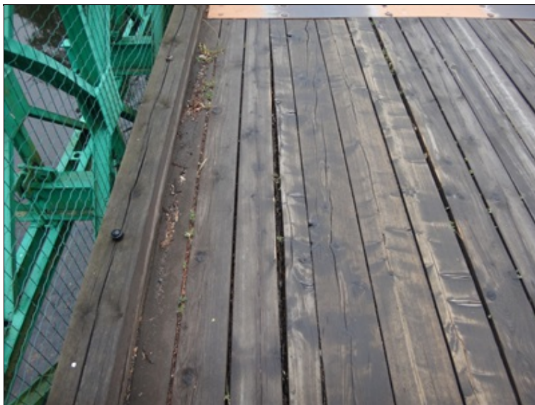
Poruchy jezdových prvků mostovky
