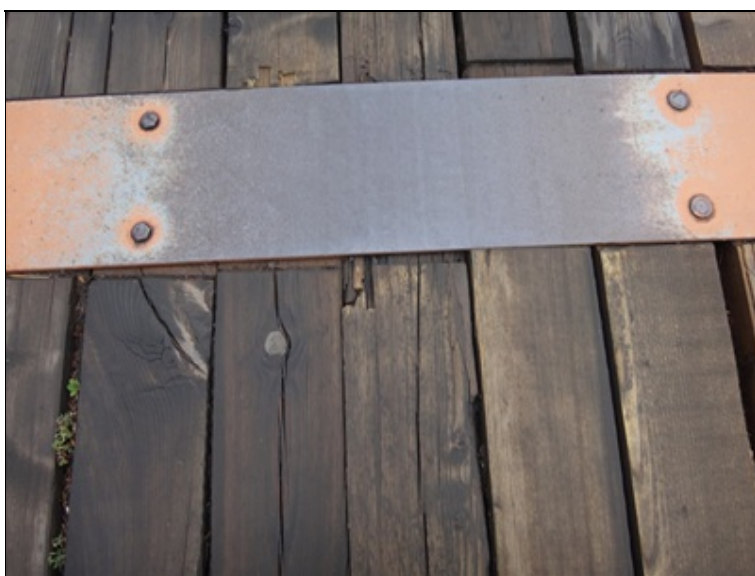
Poruchy jezdových prvků mostovky
