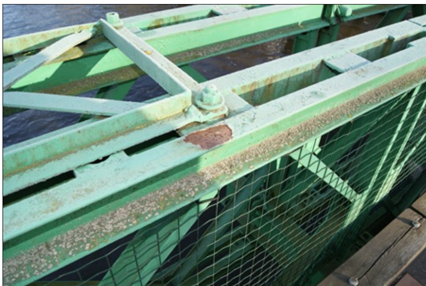
Lokální poruchy PKO NK a povrchová koroze
