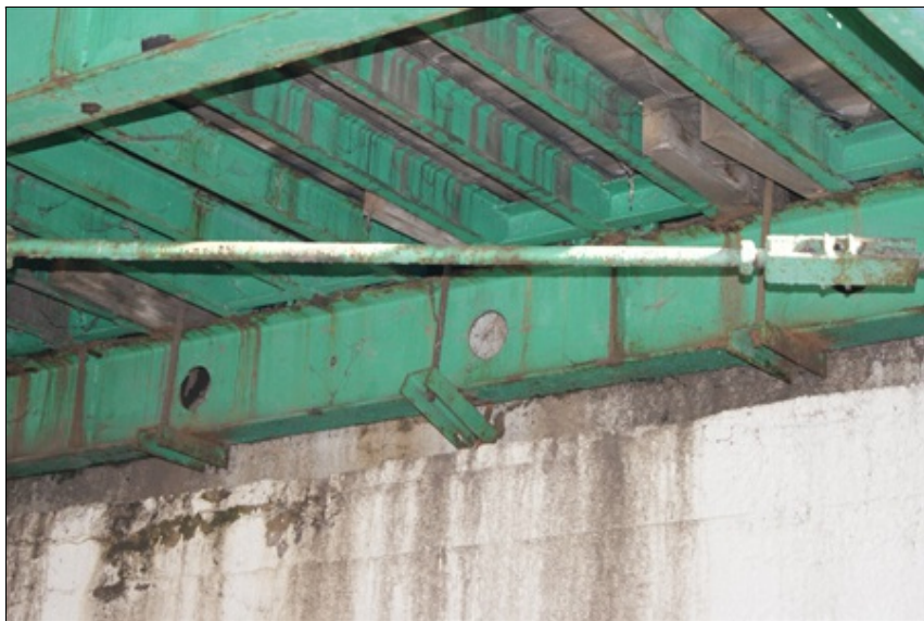
Uvolnění táhla uchycení přídržných plechů mostin u opěry 4
