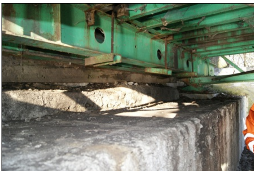
Pohled na úložný práh na opěře 1, uvolnění táhla uchycení přídržných plechů mostin
