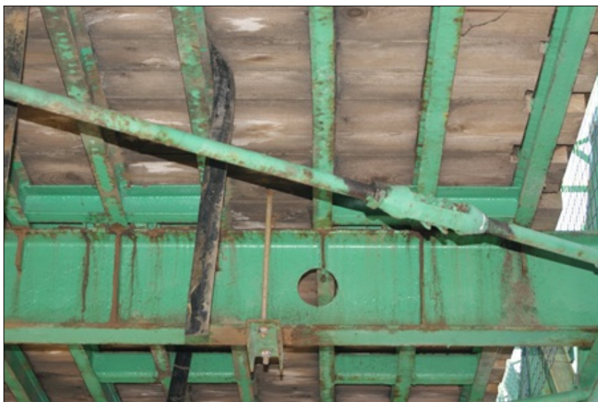
Vysunutí tlumících elastomerových pásků z polohy, v pohledu NK čtené lokální poruchy PKO a povrchová koroze
