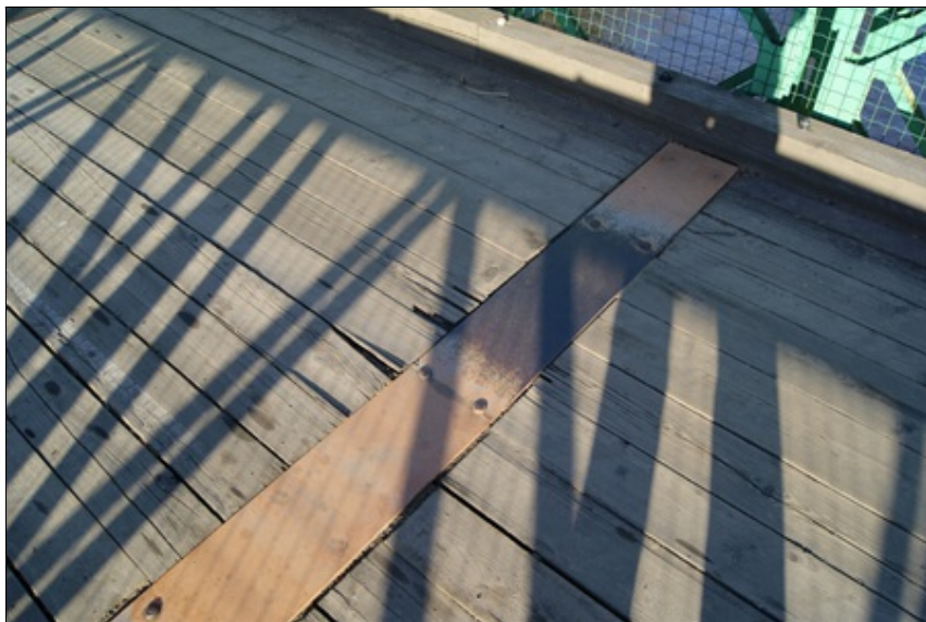
Lokální poruchy podélných pojezdových dřevěných prvků mostovky, poruchy PKO přídržných ocelových plechů
