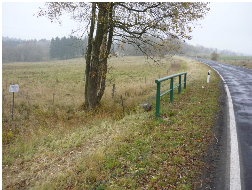
Obrázek 2 – Trubní propustek– pročištění propustku, ubourání stávajícího zábradlí, sanace betonových čel, pročištění vtoku a výtoku; pročištění příkopu a stržení krajnic
