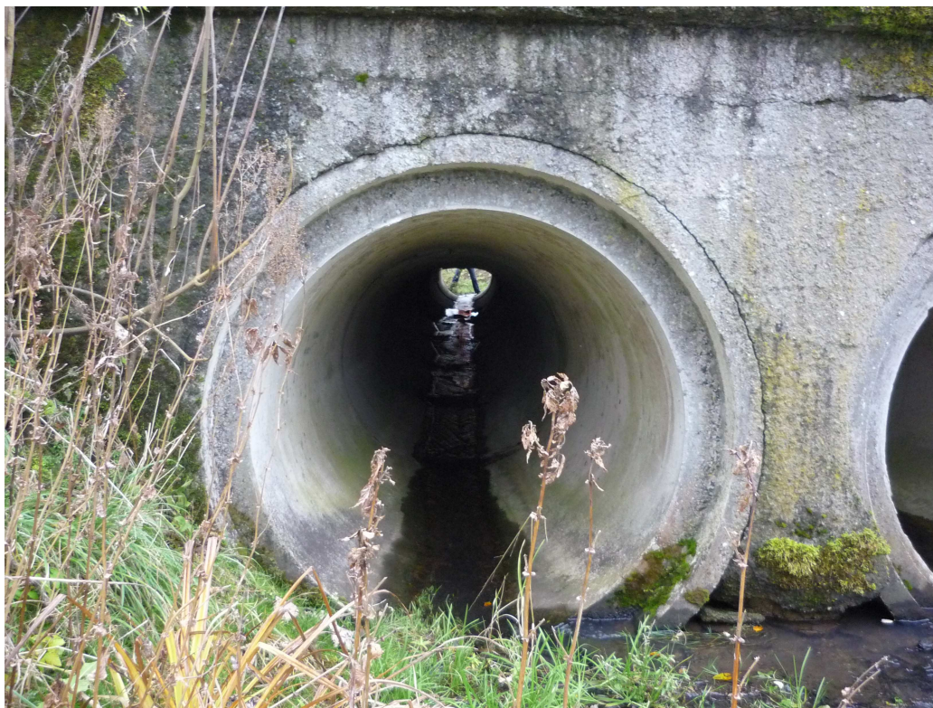
Obrázek 15 – Trubní propustek 2x DN 1400 – vzhledem k nevyhovujícímu technickému stavu navrženo vybourání stávajícího propustku a náhrada novým trubním propustkem 2x DN 1400 dl. 25,05 m s kolmými betonovými čely
