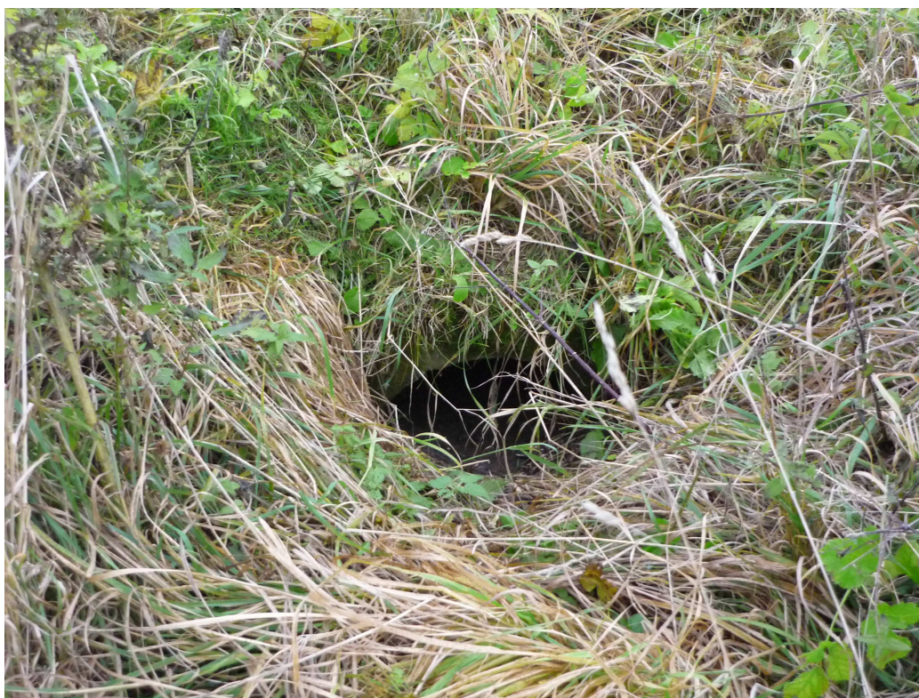
Obrázek 4 – Trubní propustek DN 400 – pročištění příkopu, pročištění propustku
