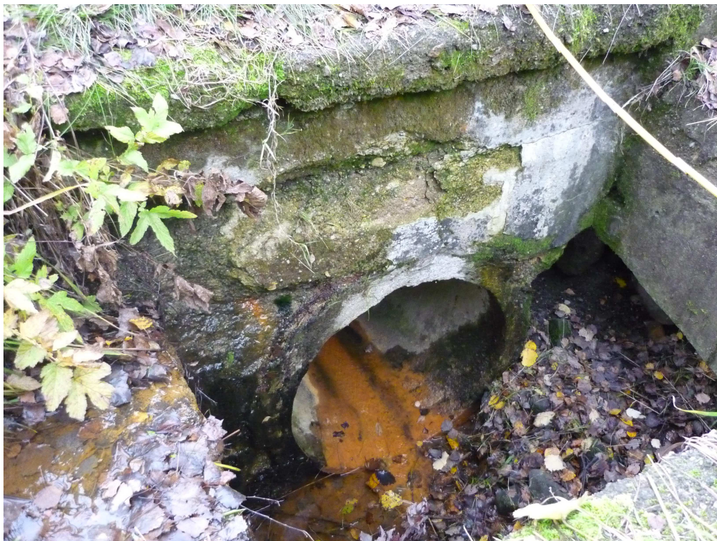
Obrázek 7 – Vtoková jímka propustku – pročištění a sanace objektu, doplnění zábradlí, pročištění propustku, pročištění příkopu a stržení krajnic, rozšíření krajnice a doplnění ocelového svodidla
