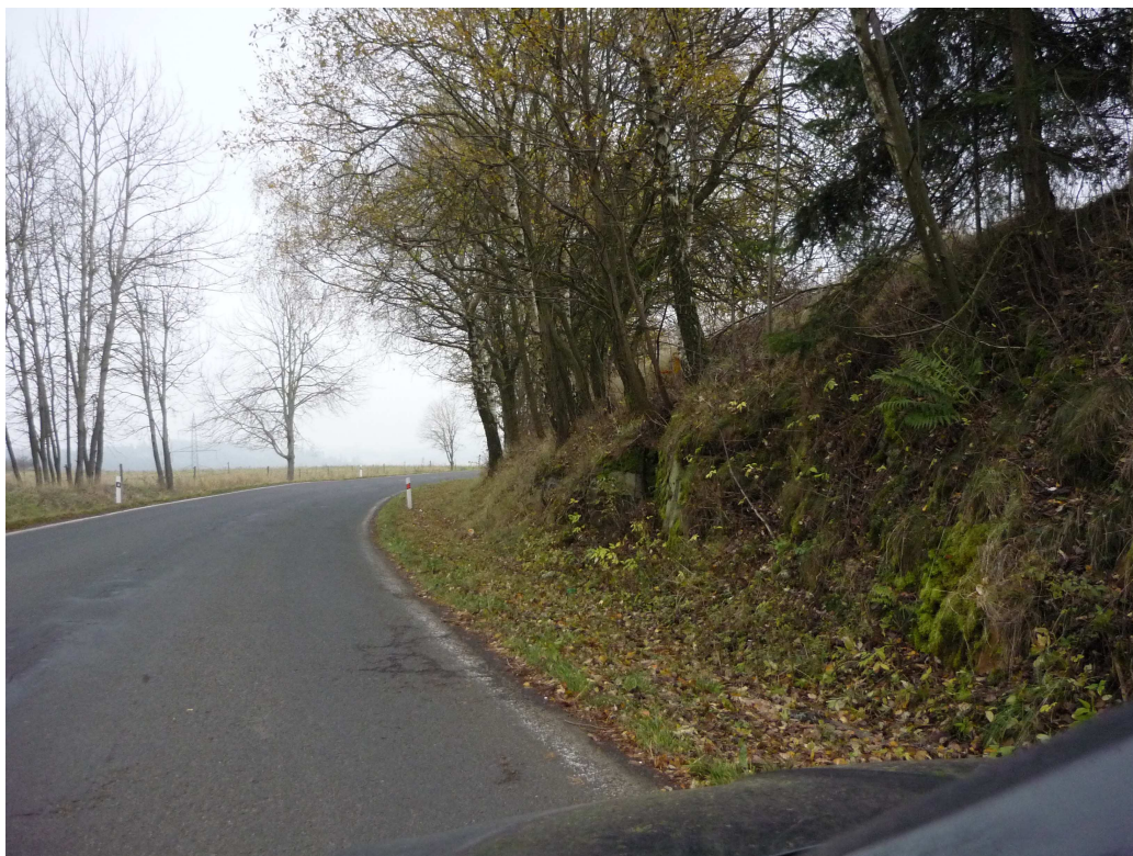
Obrázek 6 – Skála – pročištění příkopu a stržení krajnic, osazení příkopové tvárnice, rozšíření krajnice, doplnění ocelového svodidla
