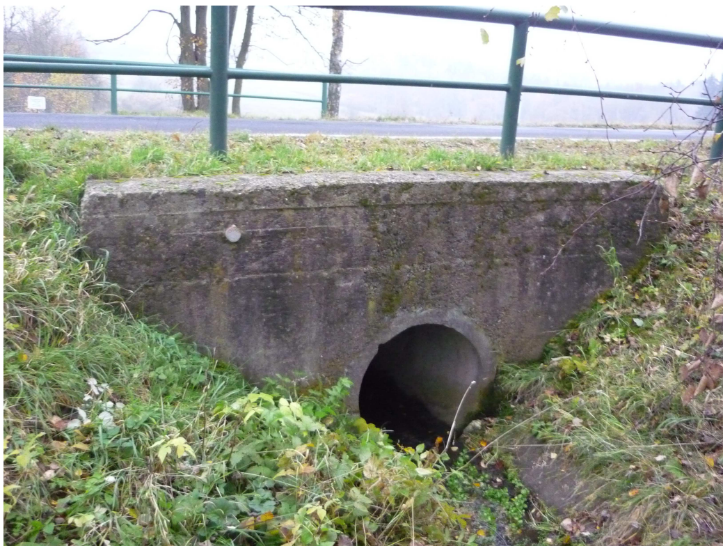
Obrázek 3 – Trubní propustek– pročištění propustku, ubourání stávajícího zábradlí, sanace betonových čel, pročištění vtoku a výtoku, doplnění nebo výměna odláždění; pročištění příkopu a stržení krajnic
