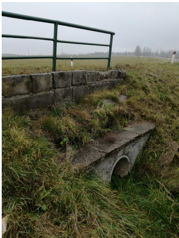
Obrázek 14 – Trubní propustek – sanace betonového čela, pročištění propustku, doplnění nebo výměna odláždění a zpevněného příkopu, nová opěrná zeď, ubourání stávajícího zábradlí, stržení krajnic, rozšíření a doplnění nového ocelového svodidla
