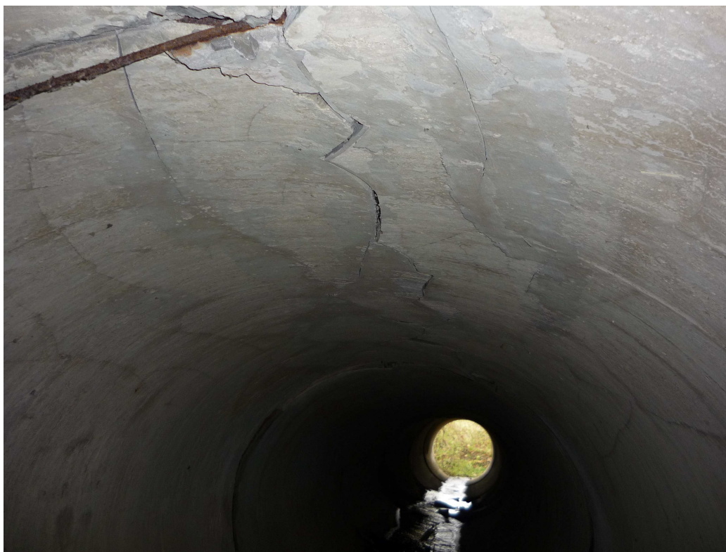
Obrázek 16 – Nevyhovující technický stav stávajícího trubního propustku 2x DN 1400
