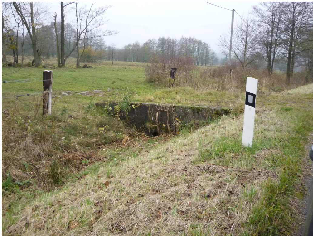
Obrázek 11 – Sjezd na pozemek s trubním propustkem DN 400 – ubourání betonových čel, přidání nových kusů se šikmým čelem, pročištění propustku; pročištění příkopu a stržení krajnic
