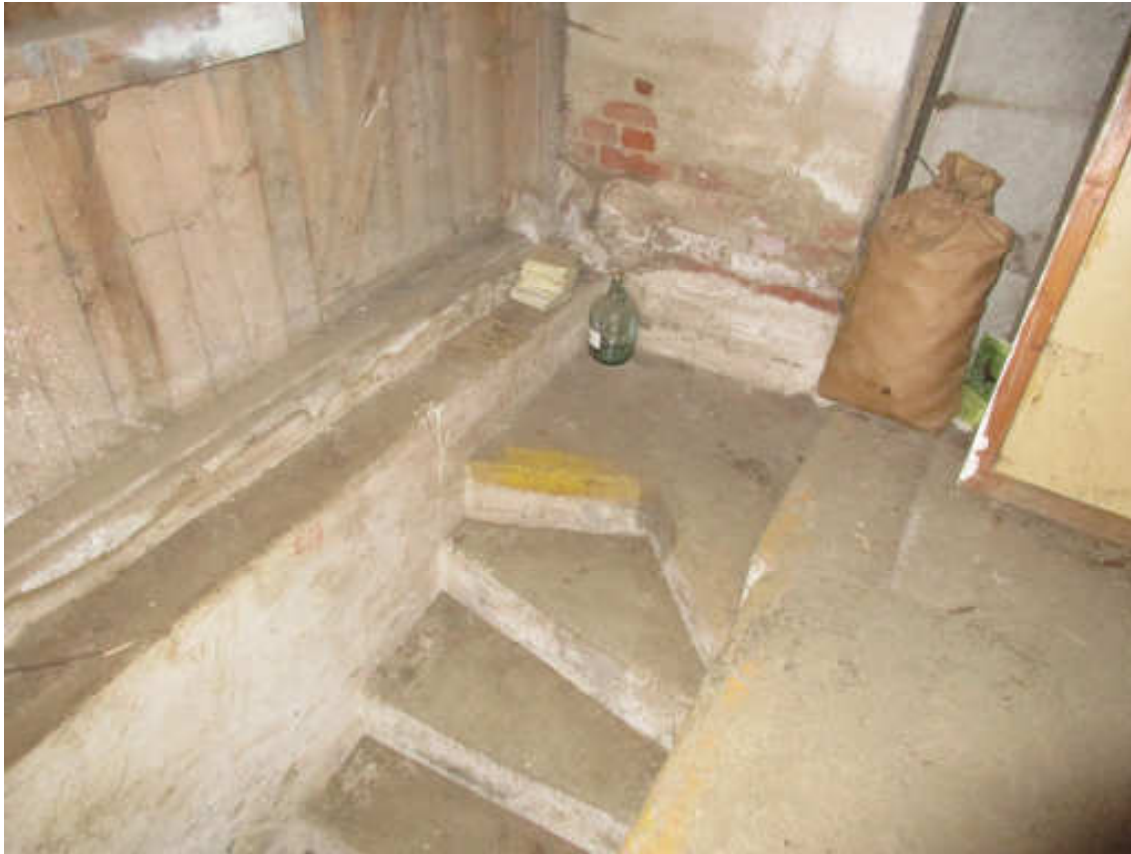
Schodiště do 1.PP
