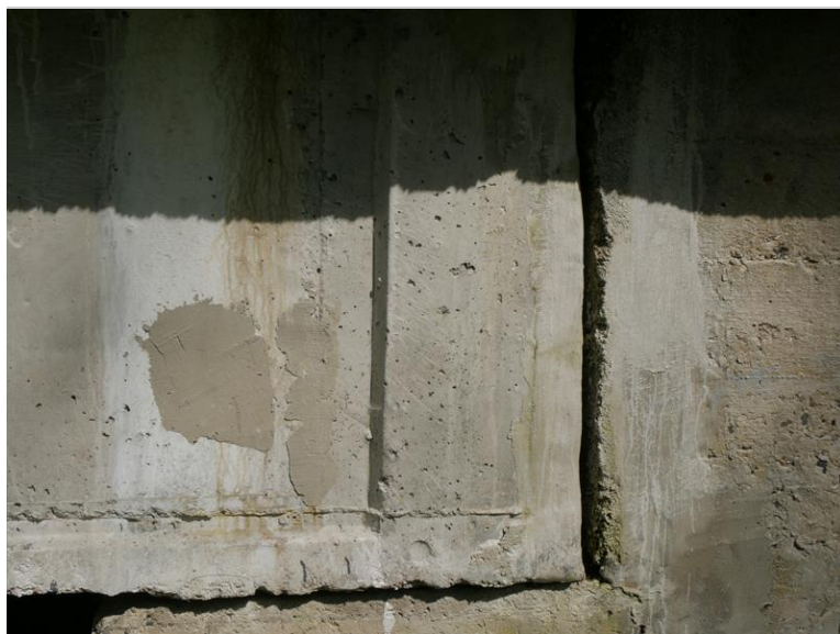
detail uložení nosníku vpravo OP3
