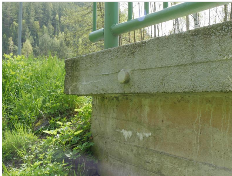
nivelační značka na římse
