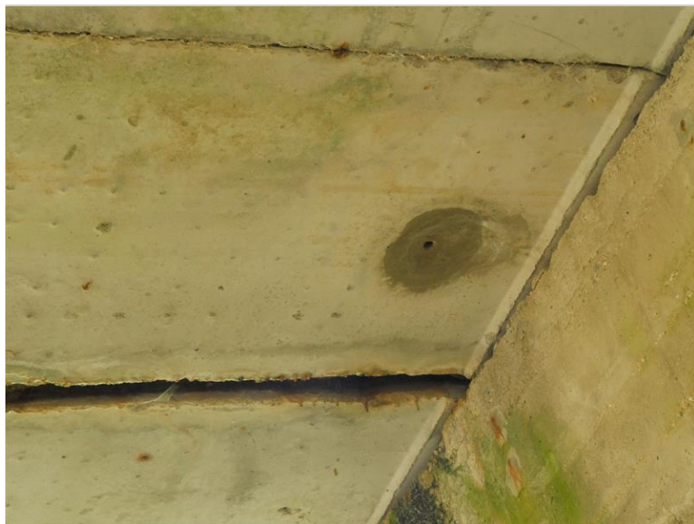
odvrtané nosníky
