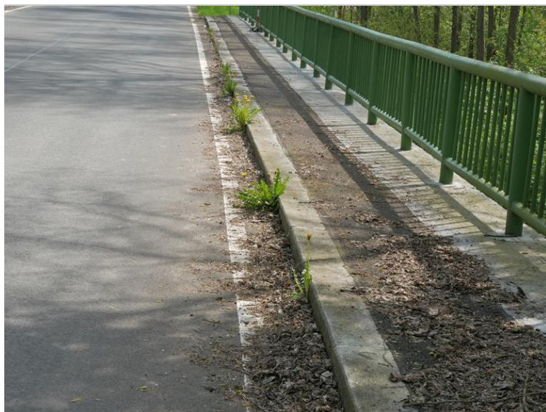
nečistoty v krajích, uchycená vegetace
