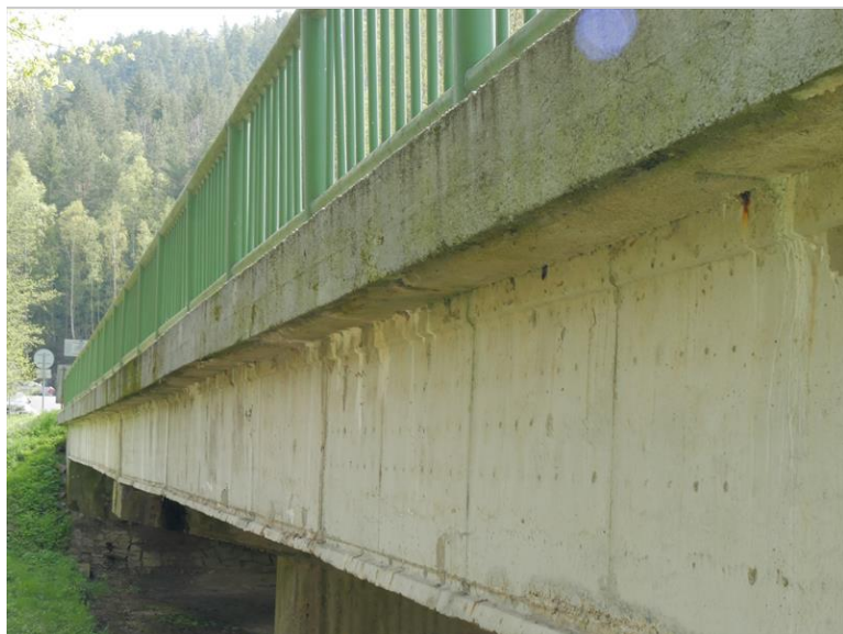
levé čelo NK zatékání z pod římsy
