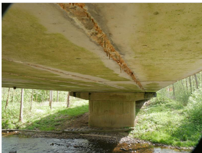
zatékání do spáry mezi NK - krápníkové výluhy
