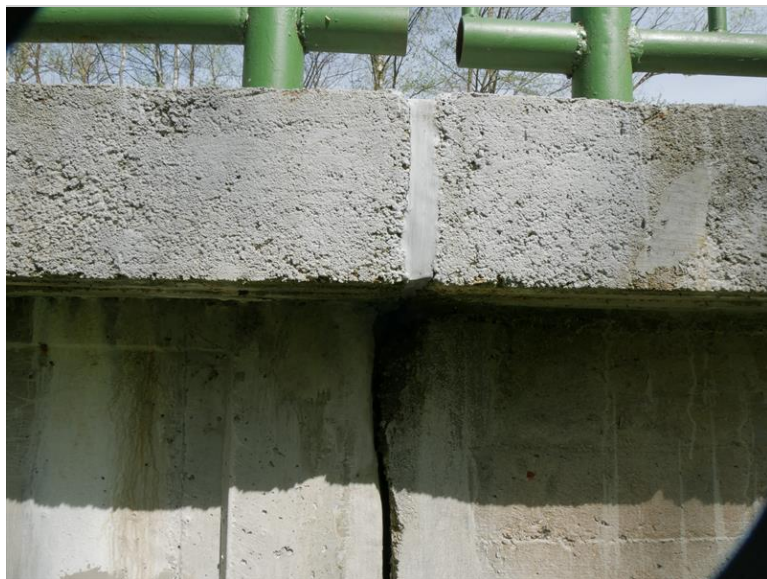
utěsnění římsy vpravo nad OP3
