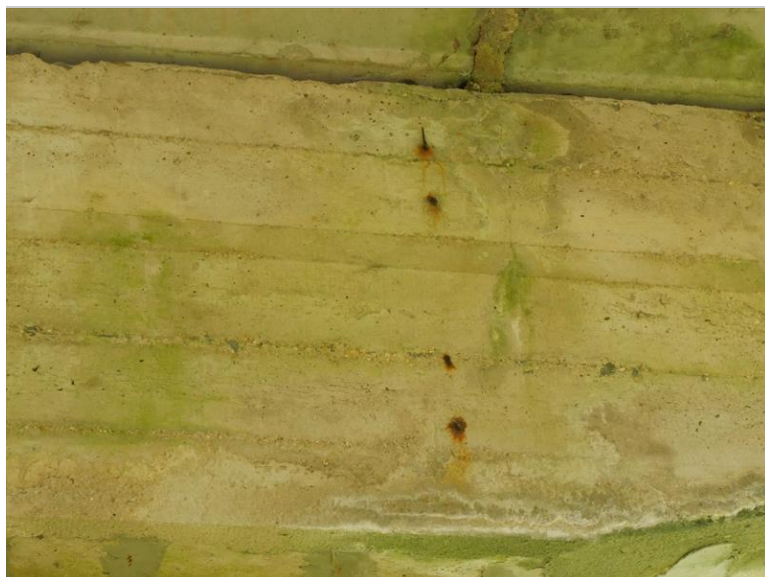
korozí rádlovací výztuže
