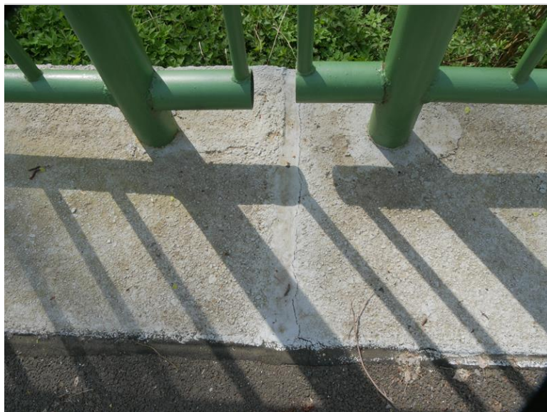
dilatace v římse nad OP3
