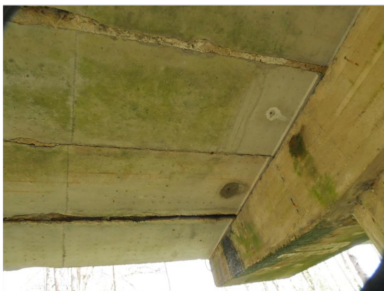
zatékání na stativu P2
