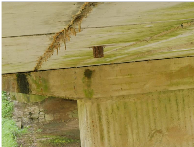
zatékání vlevo na stativo P2
