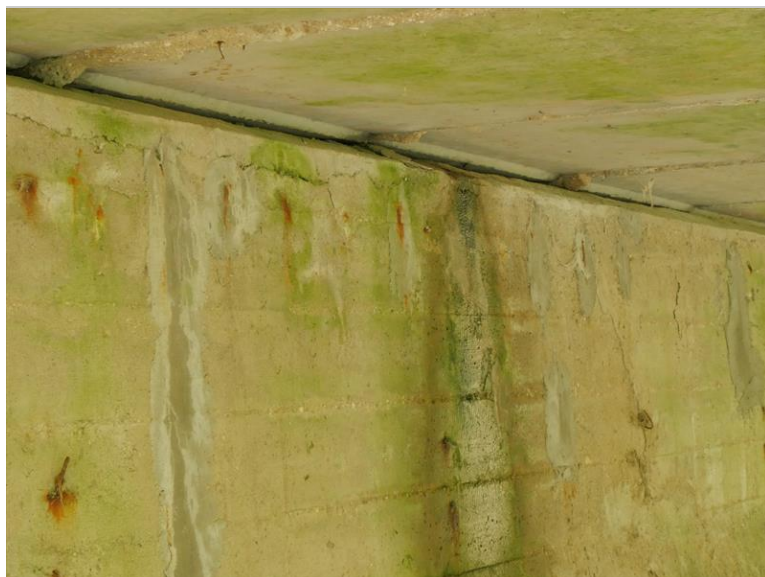
zatékání z pod NK na čelo opěry OP1; rezavé šmouhy v místě koroze rádlovací výztuže
