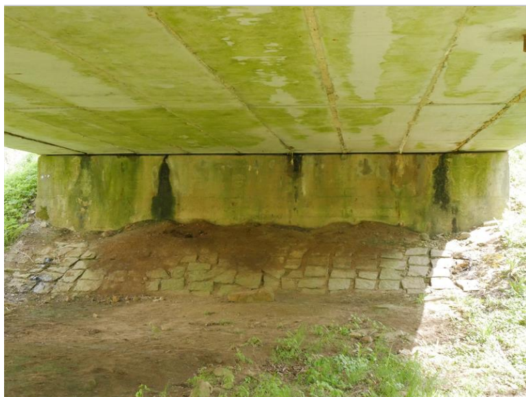
pohled na OP3 - zatékání z pod nosníků
