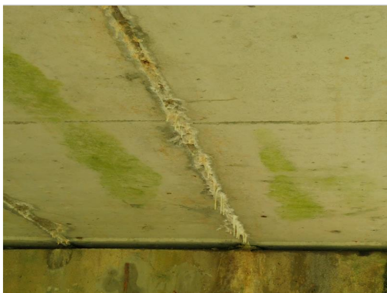
krápníkové výluhy cementového mléka ze spáry mezi nosníky
