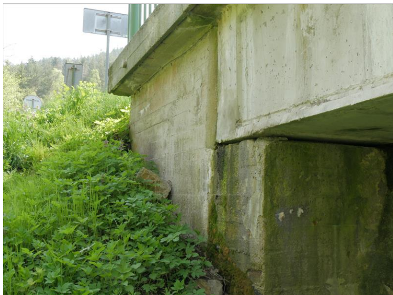
levé křídlo OP3 - zatékání
