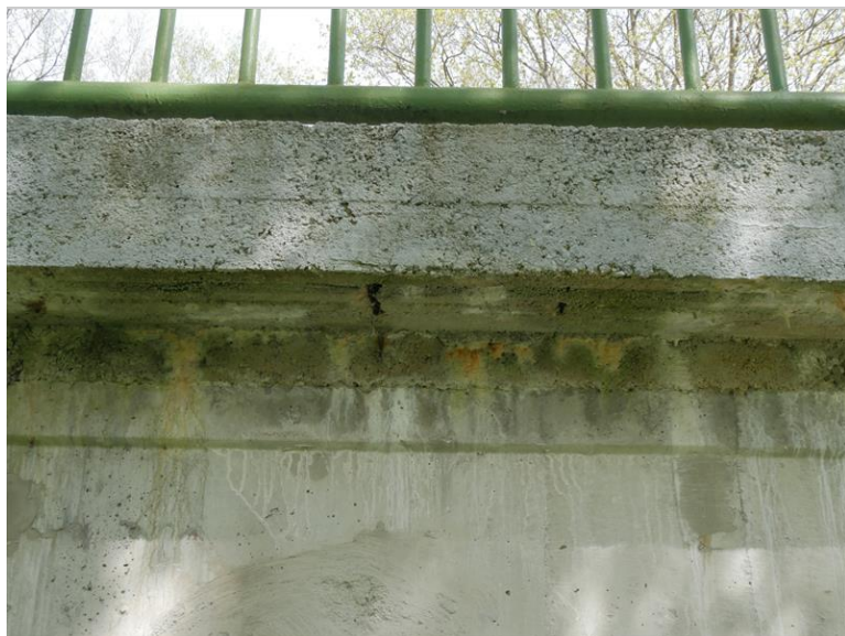
zatékání z pod římsy na čelo NK
