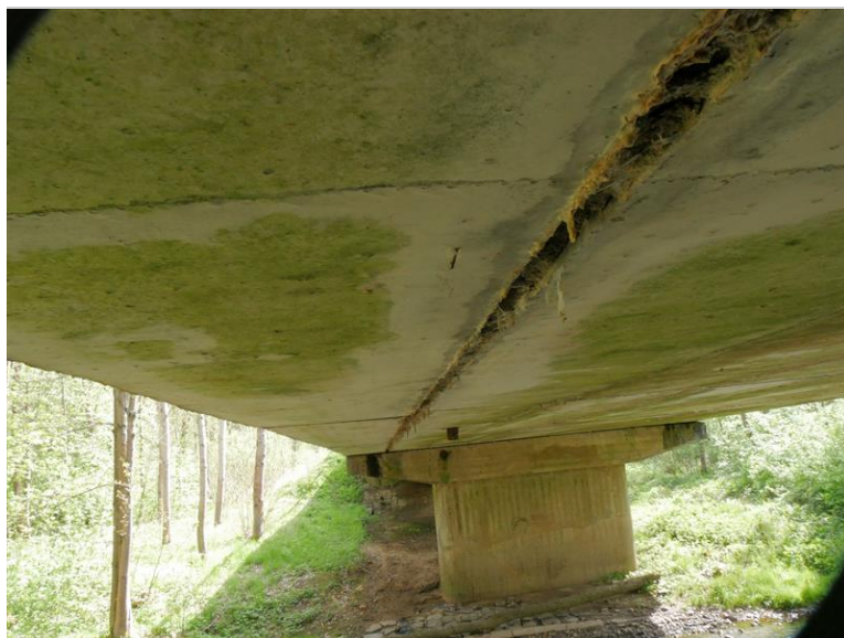
zatékání do spáry mezi nosníky vlevo
