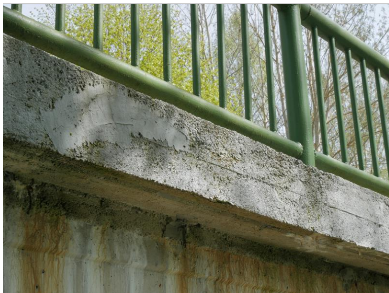
lokální sanace římsy
