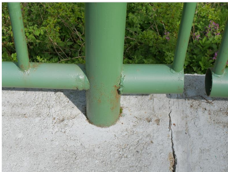
koroze ocelových prvků zábradlí+ dilatační spára nad OP3
