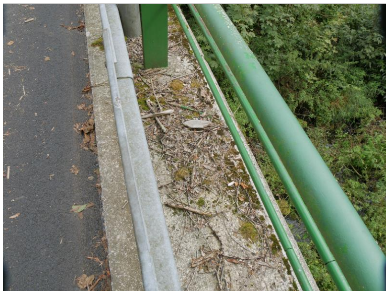
nečistoty na římse
