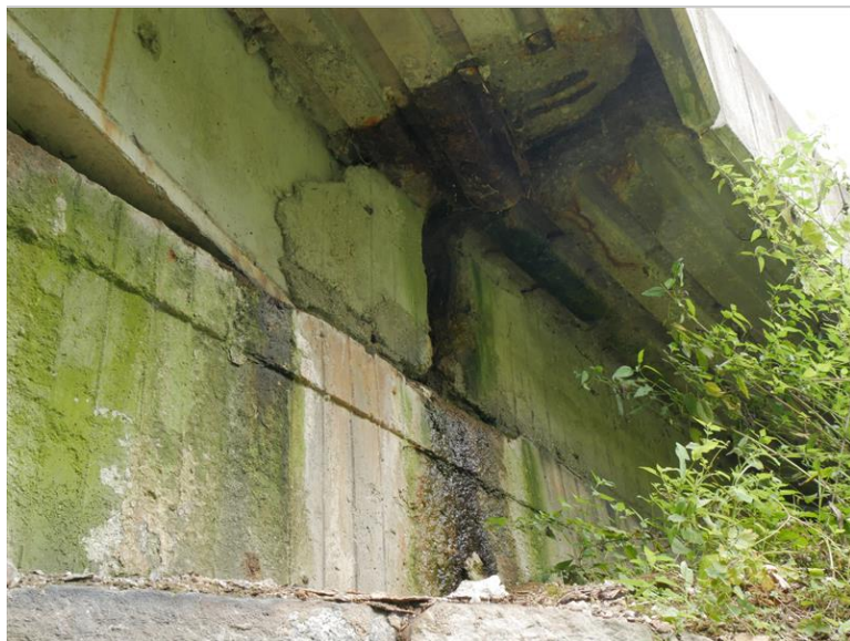
zatékání do spáry mezi NK a ZZ vpravo OP2
