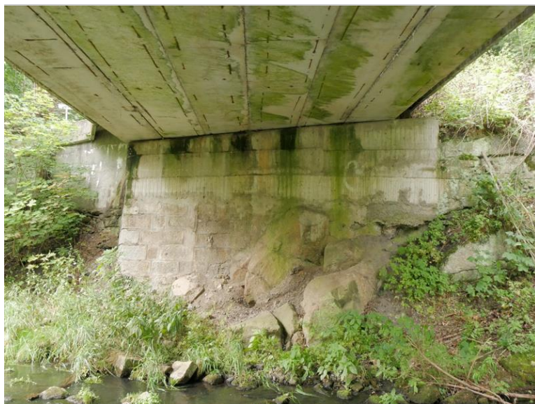
pohled na OP2 s viditelnými stopami po zatékání vpravo
