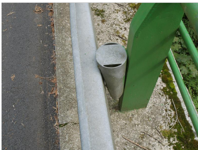
deformovaný hrnec svodidla vpravo
