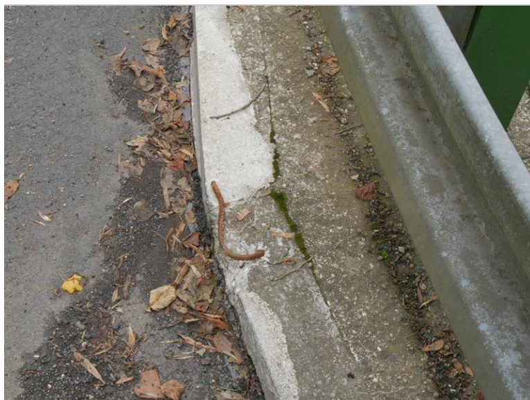
vyčnívající výztuž z betonového obrubníku
