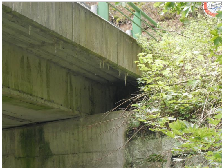
zatékání mezi NK a římsovým prefabrikátem
