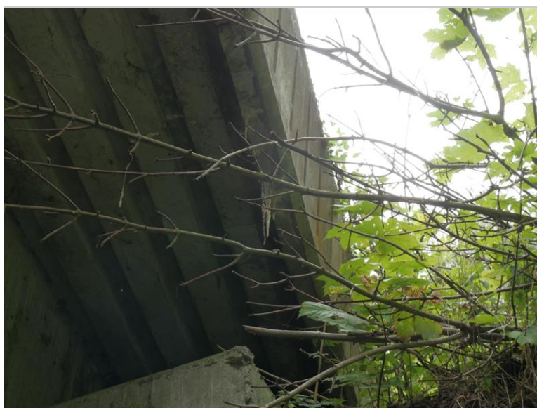
krápníkové výluhy cementového mléka v krajích spřažené desky
