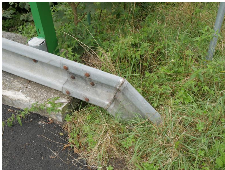
koroze spojovacího materiálu svodnice
