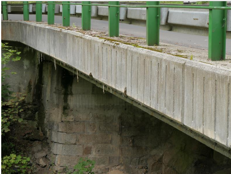
poruchy lícových prefabrikátů
