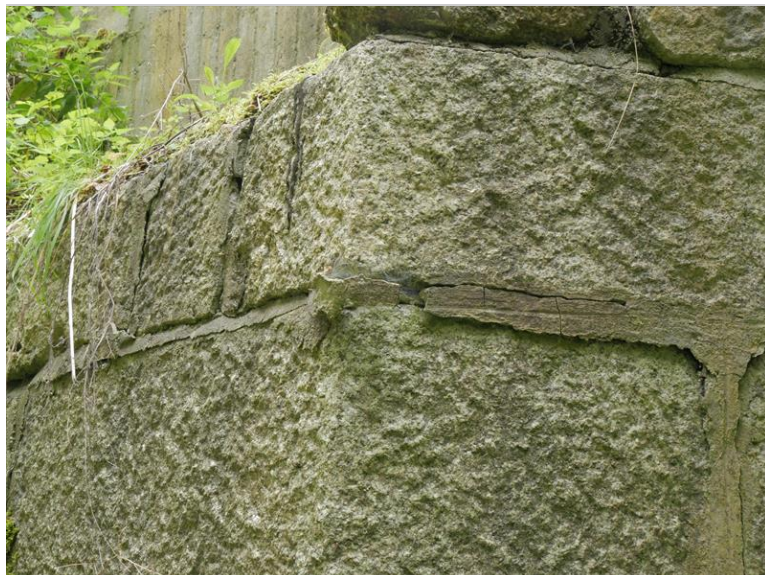
poruchy spárování kamenného zdiva
