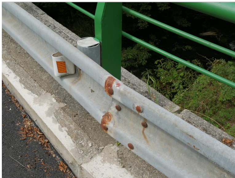
korozí svodnice
