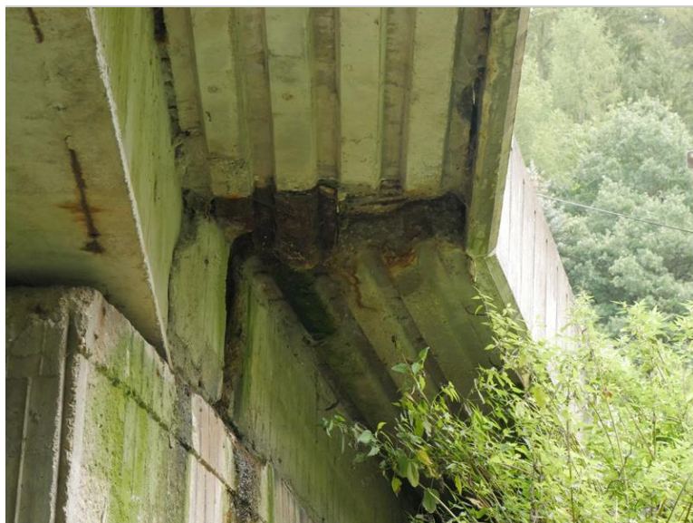
detail dilatační spáry vpravo na OP2
