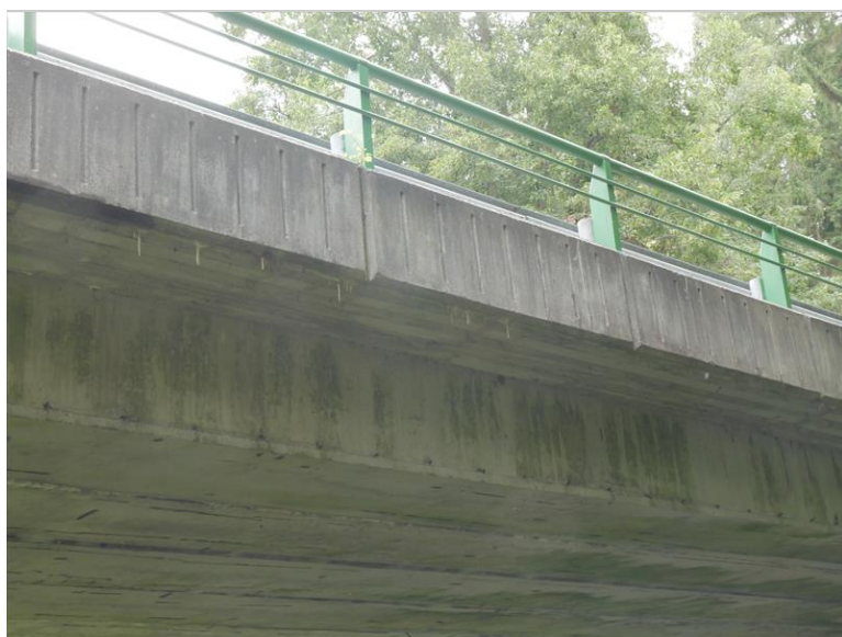
zatékání mezi NK a římsovým prefabrikátem
