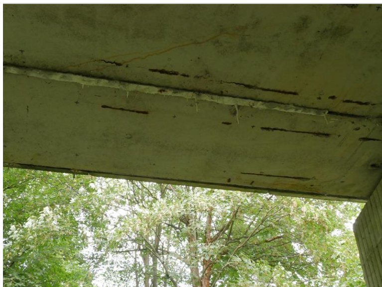
krápníkové výluhy cementového mléka vlevo u OP2
