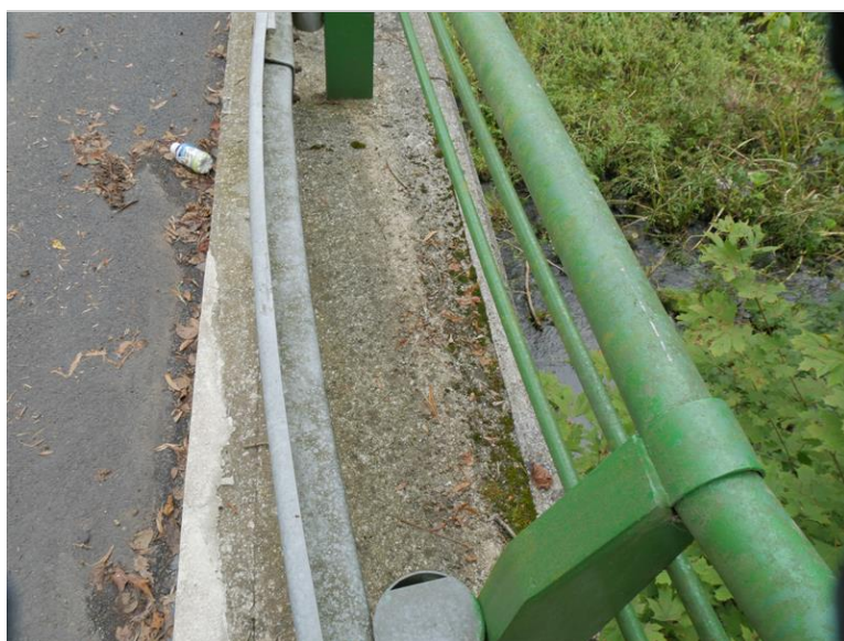
uchycené měchy na horní ploše římsy
