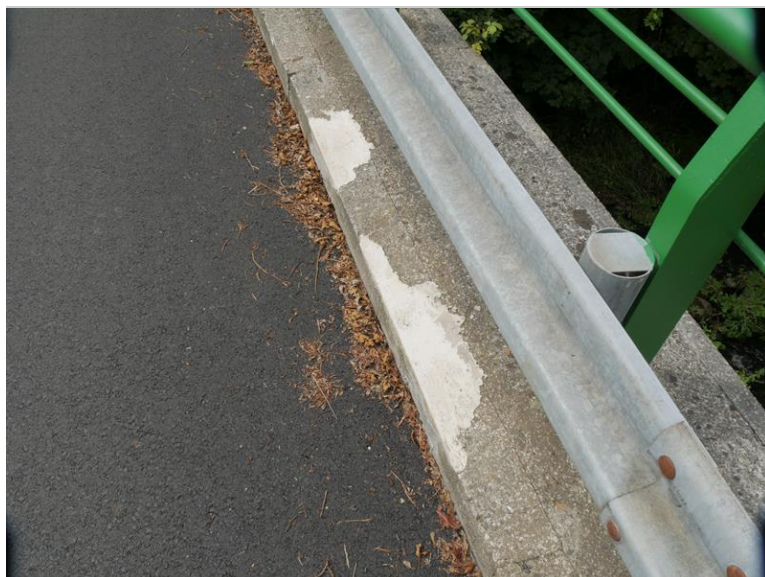
sanované povrchy chodníkového prefabrikátu
