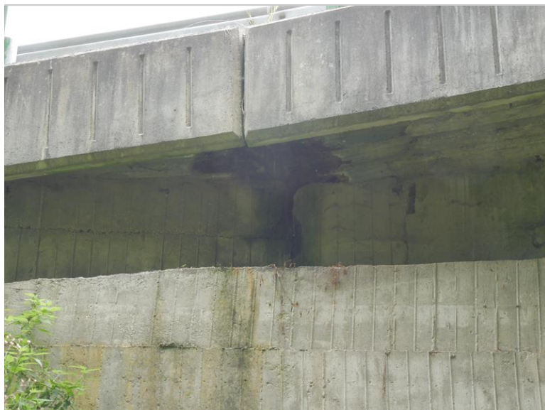
zatékání vlevo na OP2
