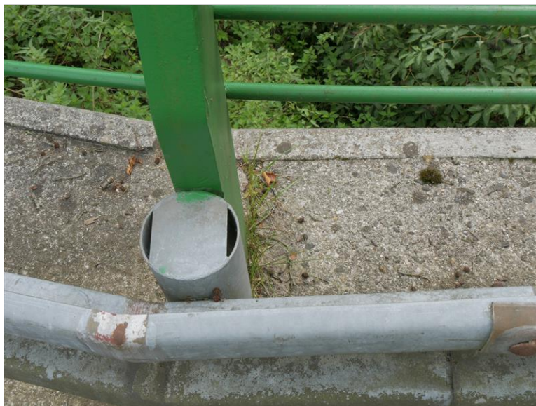
lokální koroze ocelových prvků svodnice a spojovacích prvků
