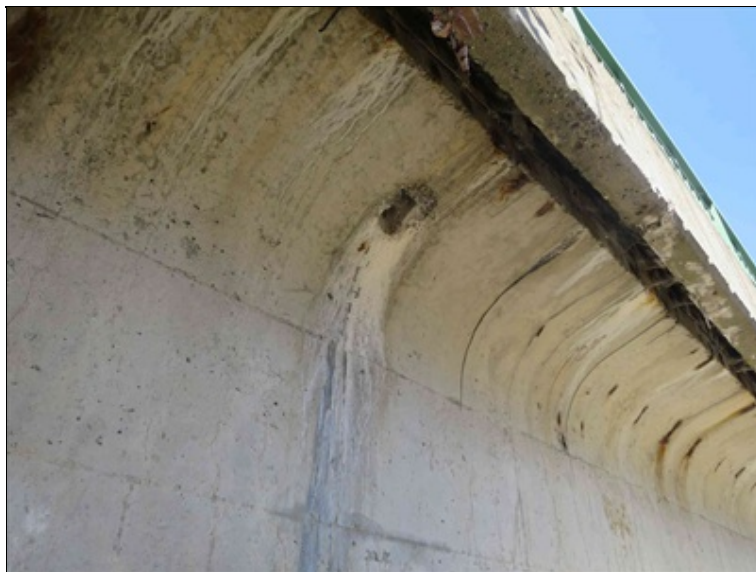
stopy po průsaku s výluhy pojiva montážním otvorem u horní pásnice 1. nosníku
