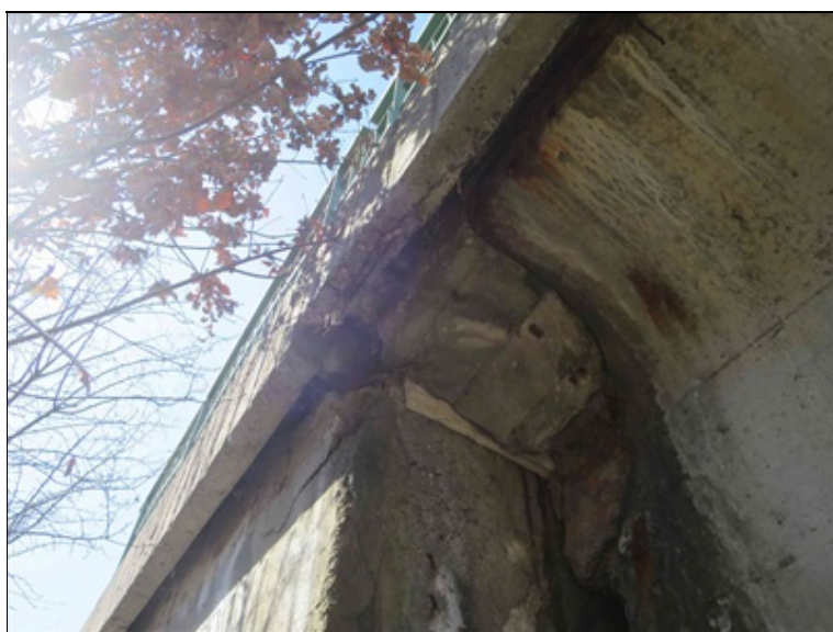
stav levé části mostu v oblasti dilatační spáry nad O2
