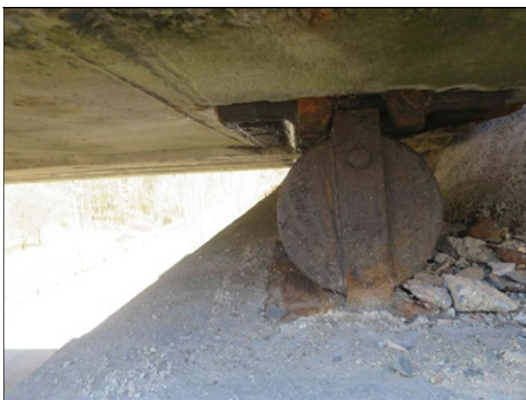
koróze 9. ložiska na O2
