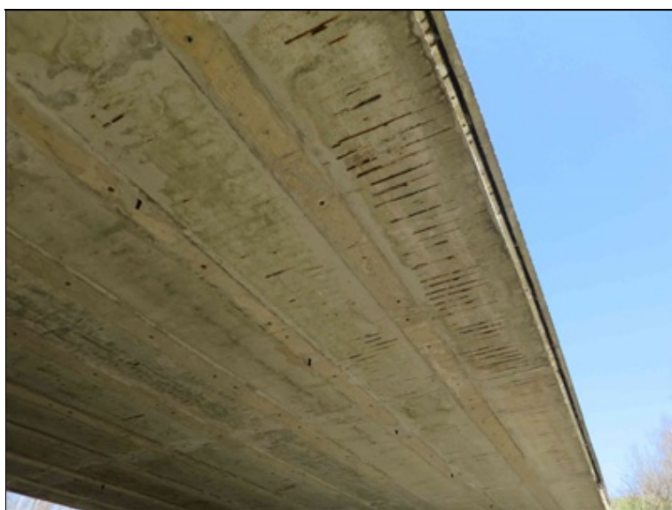
DDTO koroze konstrukční výztuže na spodním líci 1. nosníku
