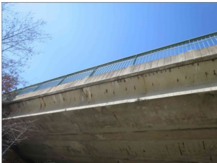
koroze konstrukční výztuže na vnějším líci nosníku
