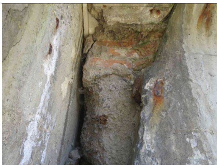
rozpad dobetonávky a vyzdívky čela NK a koroze kotvy předpinací výztuže ve stojně 1. nosníku nad O2
