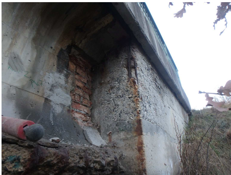
Výrazná degradace betonu a koroze výztuže závěrné zídky a křídla
