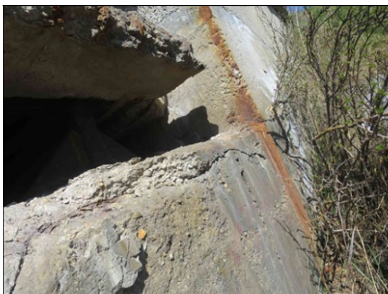
degradace betonu ÚP O1 v levé hraně
