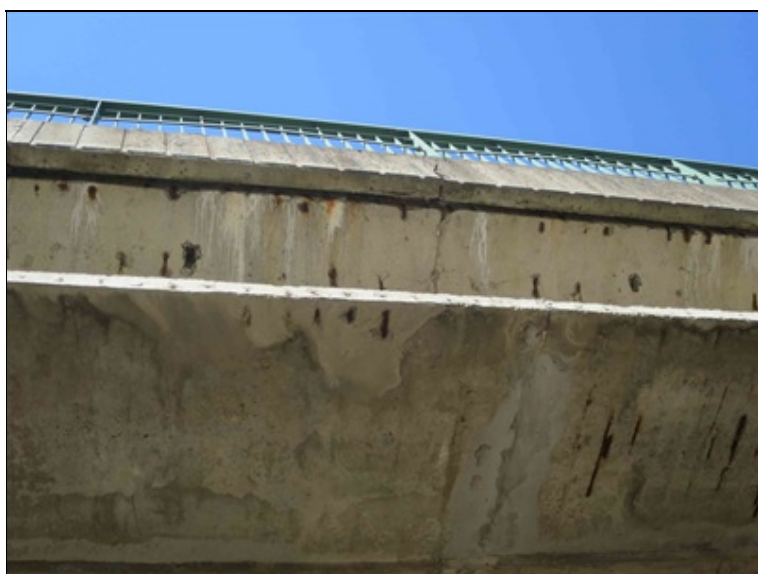
detail průsaků s výluhy pojiva z izolace na nosník
