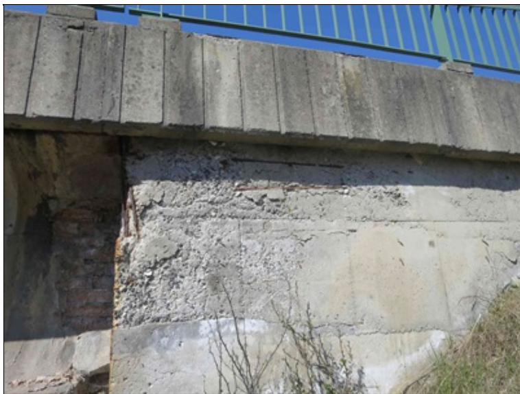
hloubková degradace betonu na levém boku ZZ O1
