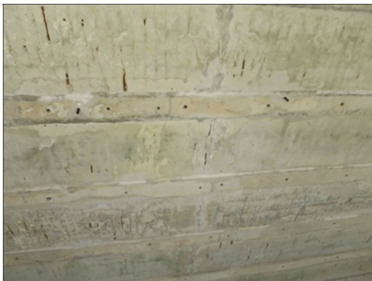
drobné stopy po průsacích sparami mezi korálky jednotlivých nosníků
