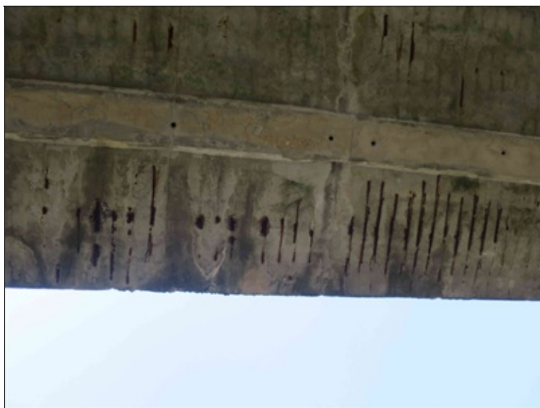
výrazné stopy po průsacích a koroze výztuže na spodním líci 1. nosníku
