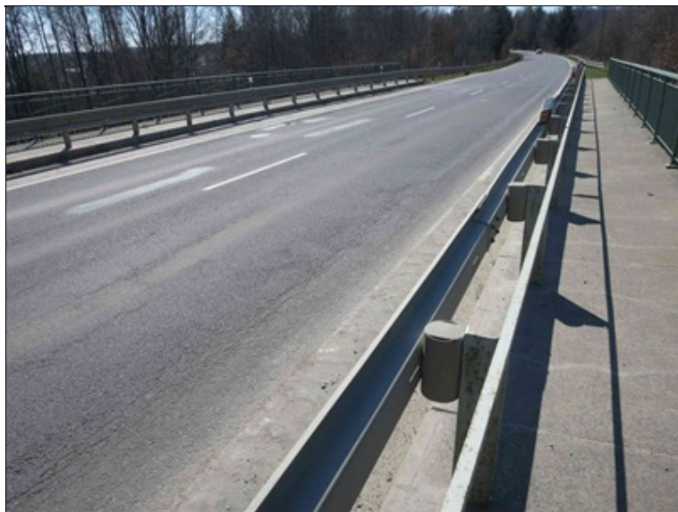
kryt vozovky je deformovaný
