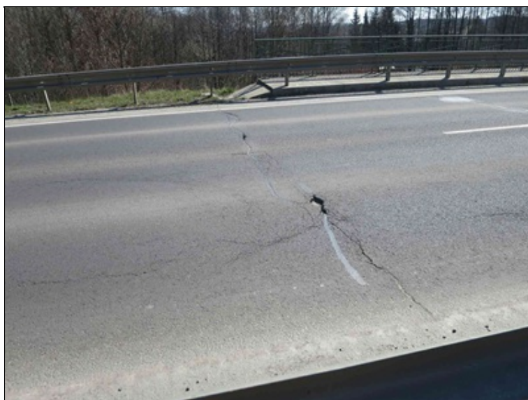
příčné trhliny v krytu vozovky před O1
