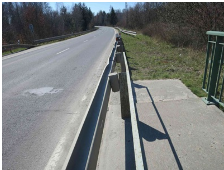
mírná deformace svodnice
