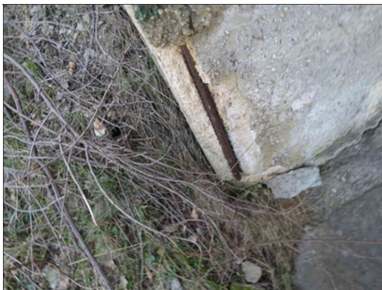
odražená hrana krycí vrstvy v hraně opěry 1 nad korodující výztuží
