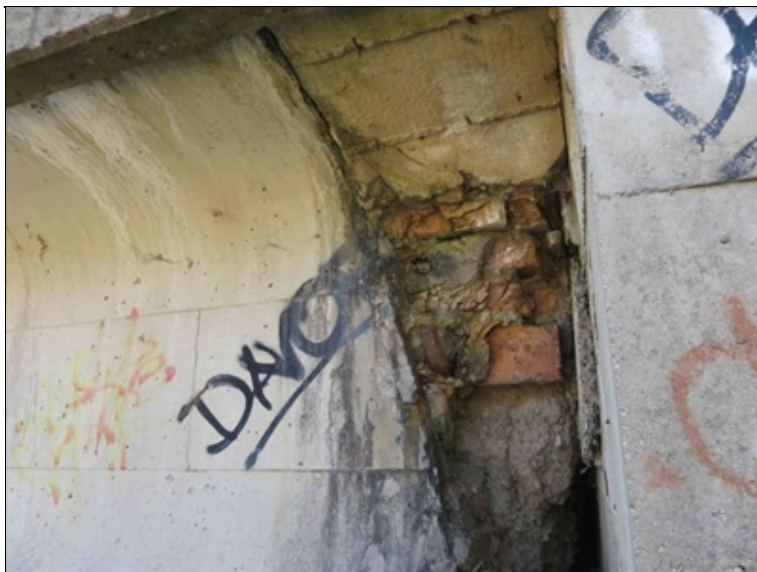
rozpadající se dobetonávka a vyzdívka čela NK nad O2 zprava
