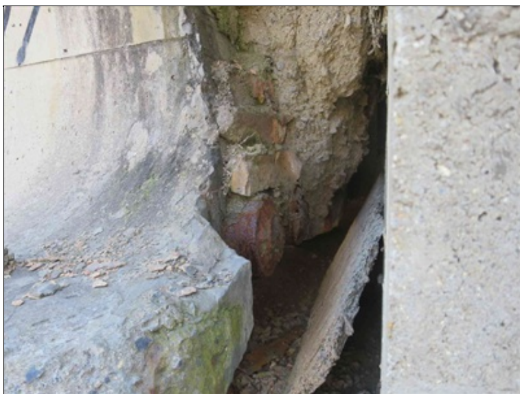
obnažení kotvy předpínací výztuže v dolní pásnici 9. nosníku nad O2
