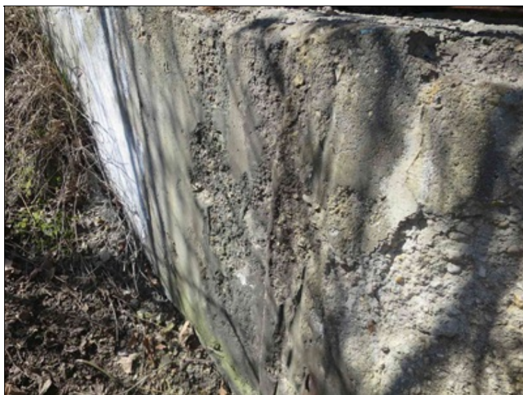
hloubková degradace betonu na levém boku ÚP O2
