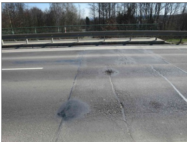
kryt vozovky v oblasti podpovrchového mostního závěru nad O2
