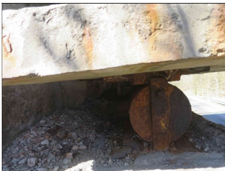
korozí 1. ložiska na O2, výrazné nánosy na ÚP O2
