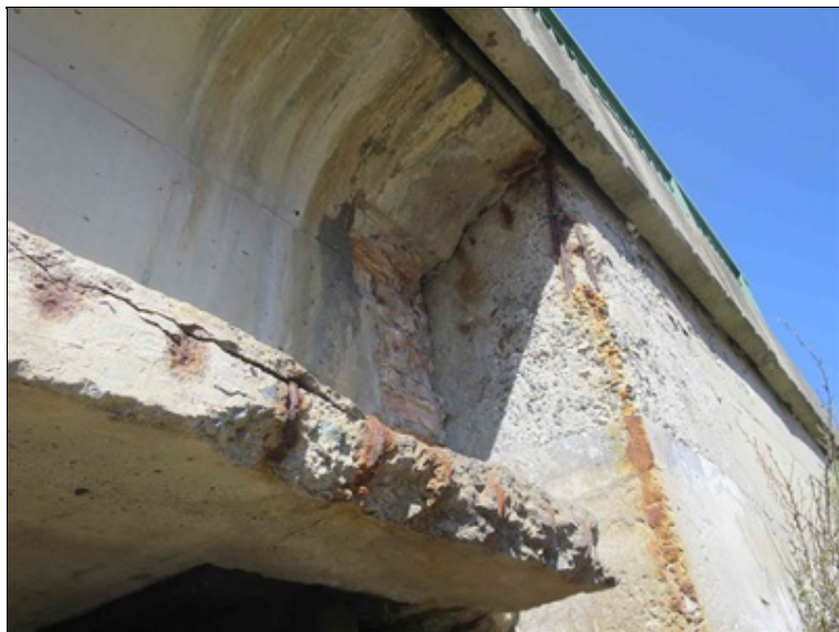
rozpad betonu a koroze konstrukční výztuže 1. nosníku nad O1
