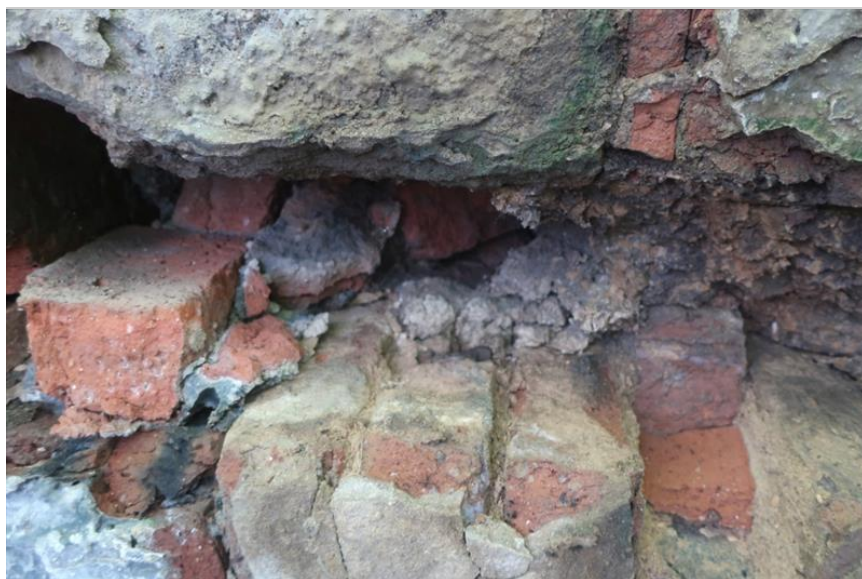
DTTO - detail rozpadu cihelného zdiva
