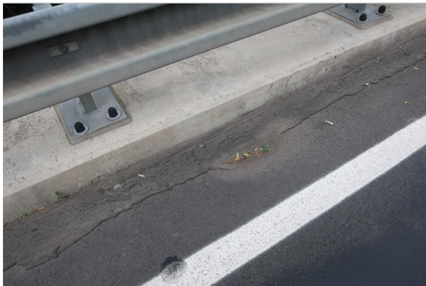
deformace krytu vozovky podél pravé římsy
