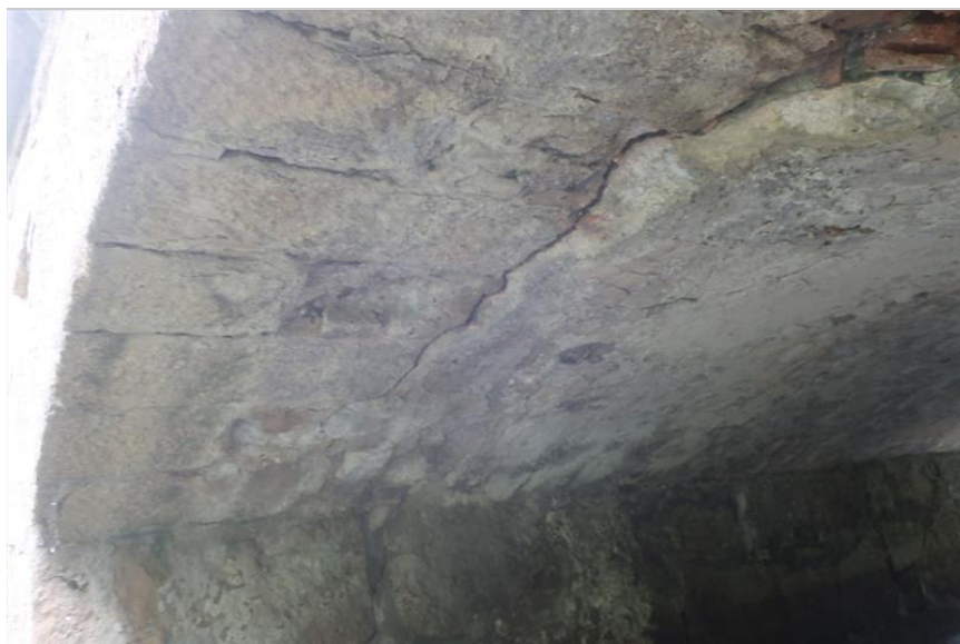
podélná trhlinka mezi cihelným zdivem klenbového pasu a ztužujícím kamenným pasem při pravé straně nad opěrou O2
