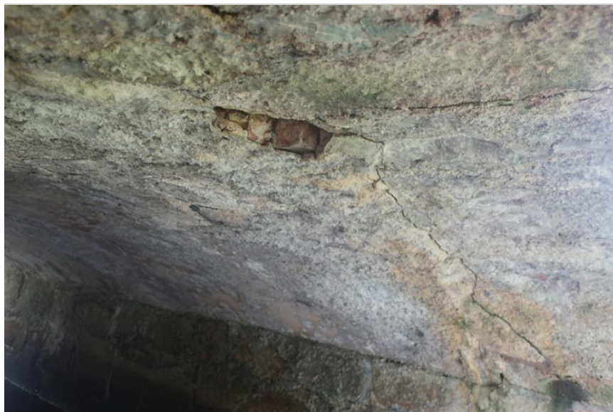
podélná trhlina mezi cihelným zdivem klenbového pasu a ztužujícím kamenným pasem při levé straně nad opěrou O1
