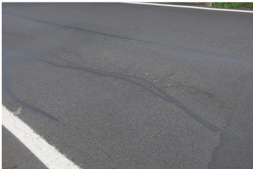
trhliny a deformace v krytu vozovky
