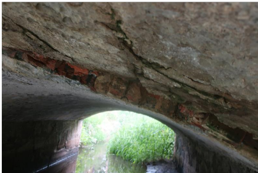
DTTO - pohled na deformované cihelné zdivo vůči zdivu kamennému
