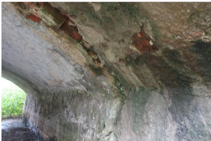
rozpad cihelného zdiva klenbového pasu podél ztužujícího kamenného pasu při pravé straně nad opěrou O1
