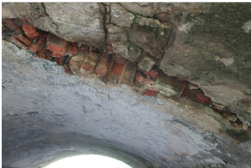
rozpad cihelného zdiva klenbového pasu podél ztužujícího kamenného pasu ve vrcholu klenby, deformace klenbového pasu z cihelného zdiva
