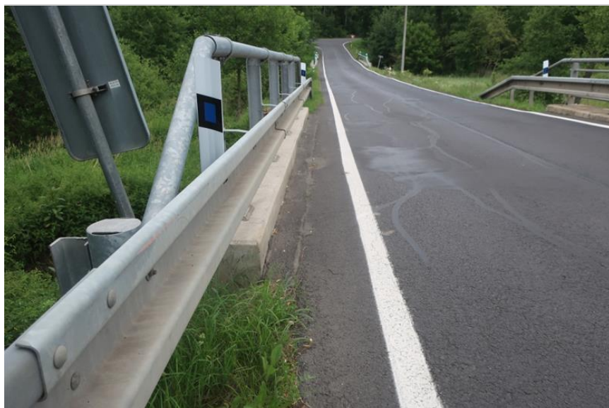
nad havarijní částí klenbového pasu je zjevná deformace krytu vozovky
