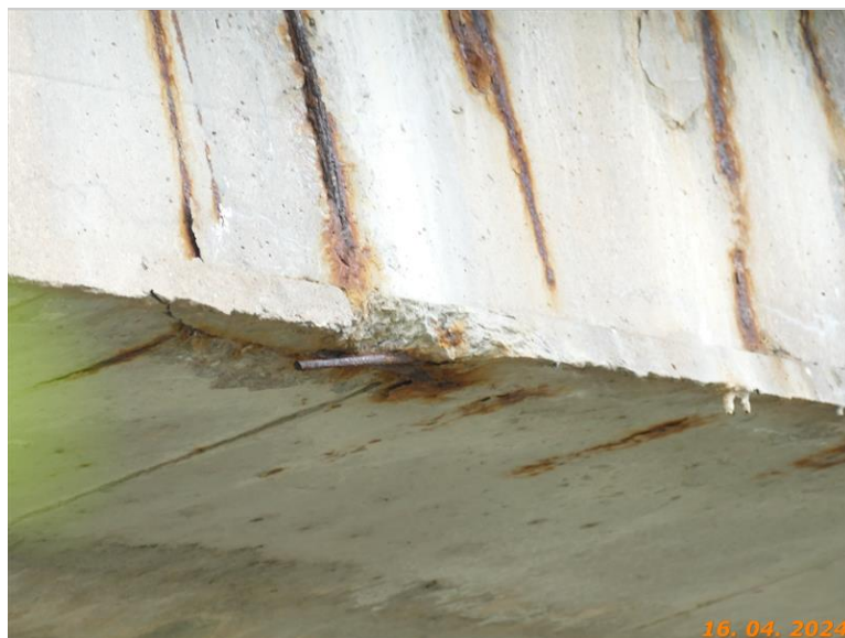
Degradace betonu nosníku na levém boku
