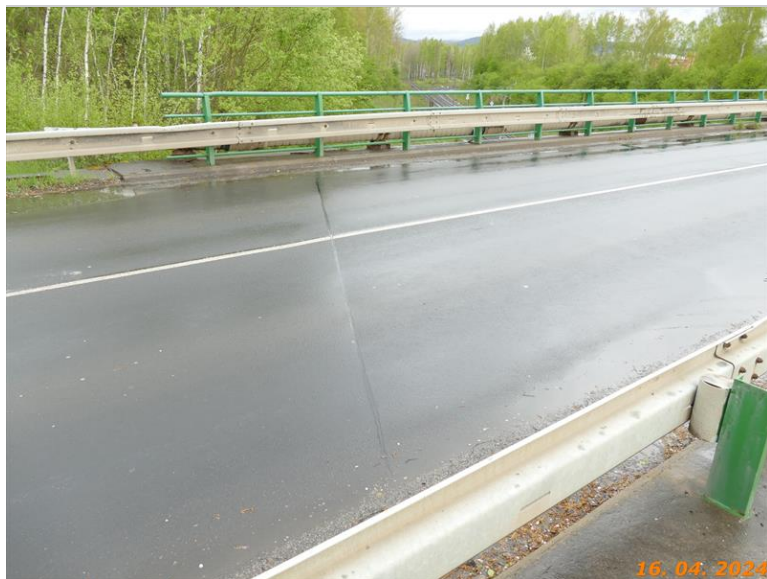
Pohled na levou římsu a deformovanou svodnici
