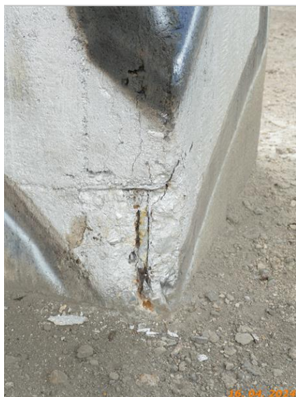
Odhalená výztuž na sloupu P3
