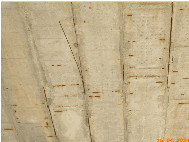
Koroze výztuže na nosnících v 3. poli
