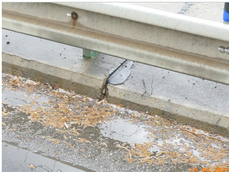
Dilatační spára pravé římsy
