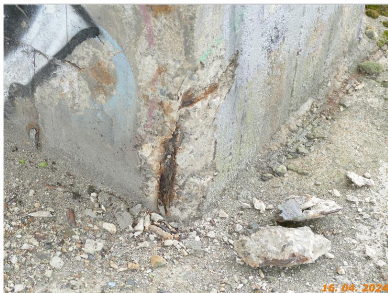
Koroze výztuže v patě sloupu
