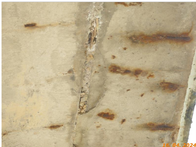
Degradace spáry u levého nosníku v 1. poli
