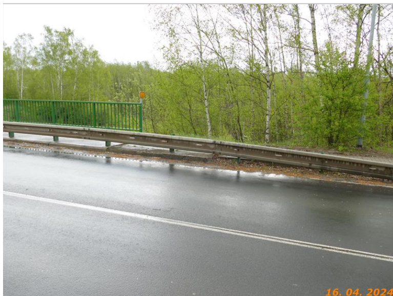
Pohled na pravou římsu a ukončení svodidla nad OP1
