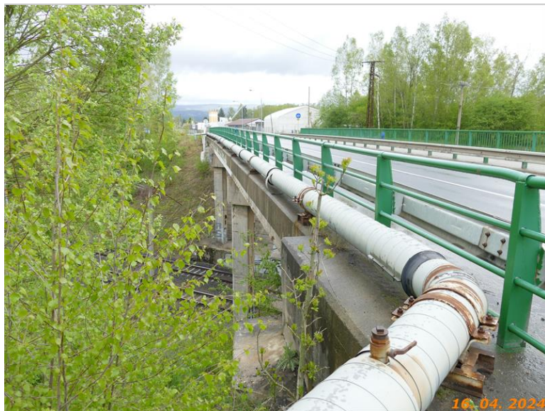
Cizí zařízení - vedení u levé římsy
