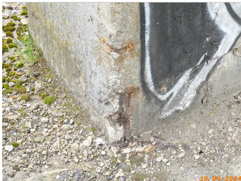
Koroze výztuže v patě sloupu.JPG
