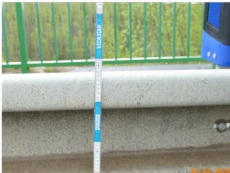
Nedostatečná výška svodnice vpravo
