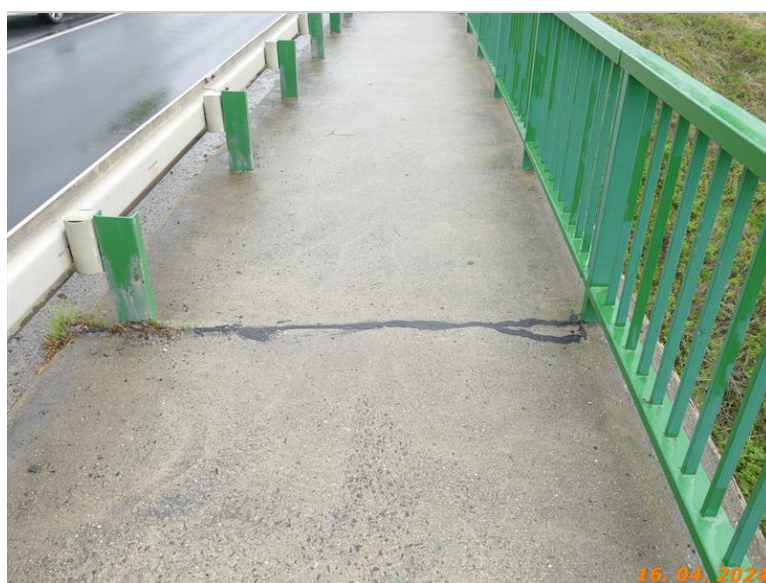
Dilatační spára pravé římsy
