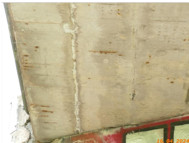
Inkrustace podélné spáry
