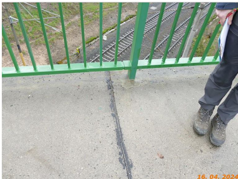
Dilatační spára římse vpravo
