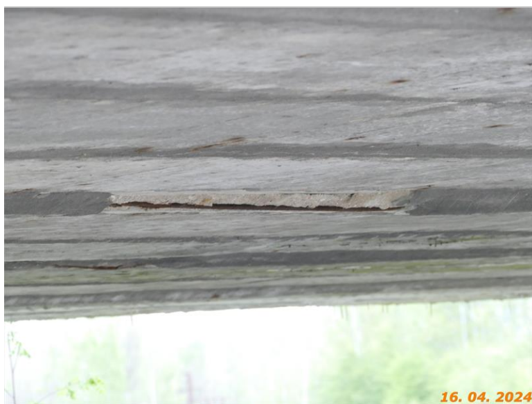
Koroze výztuže ve spáře
