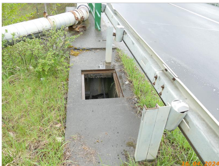
Chybějící poklop nad OP1
