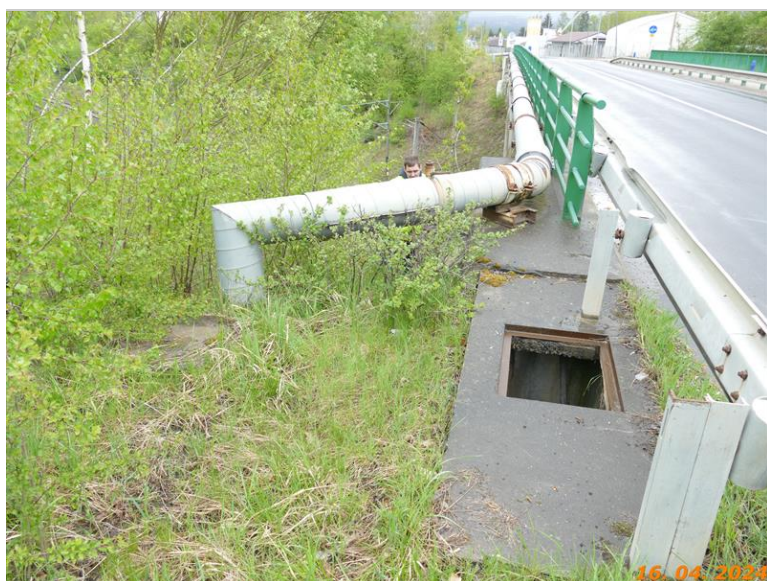
Chybějící poklop vlevo u OP1
