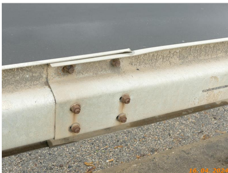
Koroze spojovacích prostředků svodnice
