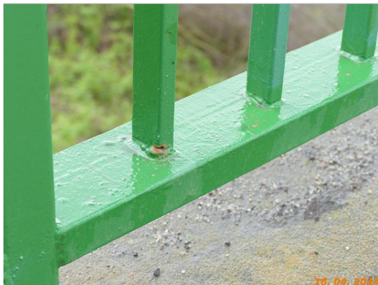
Lokální koroze zábradlí
