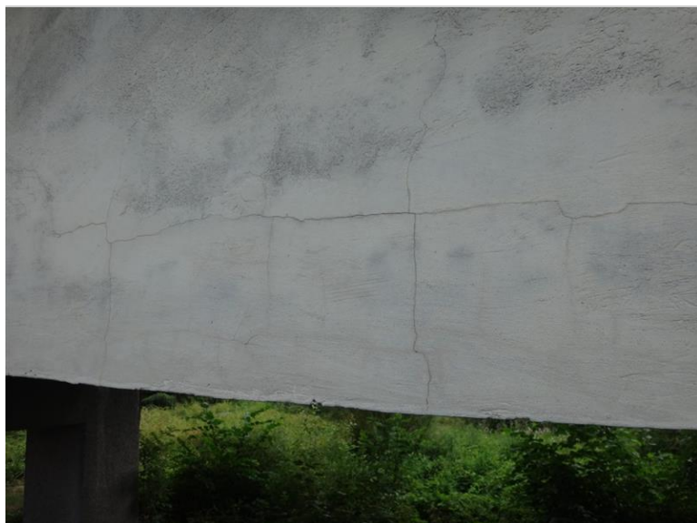
Trhliny v omítkce NK v poli 1
