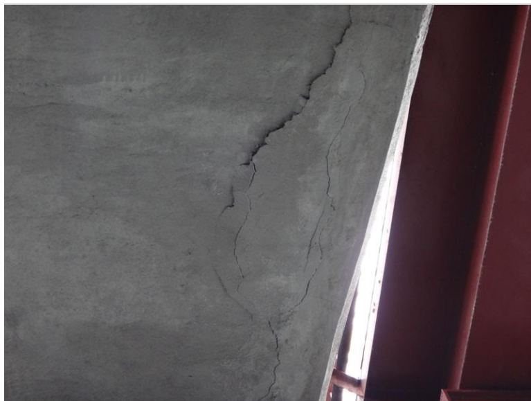
Poruchy v podhledu NK v poli 4
