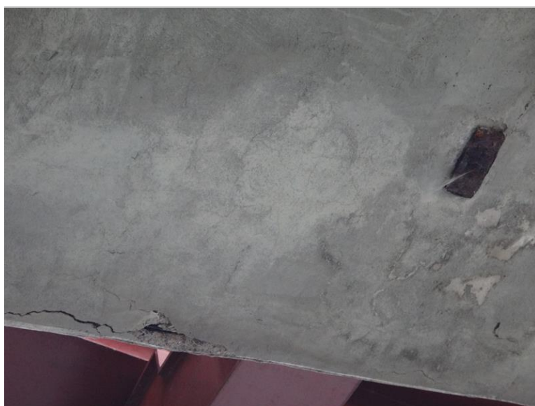
Lokální poruchy v podhledu pole 4
