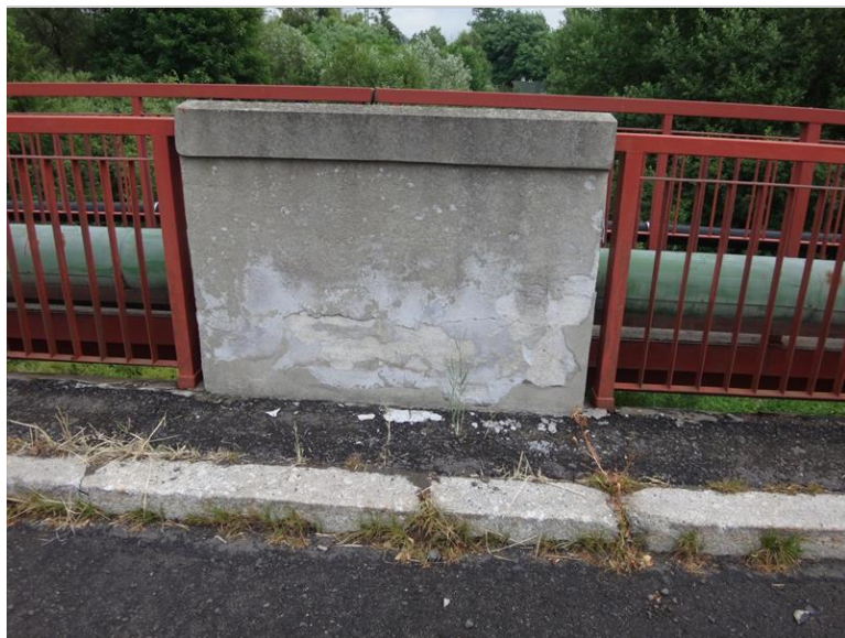
Poruchy zábradlí, úchyt vegetace ve spárách svršku
