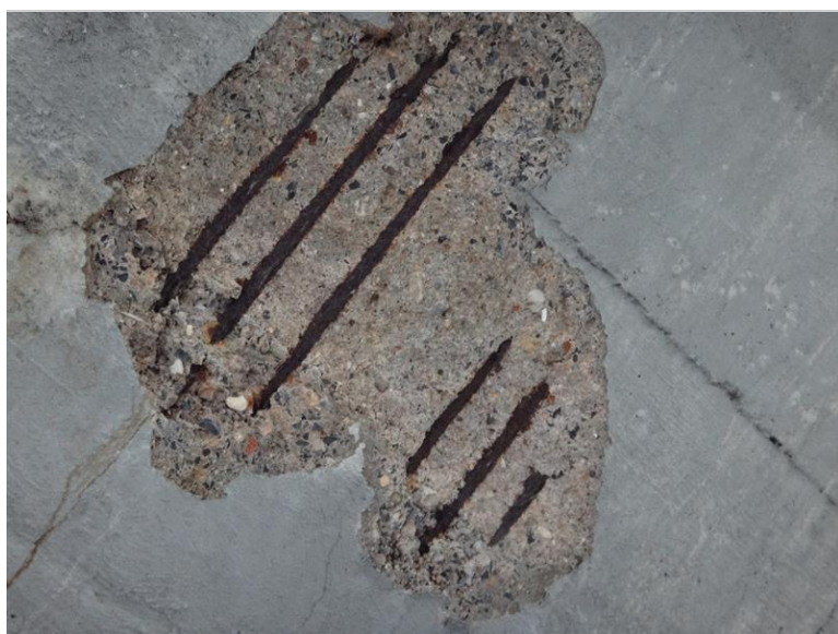
Poruchy v podhledu NK v poli 4
