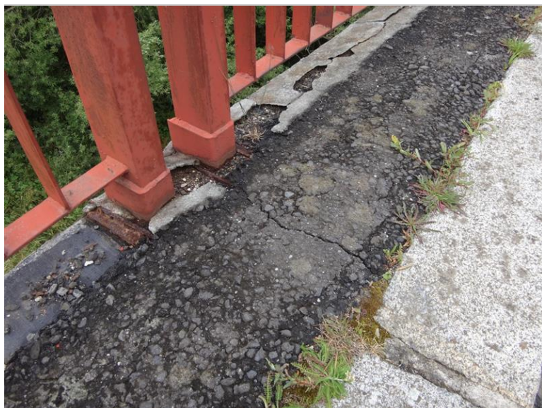
Poruchy říms, chodníků a úchyt vegetace ve spárách svršku
