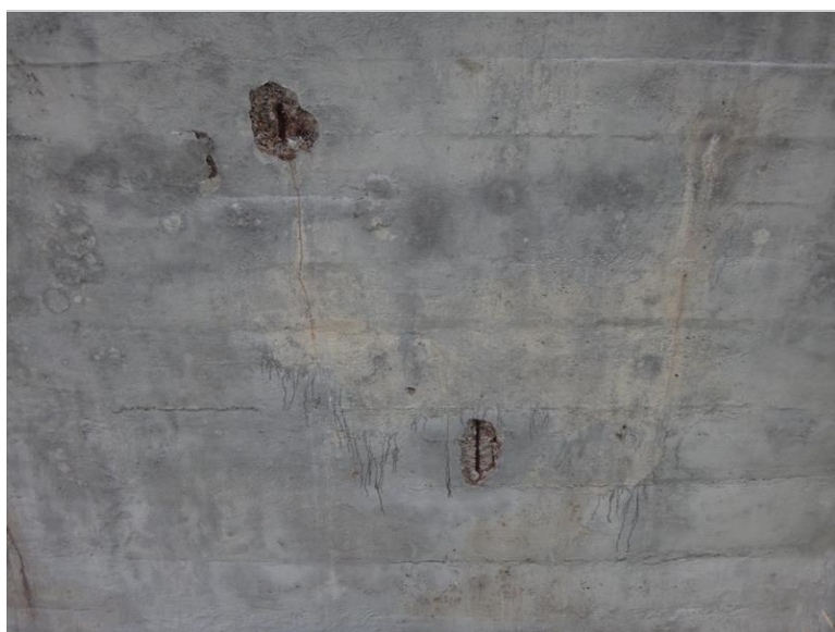
Poruchy v podhledu NK v poli 4
