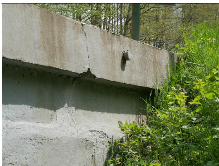
bod státní nivelace na římse
