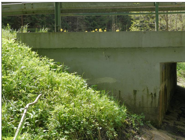
pravé křídlo OP1 - zatékání do pracovní spáry opěry a křídla
