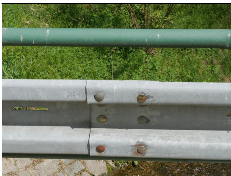
koroze spojovacího materiálu svodnice
