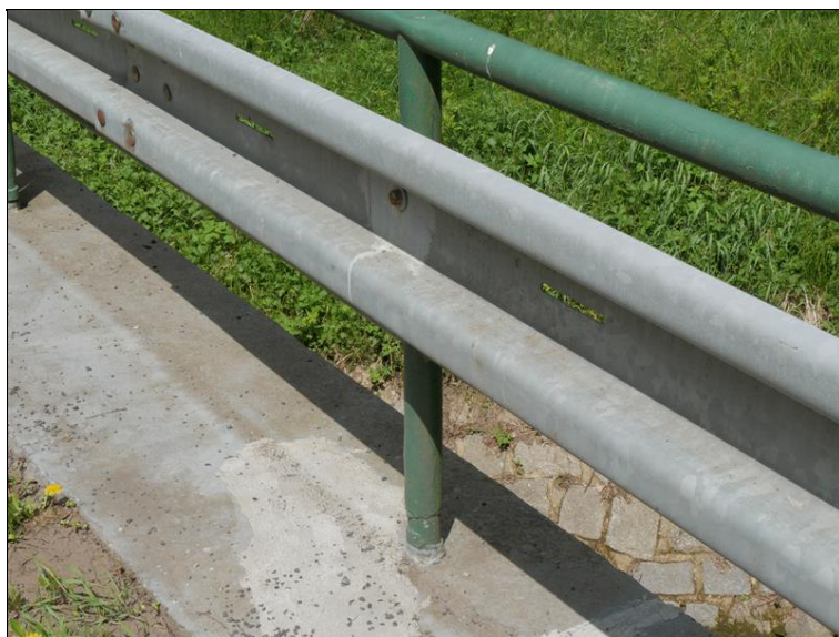
sloupek zábradlí neudrží náraz vozidla
