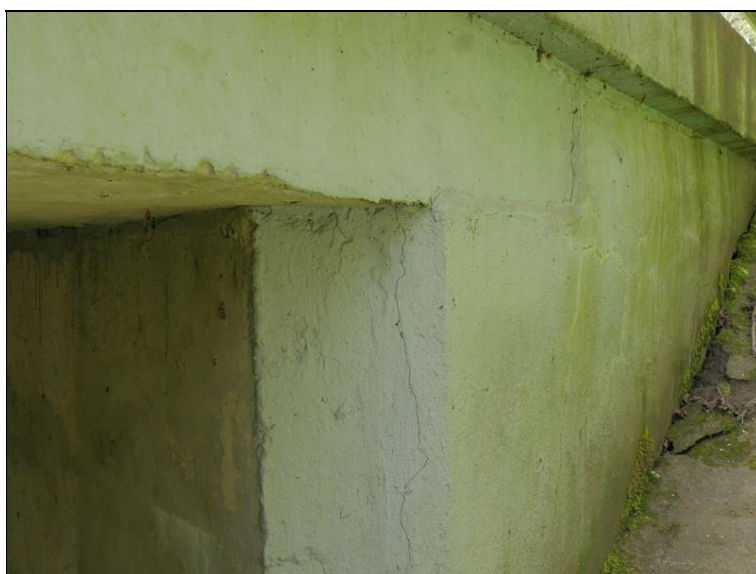
svislá trhlina v omítce v OP2 vpravo
