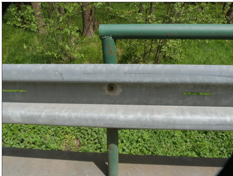
ukotvení svodnice na sloupek zábradlí
