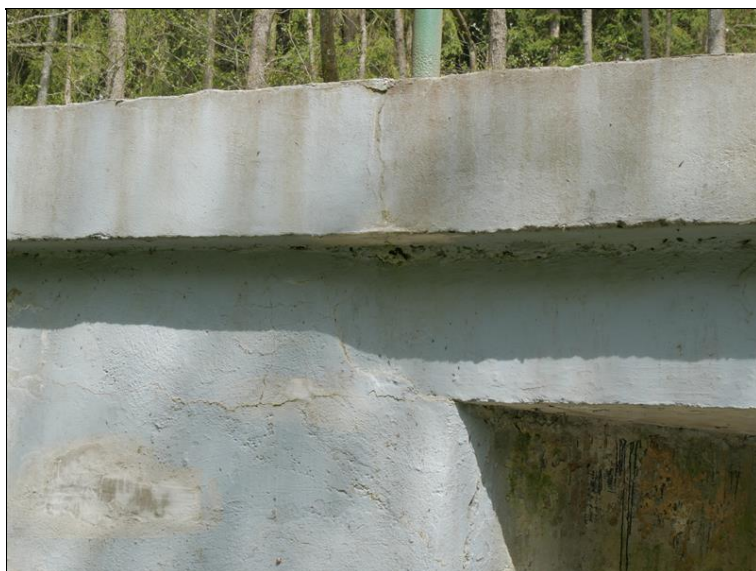
trhlina v římse na konci NK
