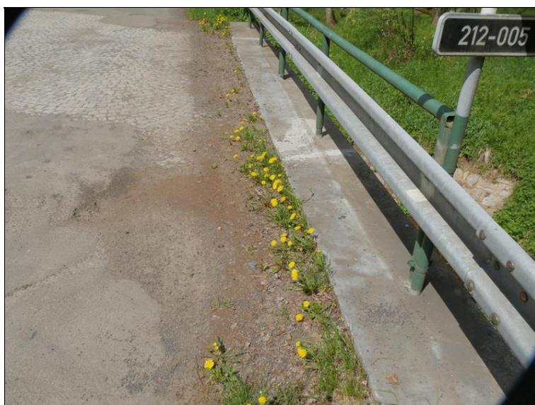
vozovka zvýšená, uchycená vegetace v krajích
