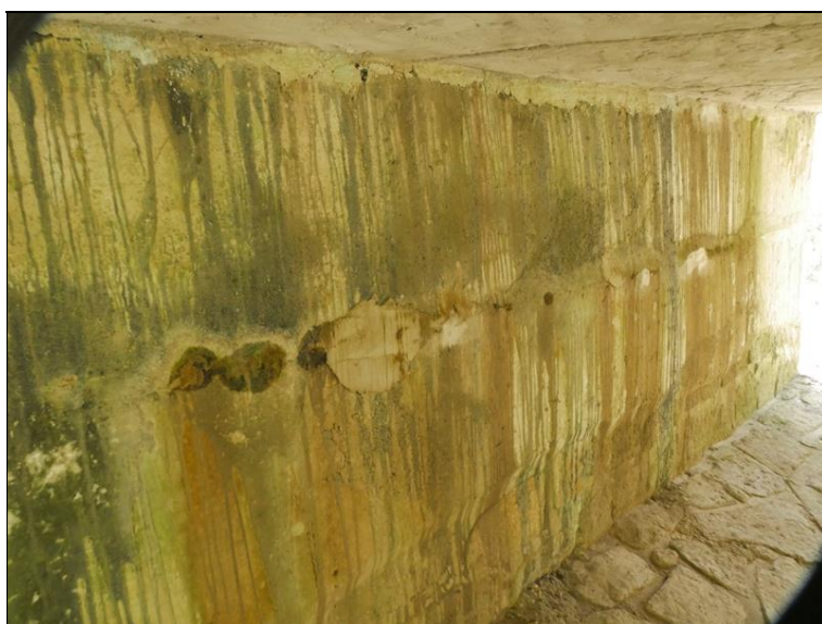
lokální vysprávký OP2 - zatékání do pracovní spáry
