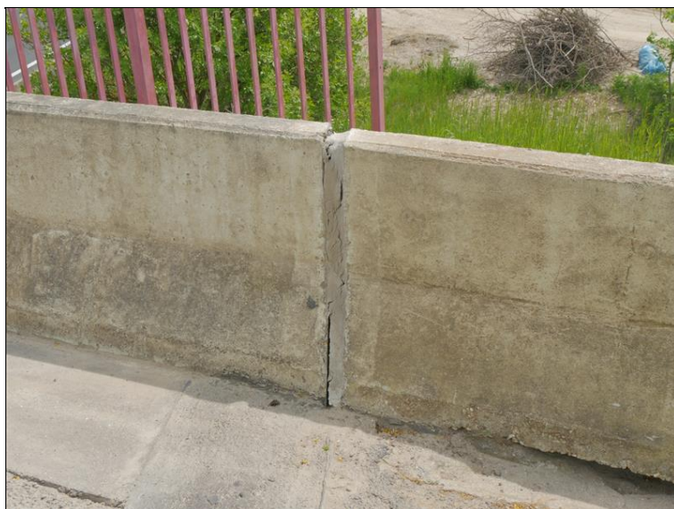
trhliny v těsnícím tmelu v dilatační spáře svodidlových zídek (OP1)
