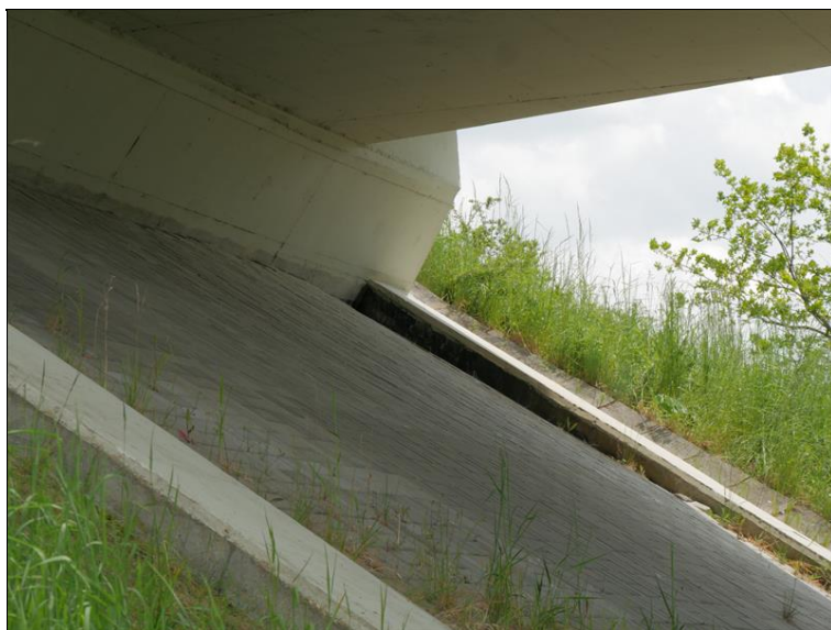
prosedlé zpevnění svahu OP1
