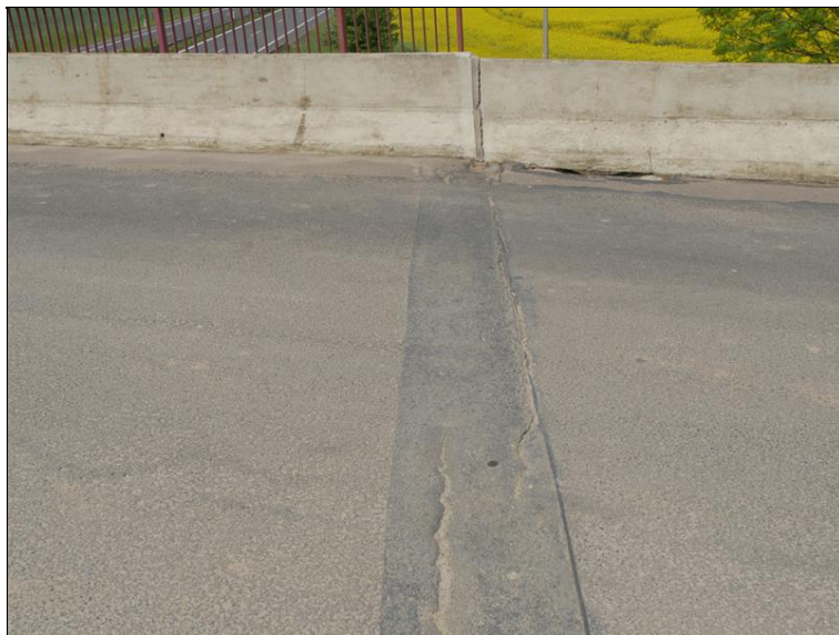
MZ nad OP4 - příčné trhliny, odtržení od krytu vozovky
