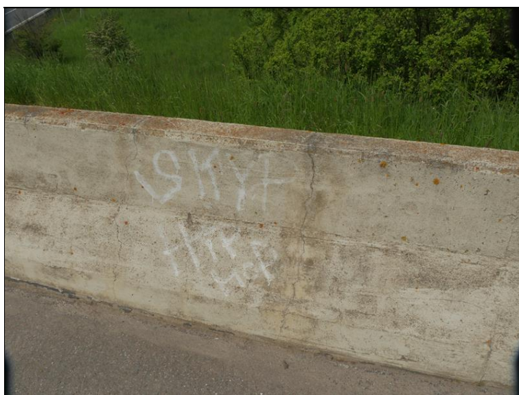
svislé trhliny v betonovém svodidle
