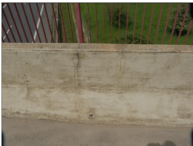
svislé trhliny v betonovém svodidle
