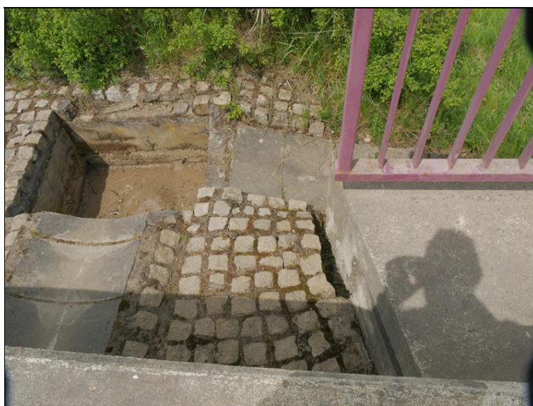
chybějící spárování v kamenné dlažbě
