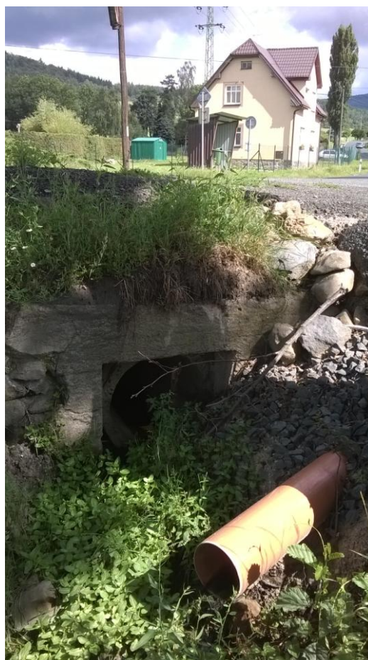
vyústění DN 400 (bezejmenného přítoku Vitického potoka)
