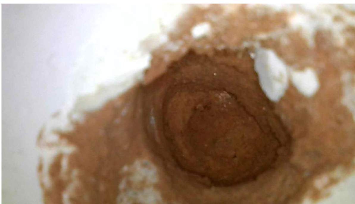
Obr. 8 – Místní sonda – příčka – cihla plná pálená
