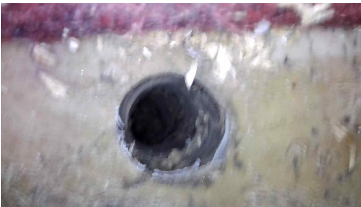
Obr. 10 – Místní sonda – dřevotřísková deska na dlažbě, betonová mazanina v podlaze
