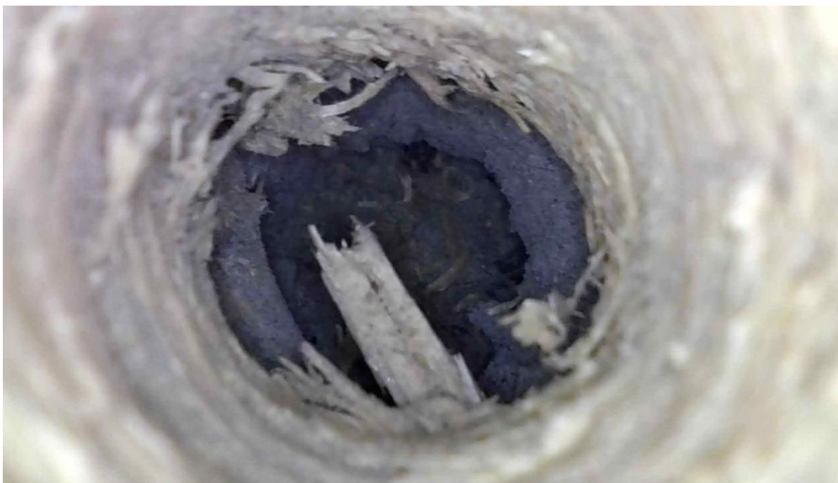
Obr. 4 – Místní sonda – dřevěná podlaha – dřevotřískové desky do kříže, zásyp a beton
