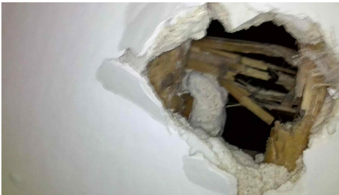
Obr. 5 – Místní sonda – strop – omítka na rákosu – dřevěný trámový strop vč. vzduchové mezery
