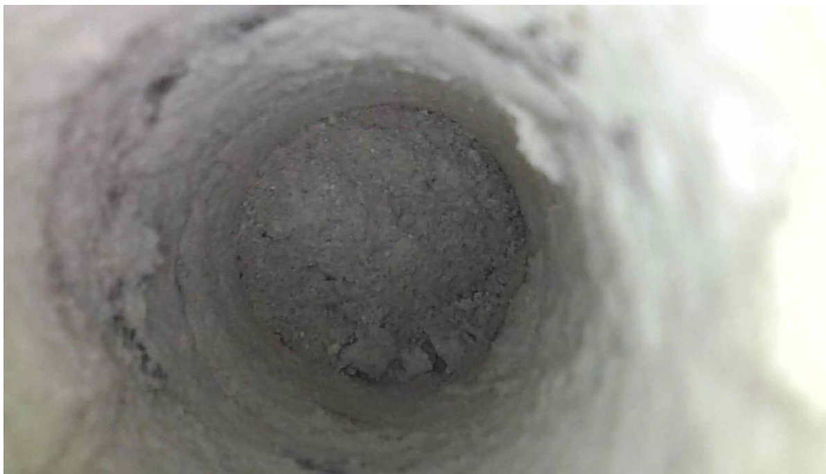
Obr. 1 – Místní sonda – betonová mazanina v podlaze
