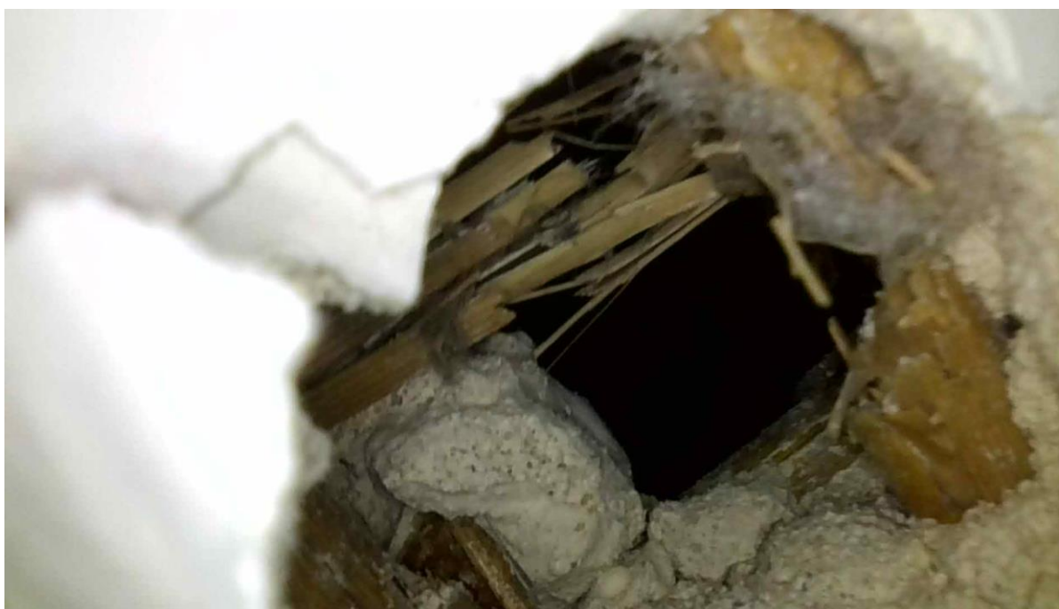
Obr. 6 – Místní sonda – strop – omítka na rákosu – dřevěný trámový strop vč. vzduchové mezery
