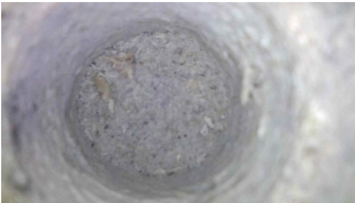
Obr. 9 – Místní sonda – betonová mazanina v podlaze
