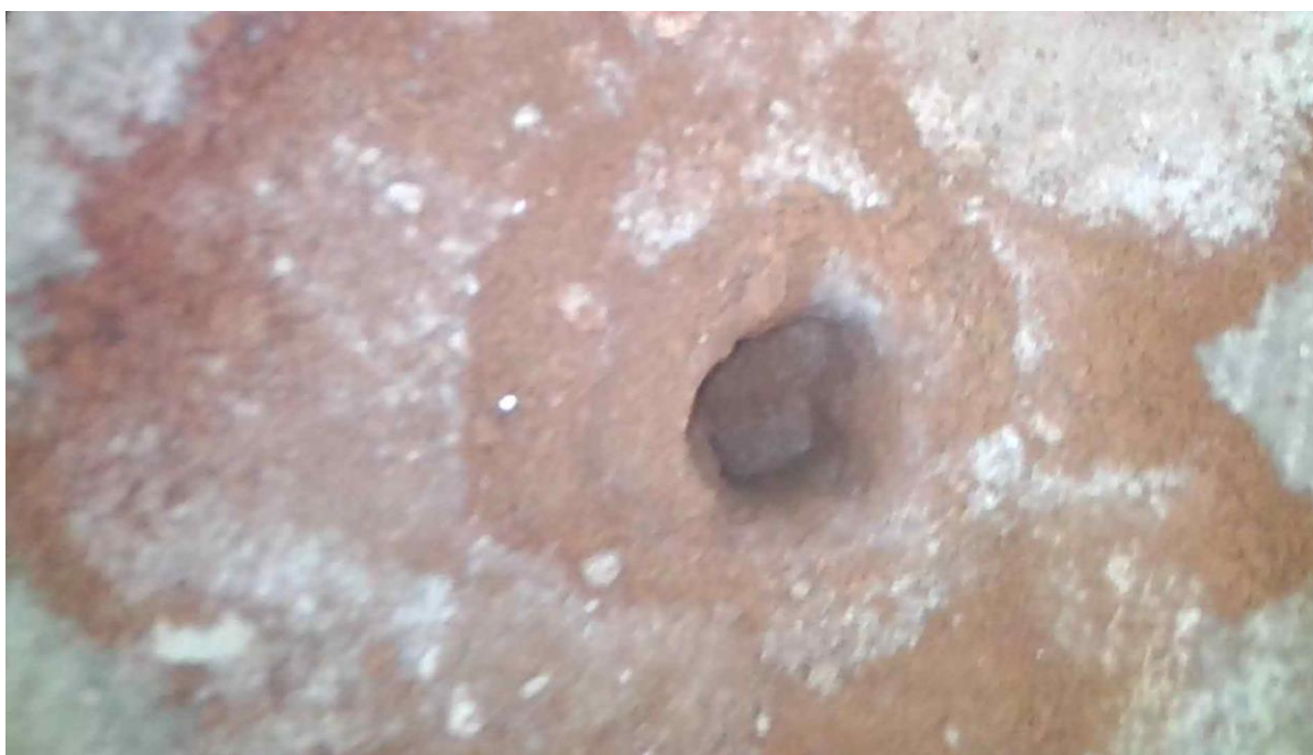
Obr. 7 – Místní sonda – příčka – cihla plná pálená
