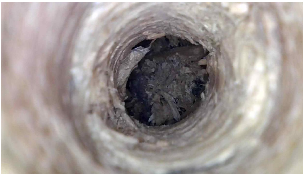
Obr. 3 – Místní sonda – dřevěná podlaha – dřevotřískové desky do kříže, zásyp a beton
