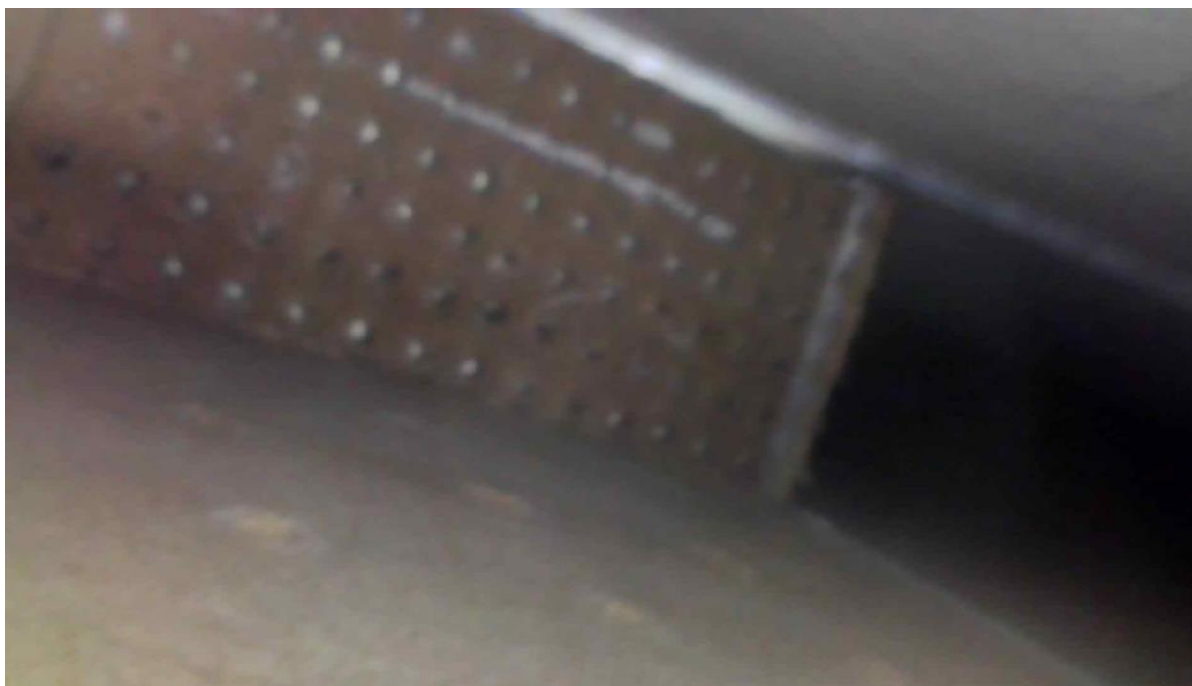
Obr. 12 – Místní sonda – zeď s obložením akustických panelů – vzduchová mezera mezi zdí a panely
