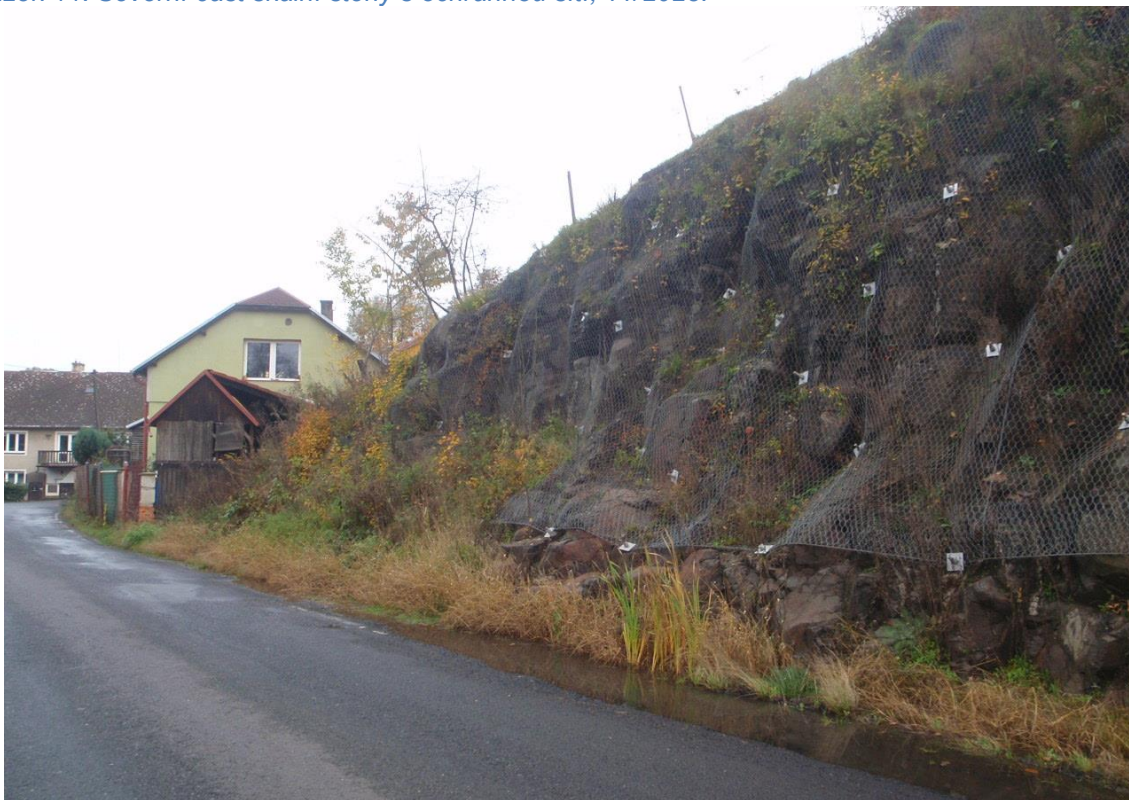
Obrázek 12: Severní část skalní stěny s ochrannou sítí, 11/2023.
