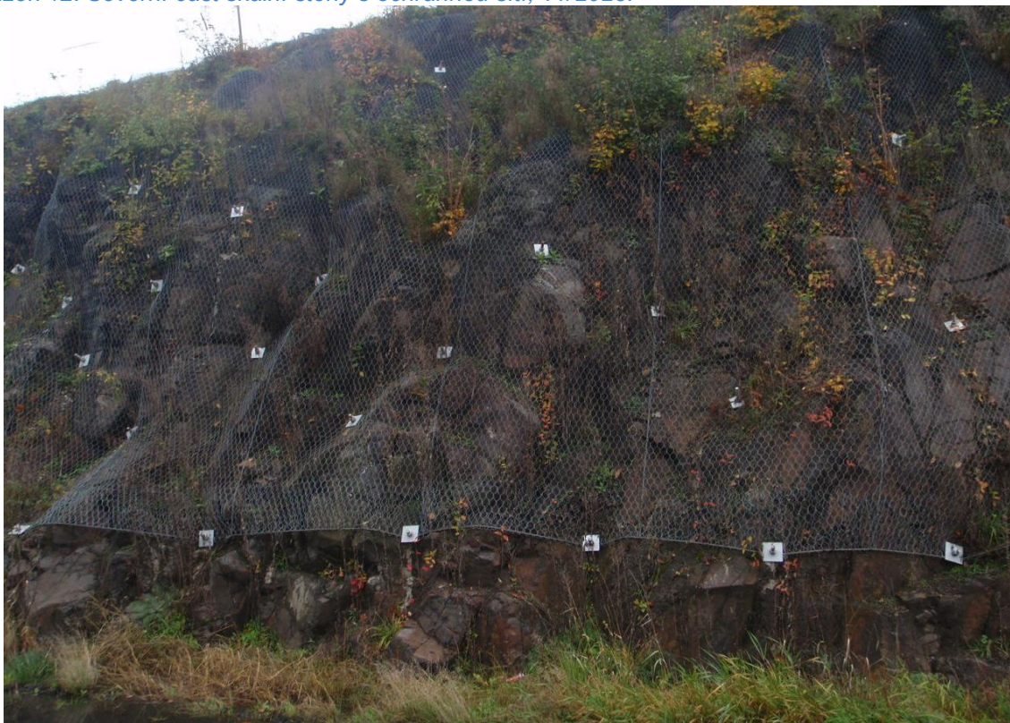
Obrázek 12: Severní část skalní stěny s ochrannou sítí, 11/2023.
