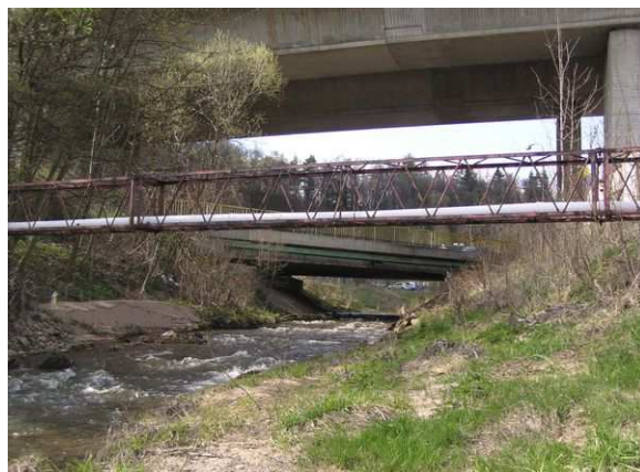
Místo lávky, v pozadí mosty, příhradová konstrukce pod H 100 bude odstraněna
