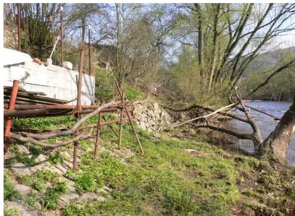
Zeď pod pozemkem p.č.1208, 1209, v popředí vlevo opevnění svahu 1:1.25
