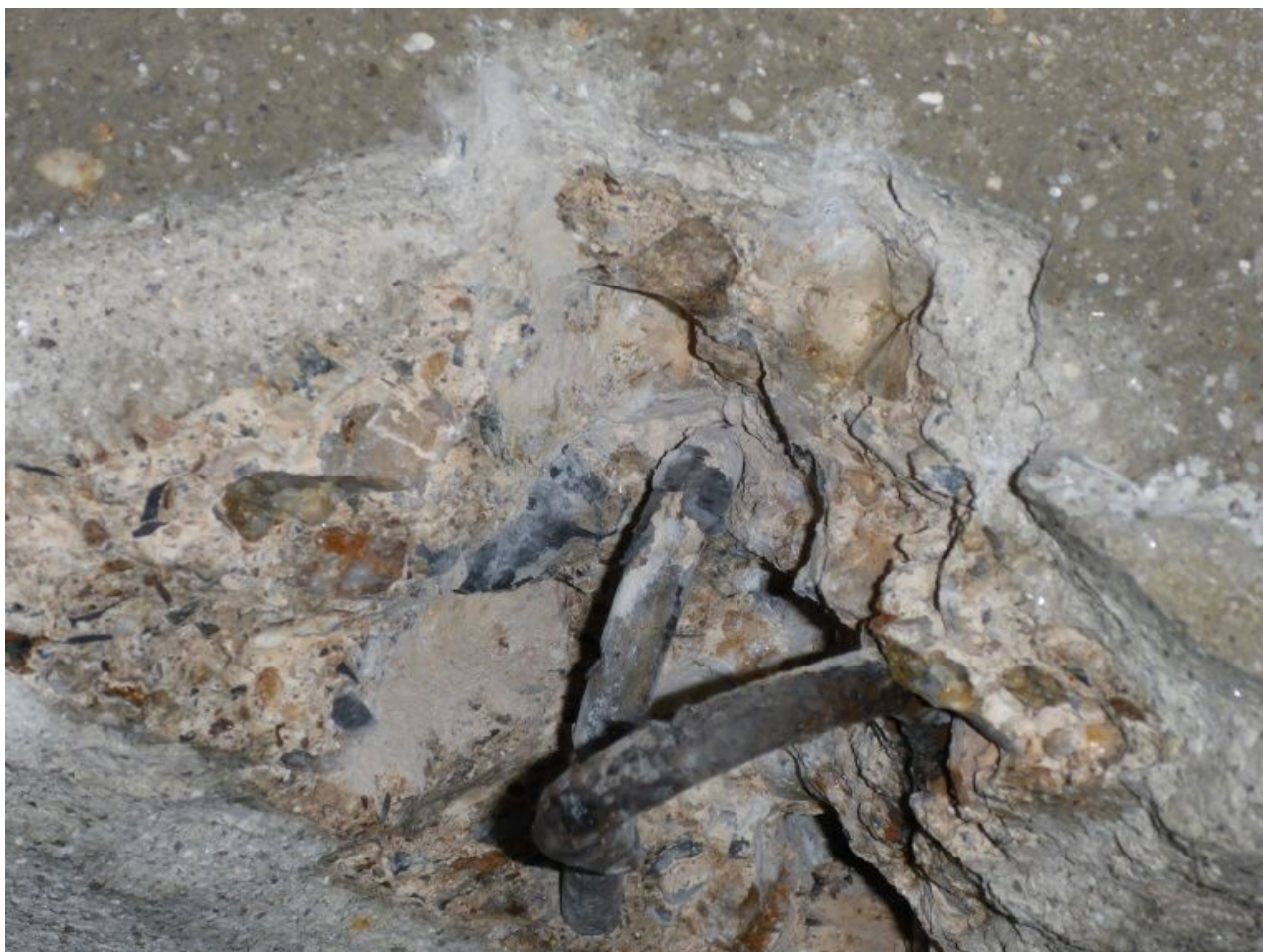
087 Sondy do nosné konstrukce mostu
