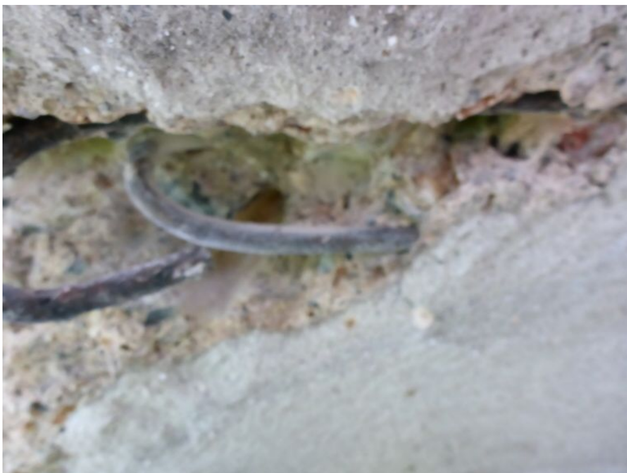
084 Sondy do nosné konstrukce mostu
