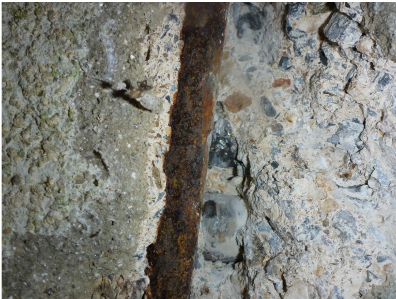
096 Sondy do nosné konstrukce mostu
