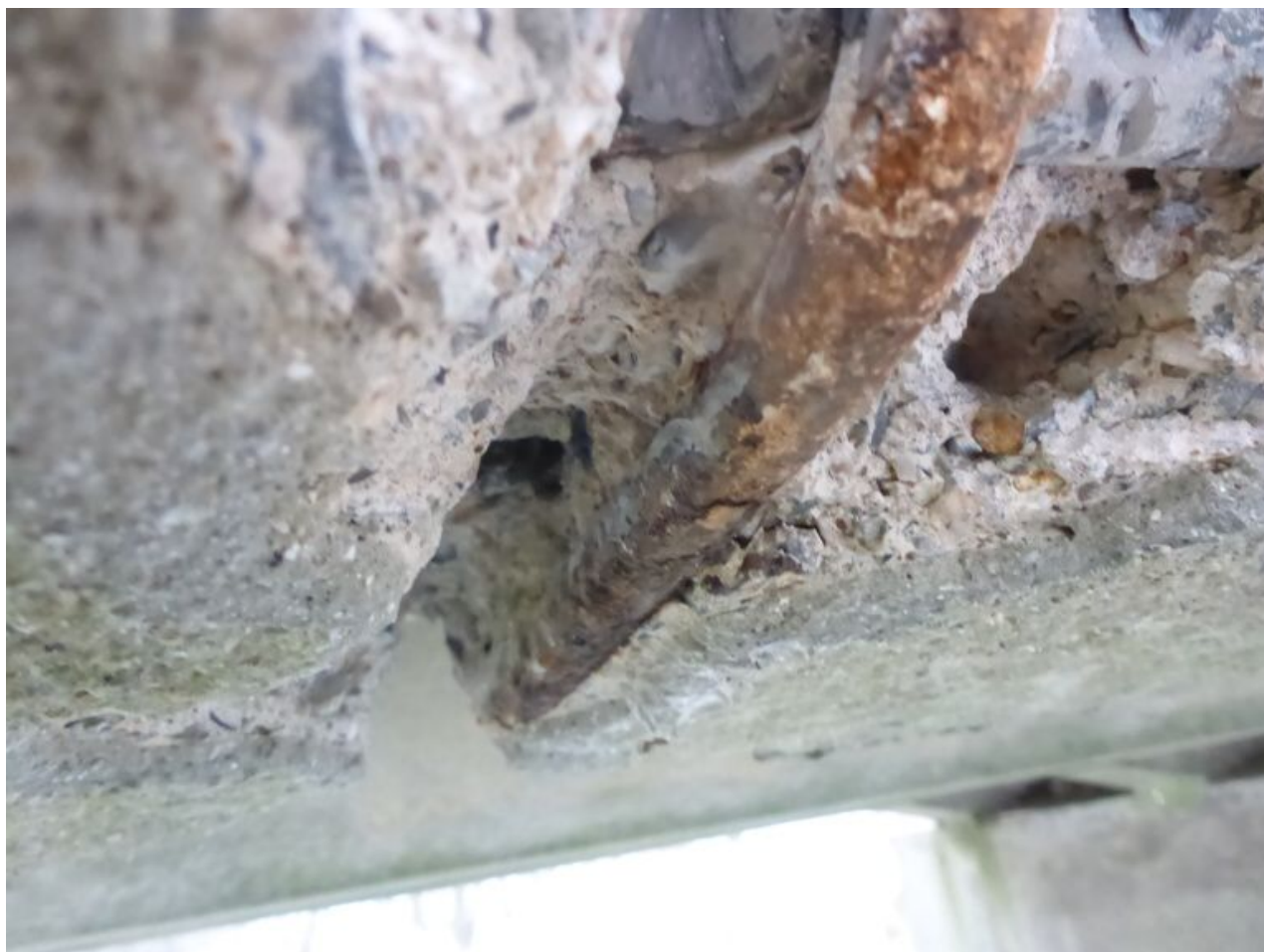
089 Sondy do nosné konstrukce mostu
