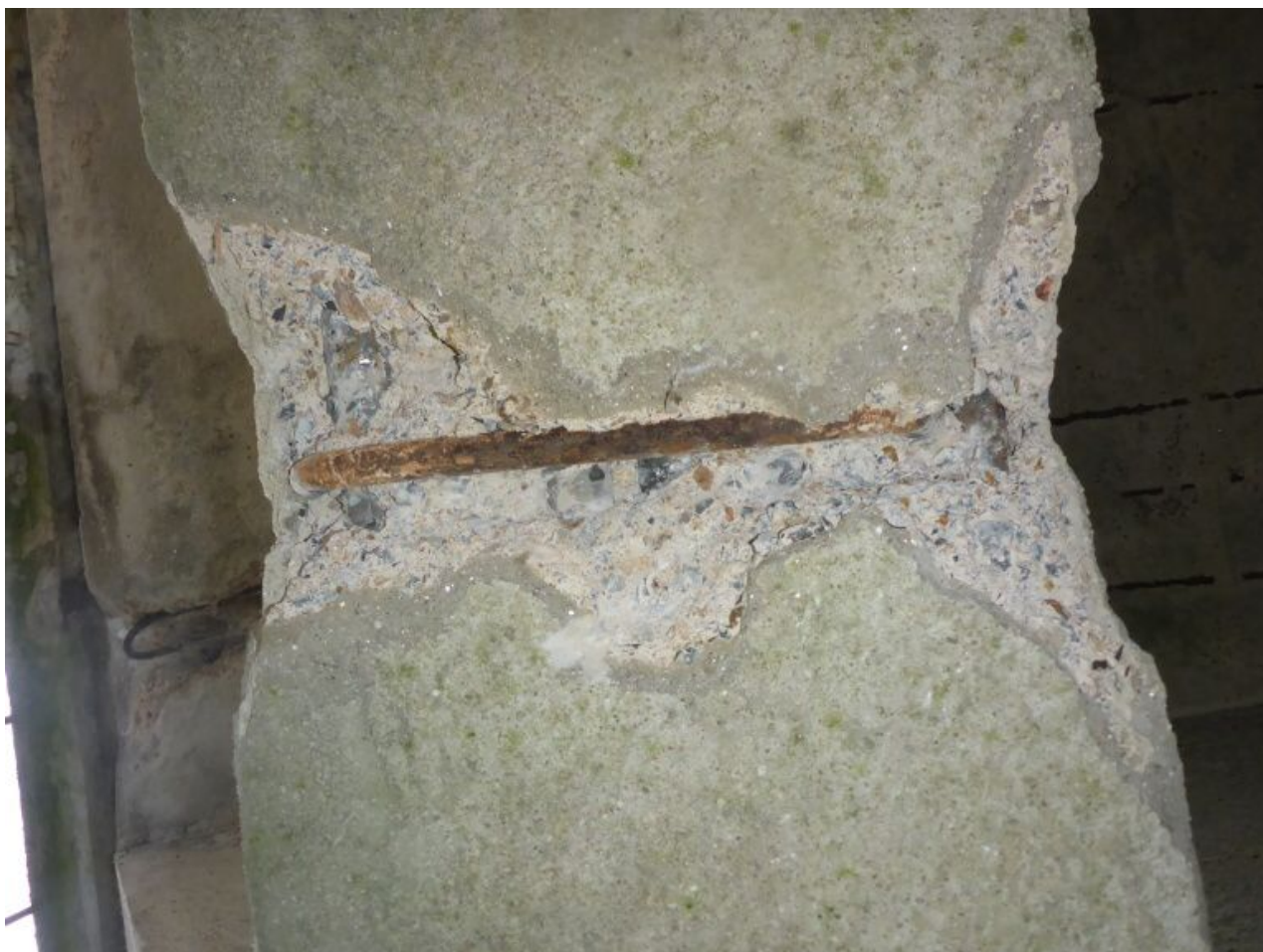
097 Sondy do nosné konstrukce mostu
