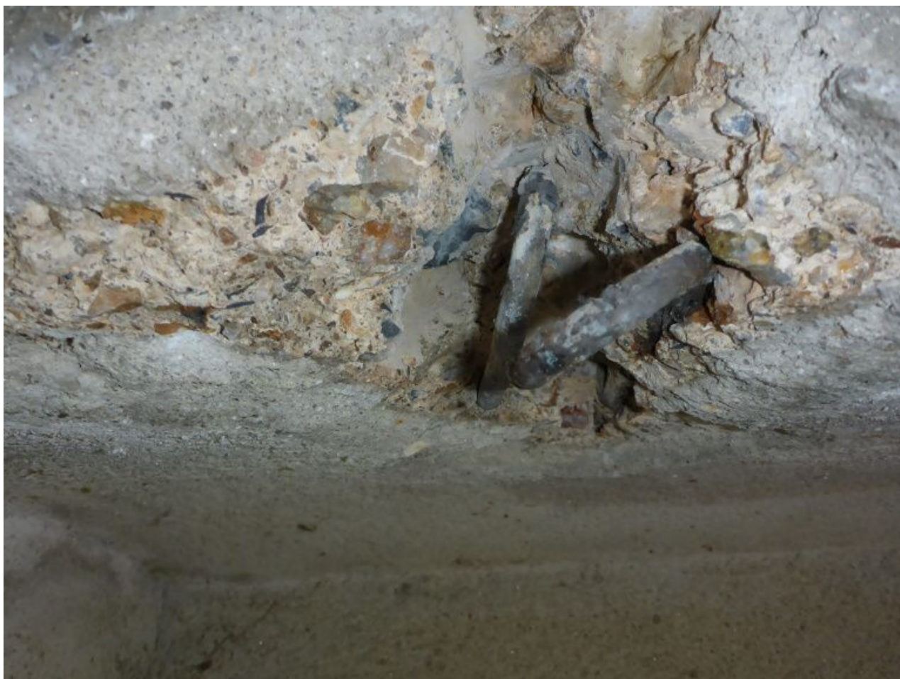
083 Sondy do nosné konstrukce mostu
