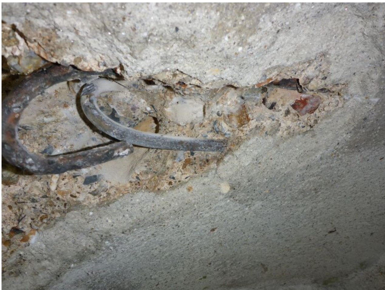
085 Sondy do nosné konstrukce mostu
