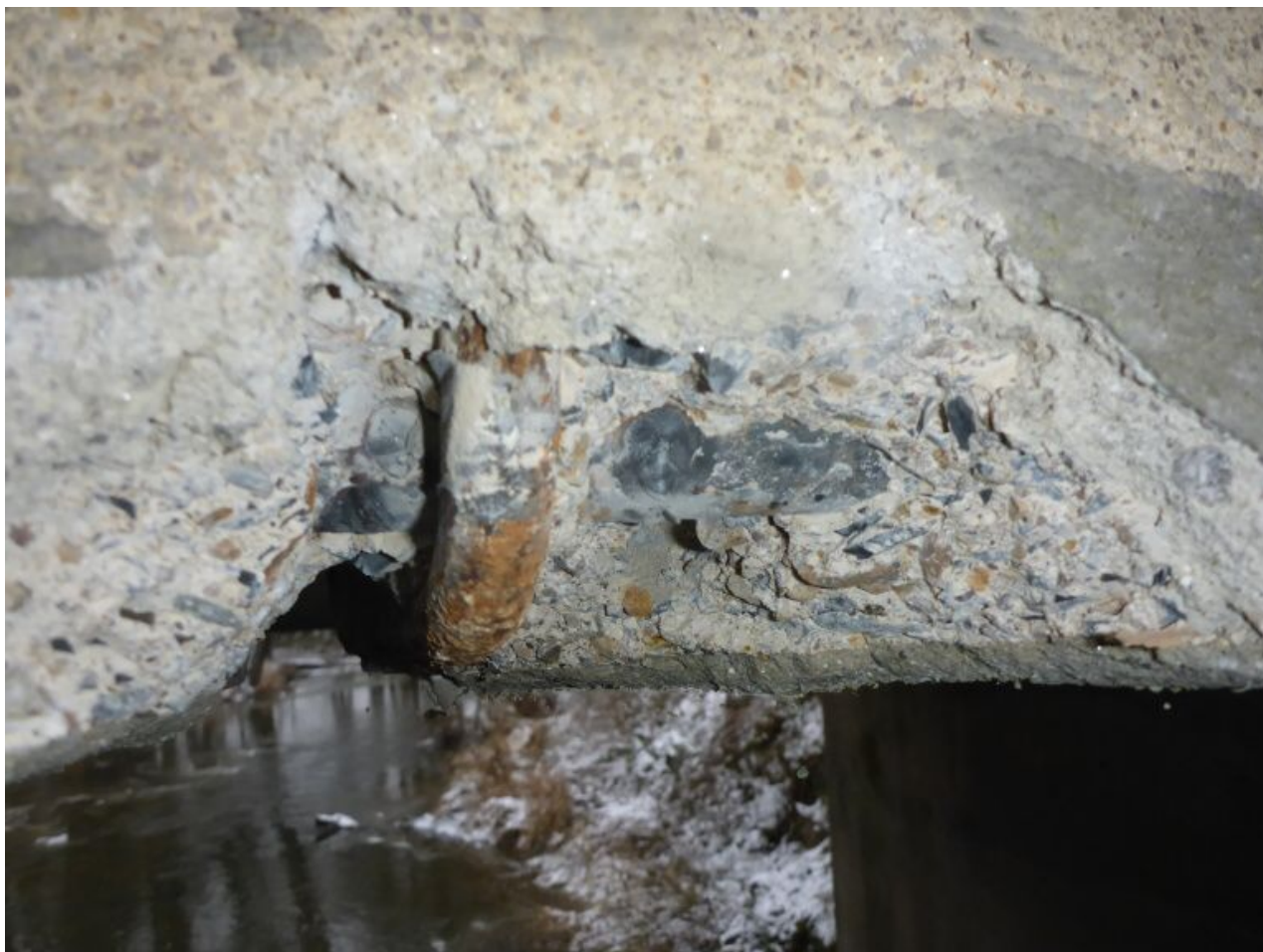
088 Sondy do nosné konstrukce mostu
