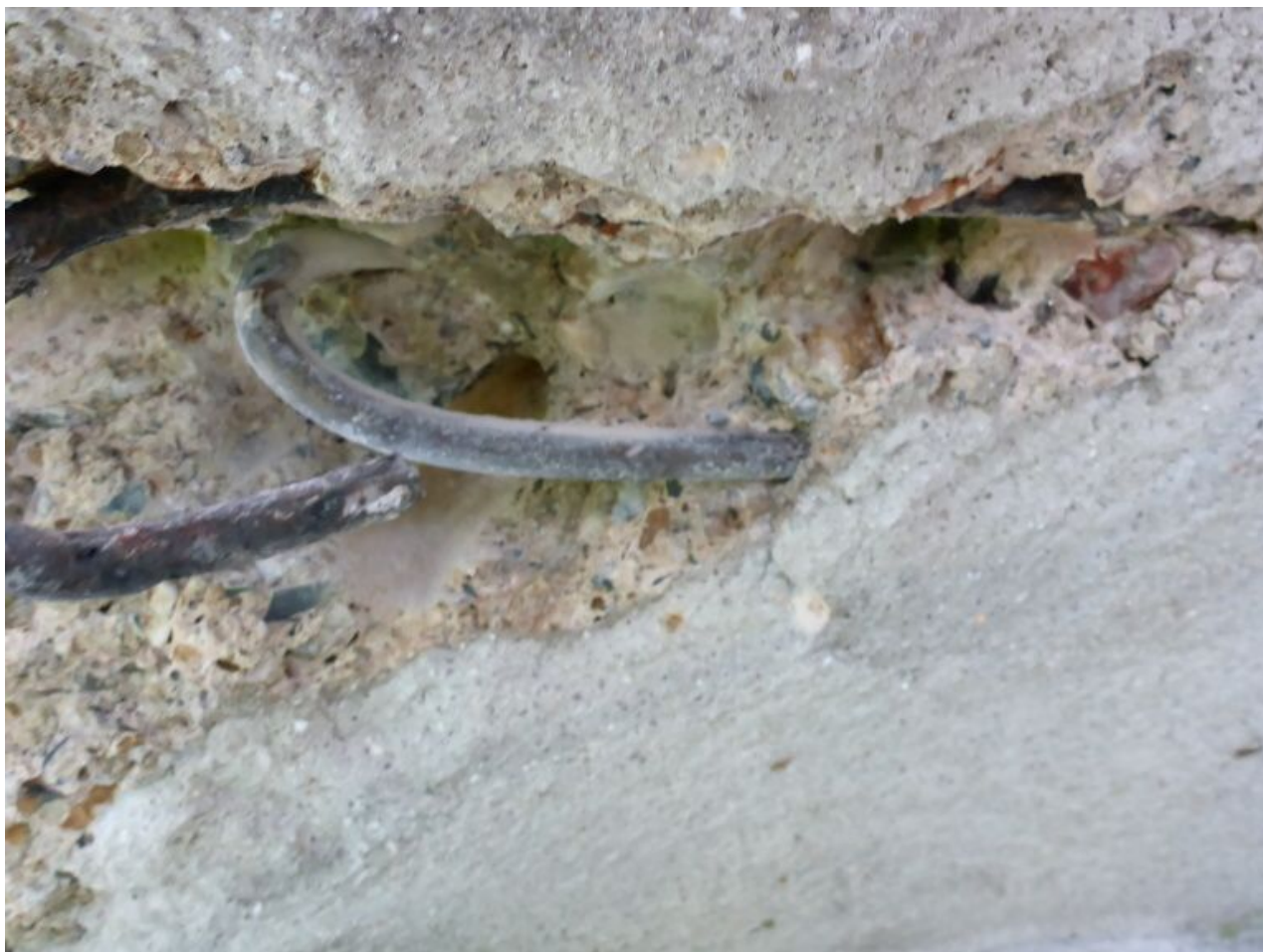
086 Sondy do nosné konstrukce mostu
