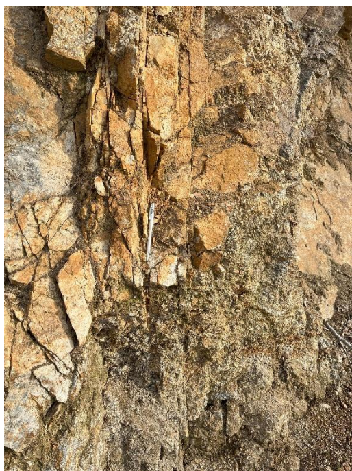
Obr. 7 Diskontinuity v granitu v severozápadní části zájmového území
