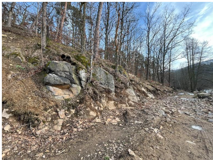
Obr. 2 Pohled na obnažený granit v západní části trasy
