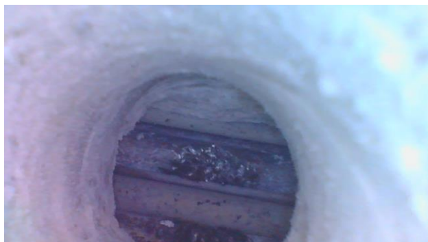
Obr. 8 Sonda do kabelového kanálku – viditelná dutina
