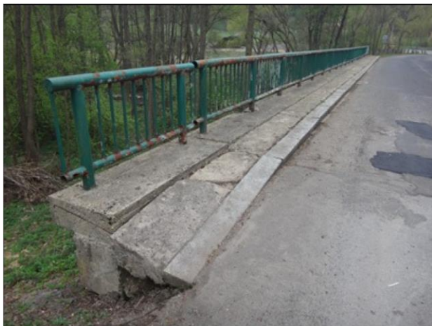
Obr. 2 a 3 Stav chodníků a říms v době provedení HMP – 04/2019
