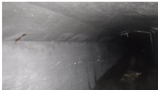
Obr. 9 Dutina nosníku – viditelná přítomnost vody
