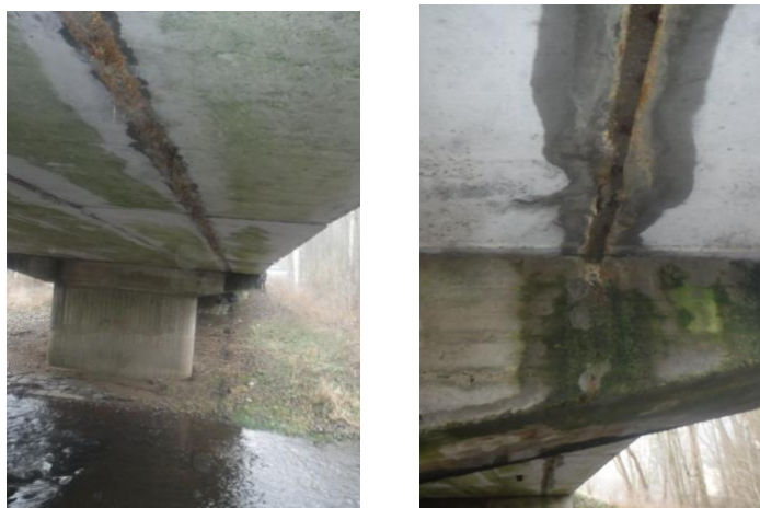
Obr. 6 a 7 Zatékání mezi 1. a 2. krajní nosník
