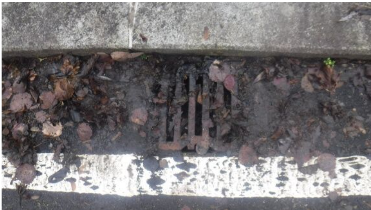
128 Stav odvodňovačů
