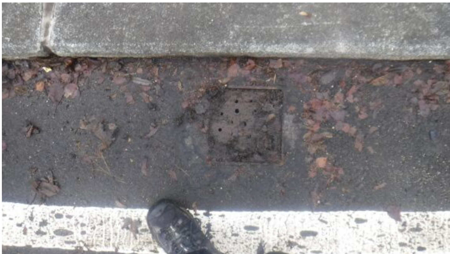
130 Stav odvodňovačů
