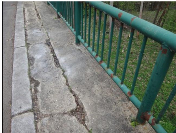
Obr. 2 a 3 Stav chodníků a říms v době provedení HMP – 04/2019
