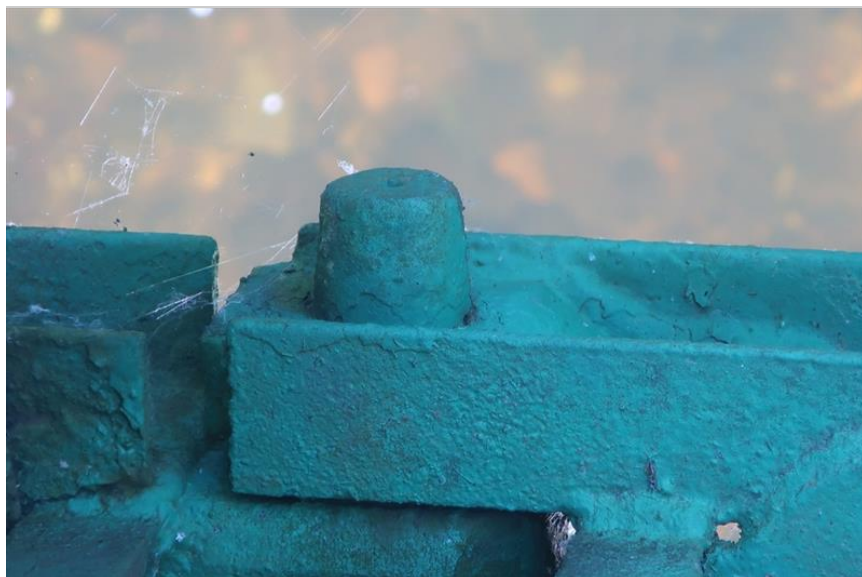
chybějící závlačka čepu v úrovni dolního pasu hlavního nosníku
