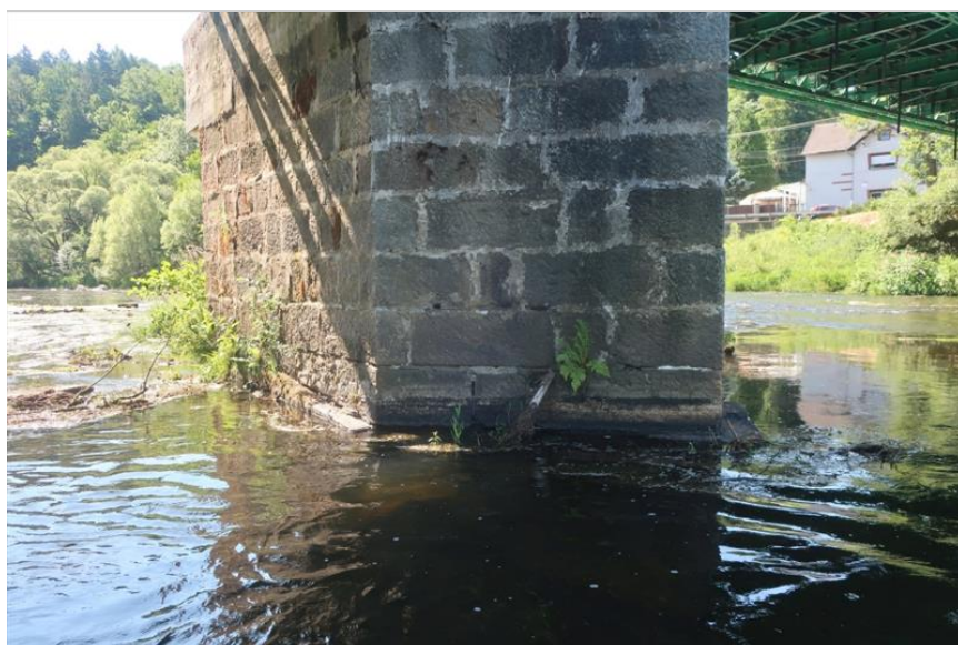
uchycená vegetace a vyplavené spárování na lici obkladového zdiva pilře P3
