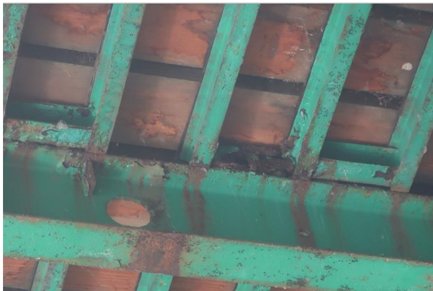
detail intenzivní koroze mezilehlého příčnicku ve 2. poli spojená s oslabením průřezové plochy koroze podélníků zejména v oblasti uložení s přerezáním ztužením
