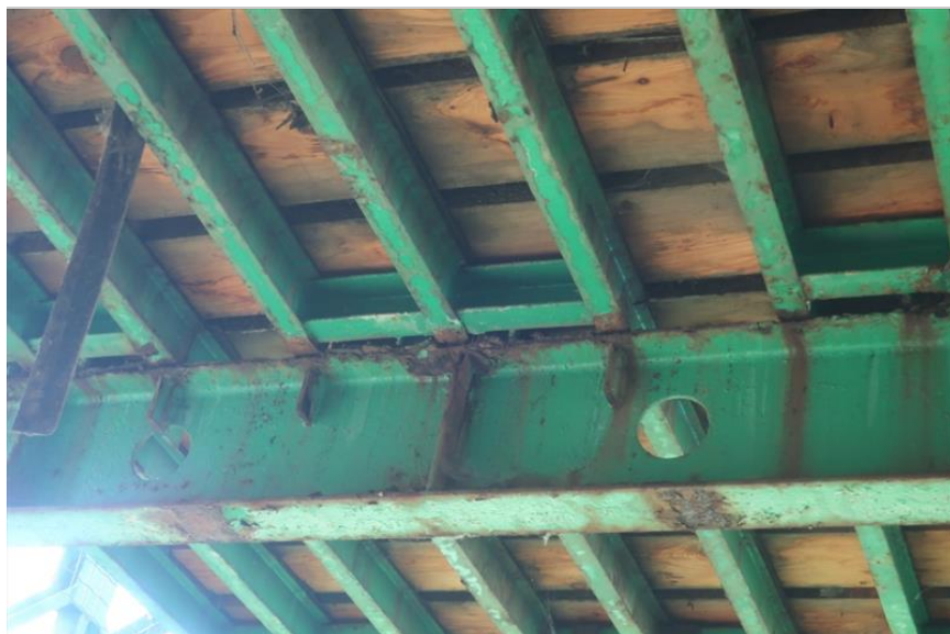
detail intenzivní koroze mezilehlého příčniku ve 3. poli spojená s oslabením průřezové plochy koroze podélníků v oblasti uložení
