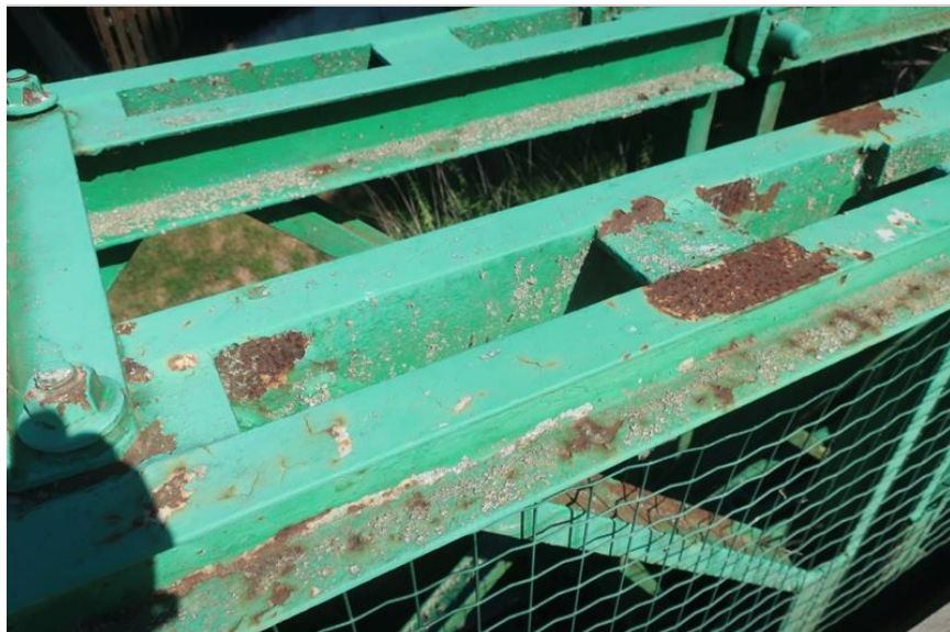
koroze prvků horního pasu hlavního nosníku
