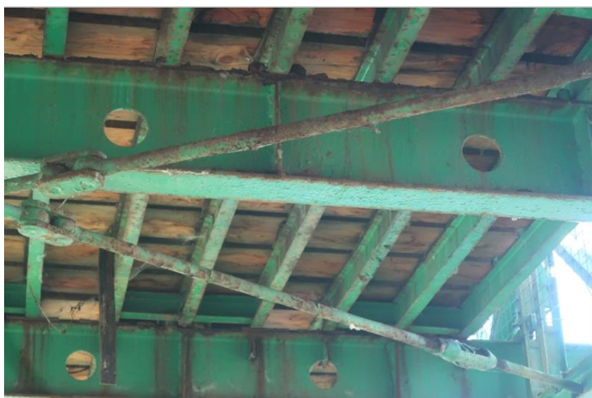
koroze prvků horizontálního ztužení v úrovni dolního pasu hlavních nosníků - 3. pole
