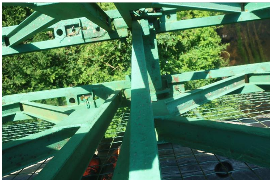
koroze prvků dolního pasu hlavního nosníku
