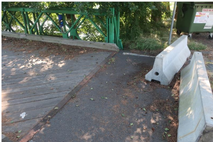
betonová svodidla na předmostí před O1 brání vjezdu vozidel
