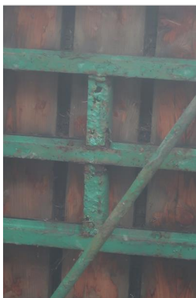
koroze podélníků s přerezáním ztužením
