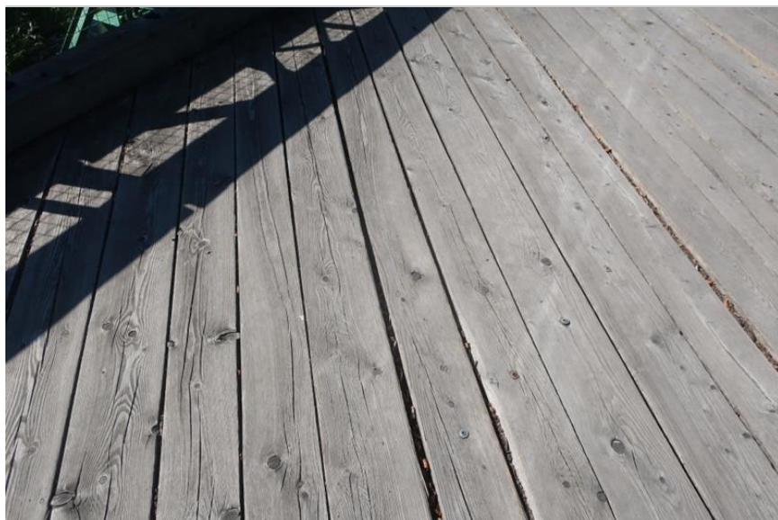
různá šířka spar mezi prkny pochozí vrstvy mostovky
