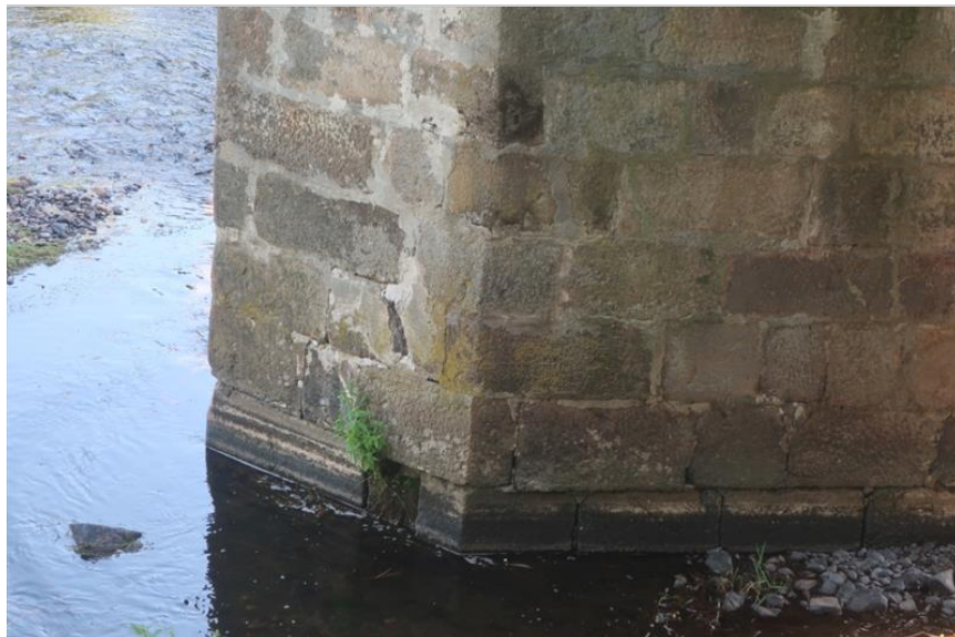
vyplavené spárování zdiva dřiku pilíře P2
