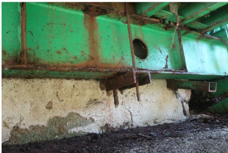
intenzivní koroze tahového ložiska O4
