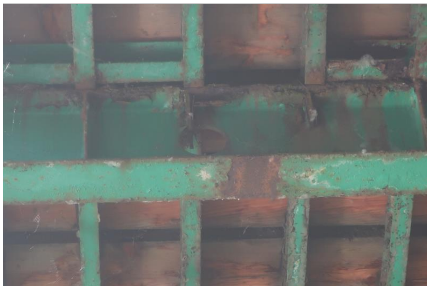
koroze podélníků s přerezáním ztužením
