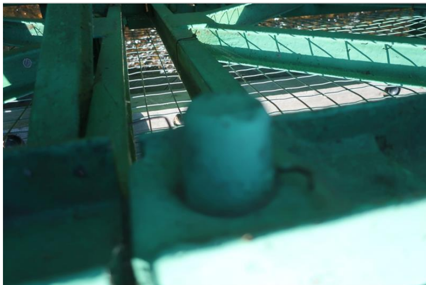
chybějící závlačka čepu v úrovni horního pasu hlavního nosníku
