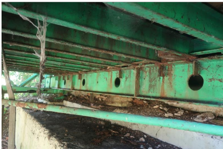
korozí podporového příčnicku nad O1
