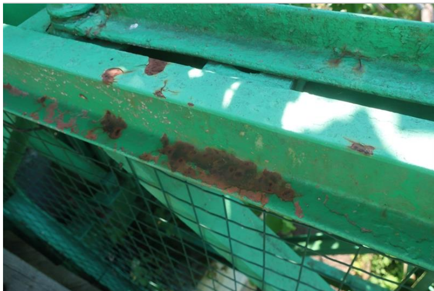
koroze prvku horního pasu pravého hlavního nosníku před O4
