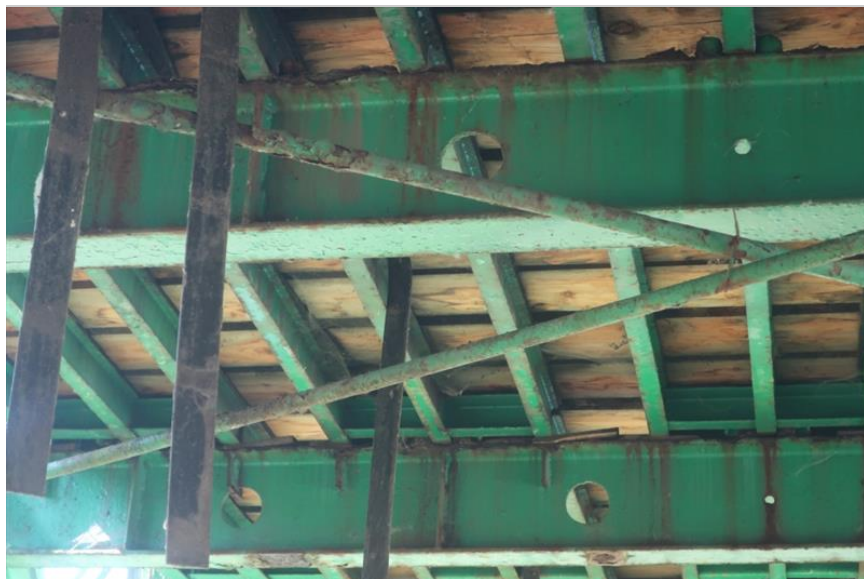
detail intenzivní koroze mezilehlého příčniku ve 3. poli spojená s oslabením průřezové plochy koroze podélníků zejména v oblasti uložení
