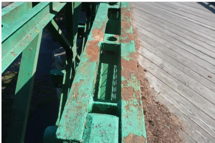
koroze prvků horního pasu hlavního nosníku
