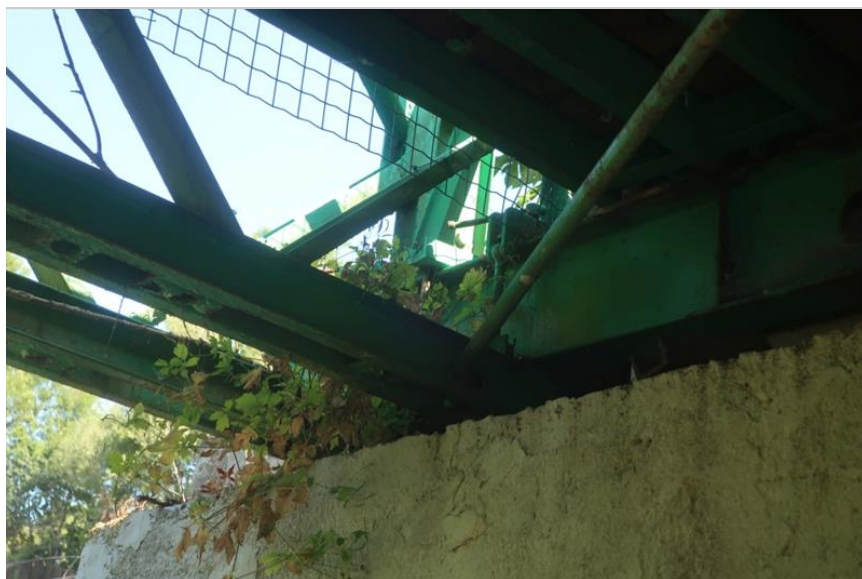
detail intenzivní koroze mezilehlého příčniku ve 3. poli spojená s oslabením průřezové plochy
