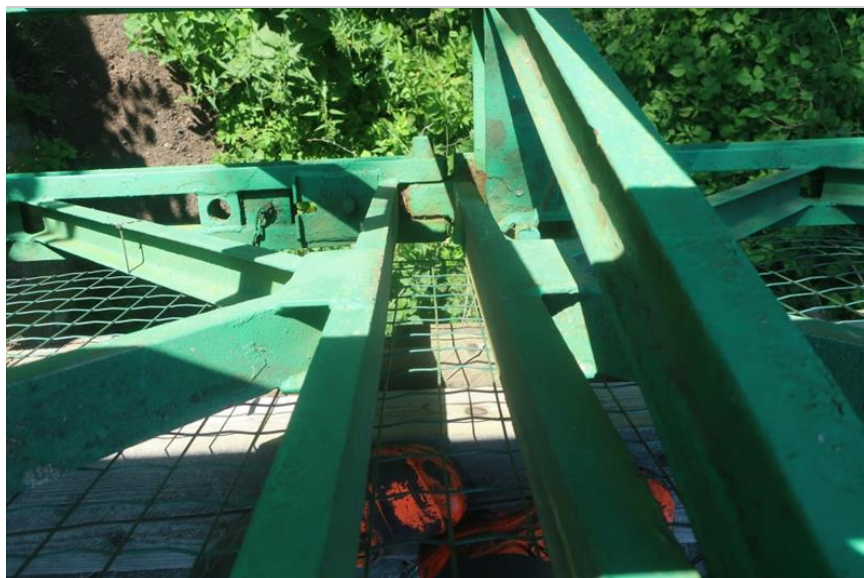
chybějící závlačka čepu v úrovni dolního pasu pravého hlavního nosníku
