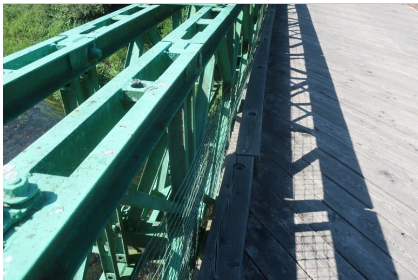
uvolněné pletivo výplně zábradlí
