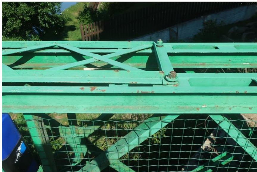
lokální povrchová koroze prvků hlavního nosníku
