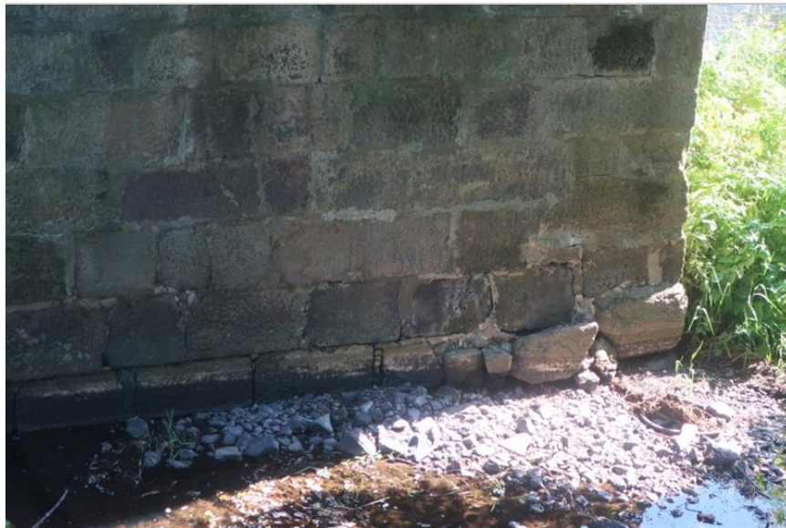
uvolněný kámen ze zdiva dřiku pilíře P2
