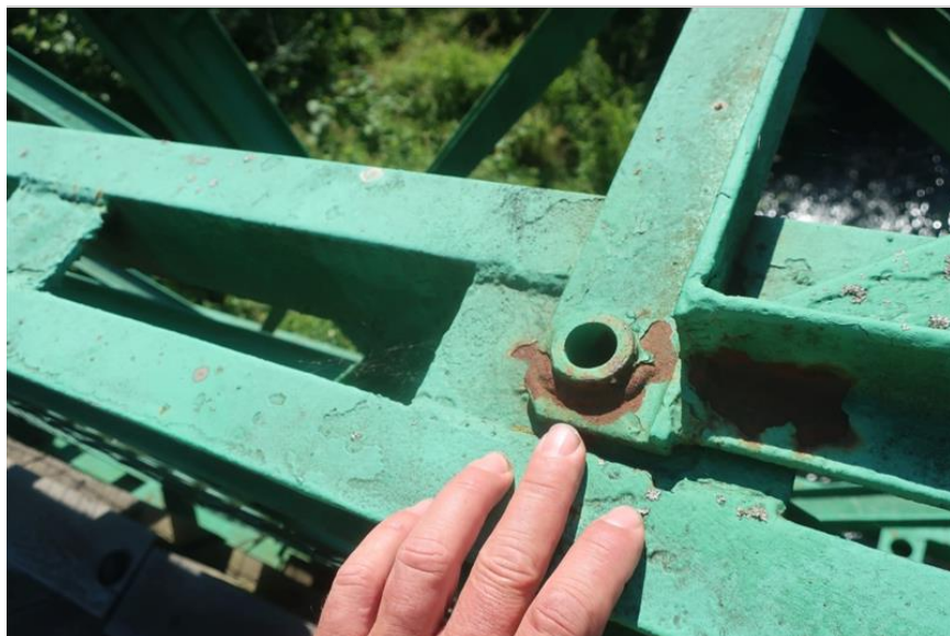
chybějící šroubový spoj horizontálního ztužení prvků horního pasu hlavního nosníku
