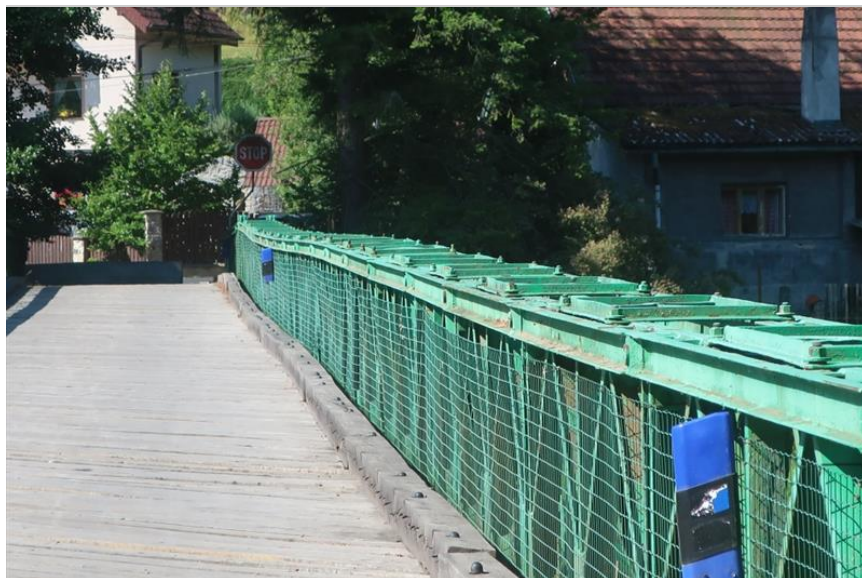
deformace levého hlavního nosníku ve 2. poli
