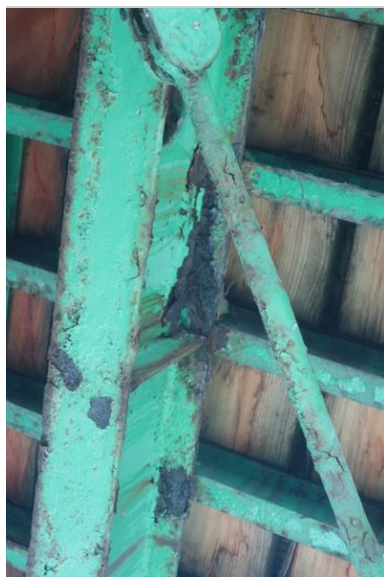
detail intenzivní koroze mezilehlého příčniku ve 3. poli spojená s oslabením průřezové plochy
