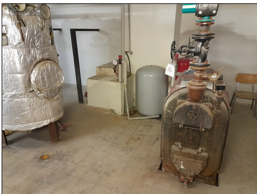
POHLED KOTELNA - NEPOUŽÍVANÝ KOTEL NA PEVNÁ PALIVA
