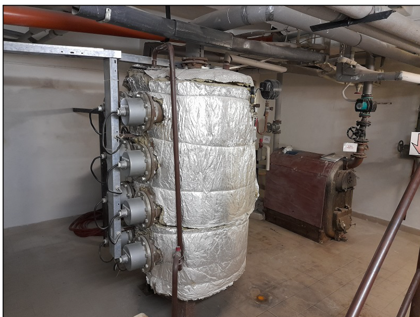
POHLED KOTELNA - ELEKTRICKÝ KOTEL
