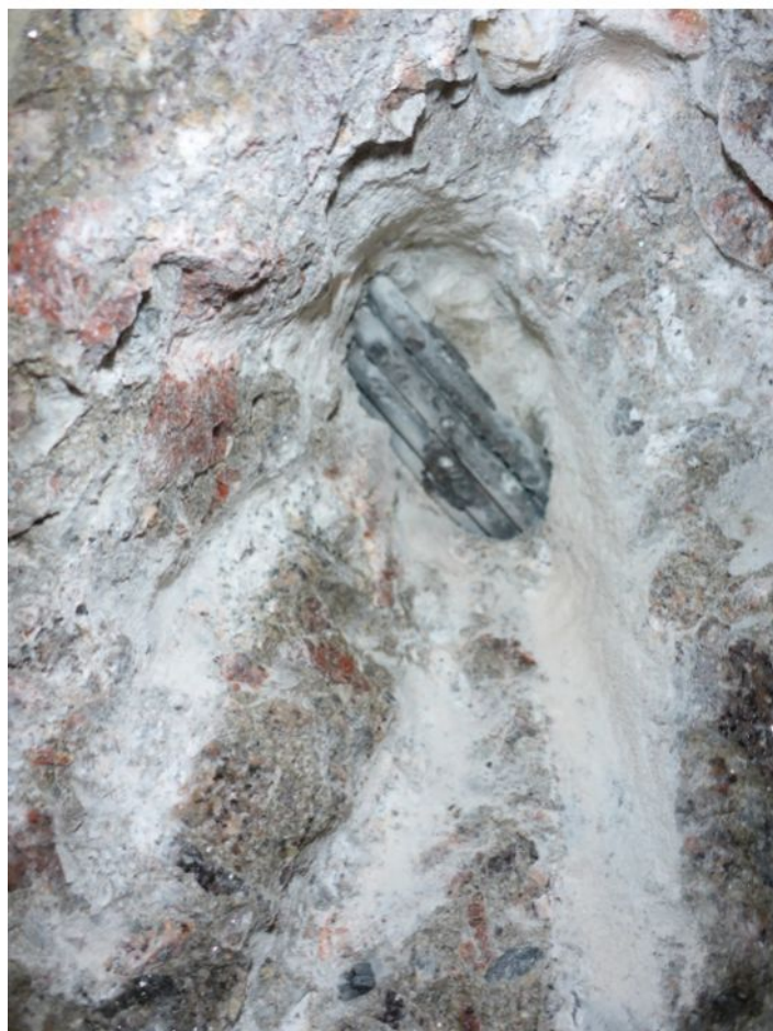
268 Sonda do kabelového kanálku k předpínací výztuži - pole 3
