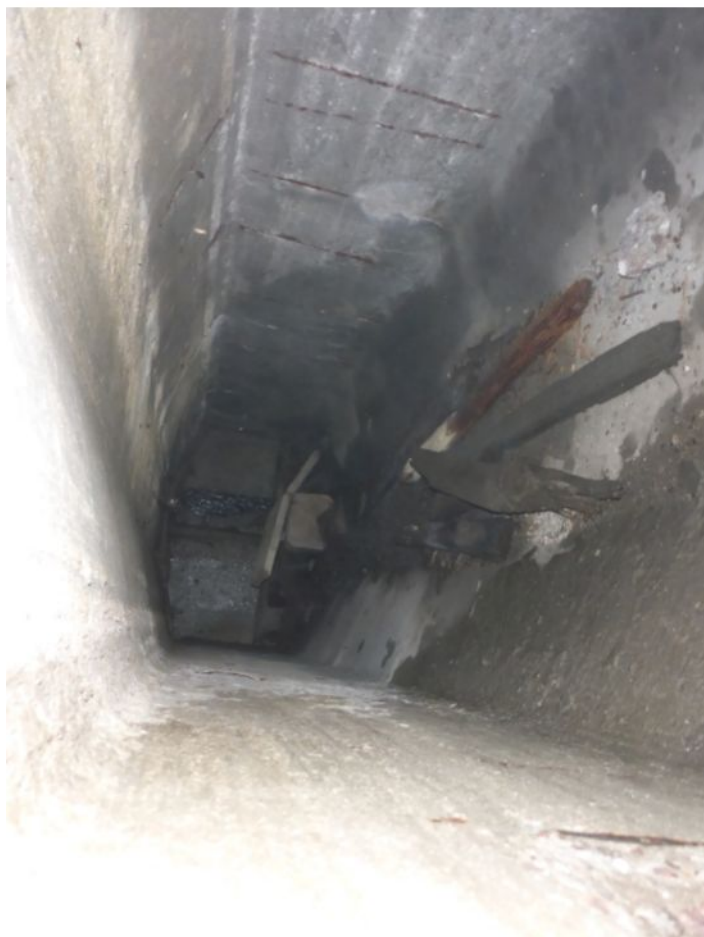
257 Sonda do nosníku - pole 3 - pravá strana - JV2
