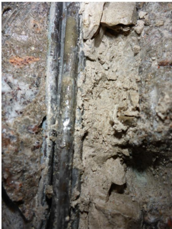
273 Sonda do kabelového kanálku k předpínací výztuži - pole 3
