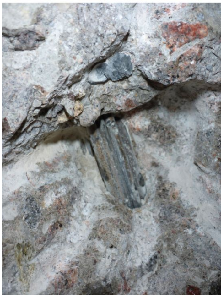
267 Sonda do kabelového kanálku k předpínací výztuži - pole 3
