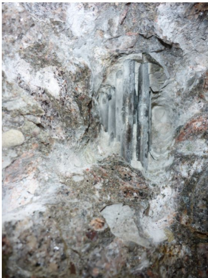
259 Sonda do kabelového kanálku k předpínací výztuži - pole 1
