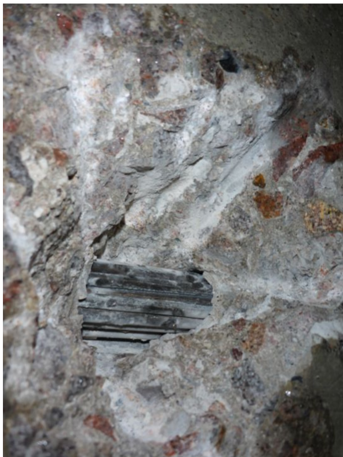
265 Sonda do kabelového kanálku k předpínací výztuži - pole 3
