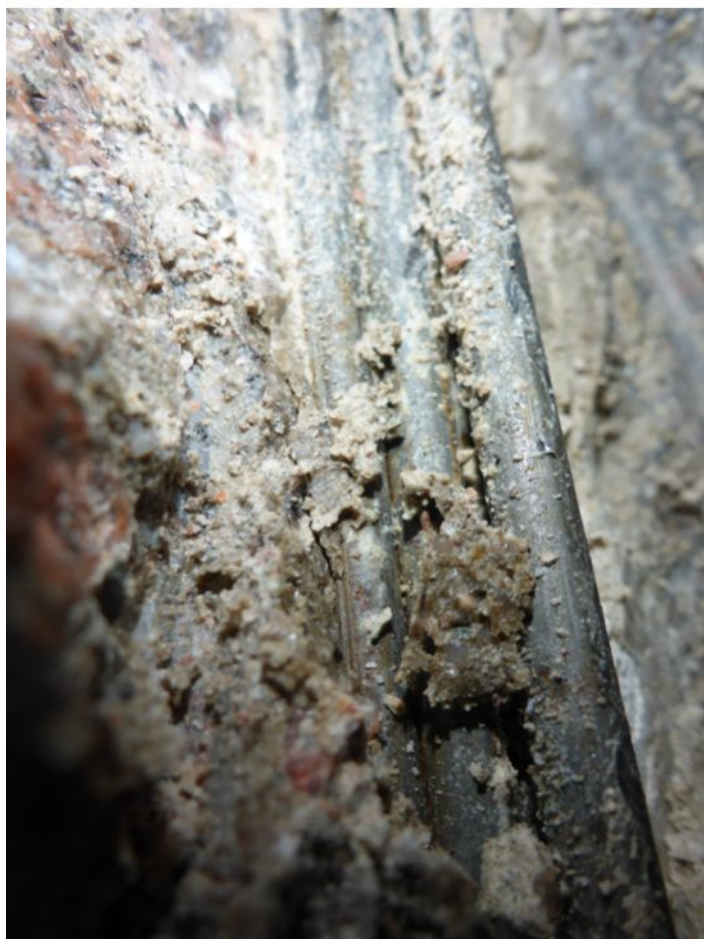
275 Sonda do kabelového kanálku k předpínací výztuži - pole 3
