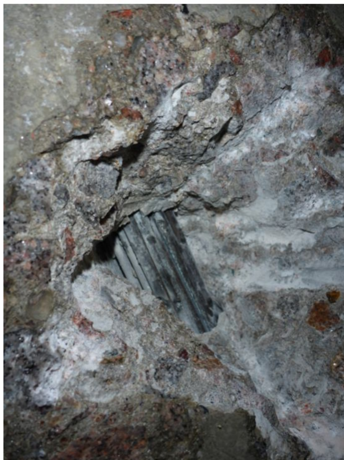
264 Sonda do kabelového kanálku k předpínací výztuži - pole 3
