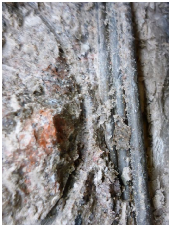
274 Sonda do kabelového kanálku k předpínací výztuži - pole 3
