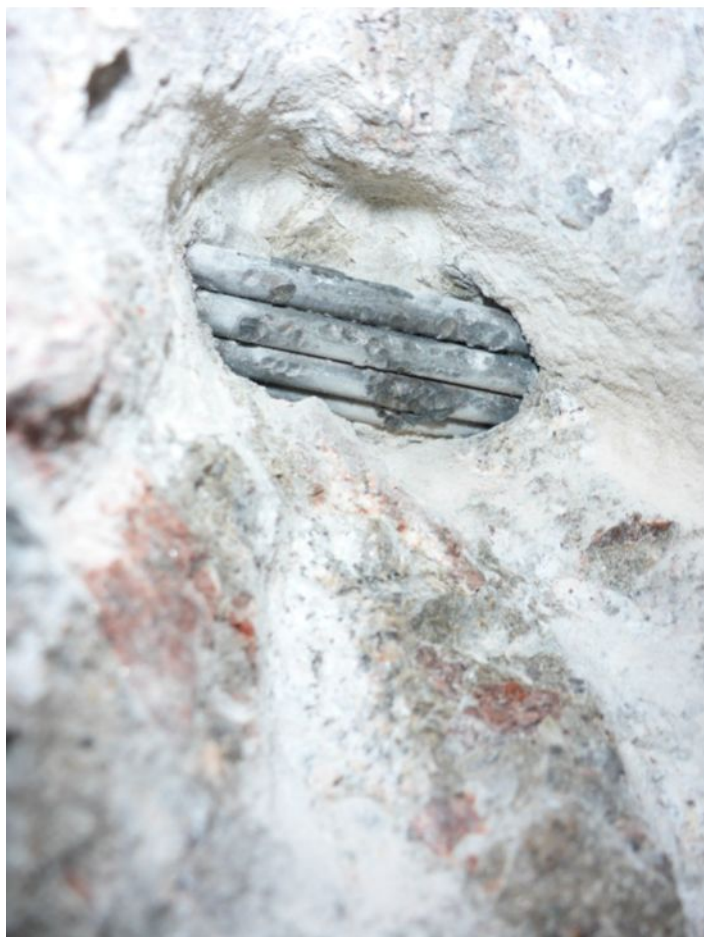
269 Sonda do kabelového kanálku k předpínací výztuži - pole 3
