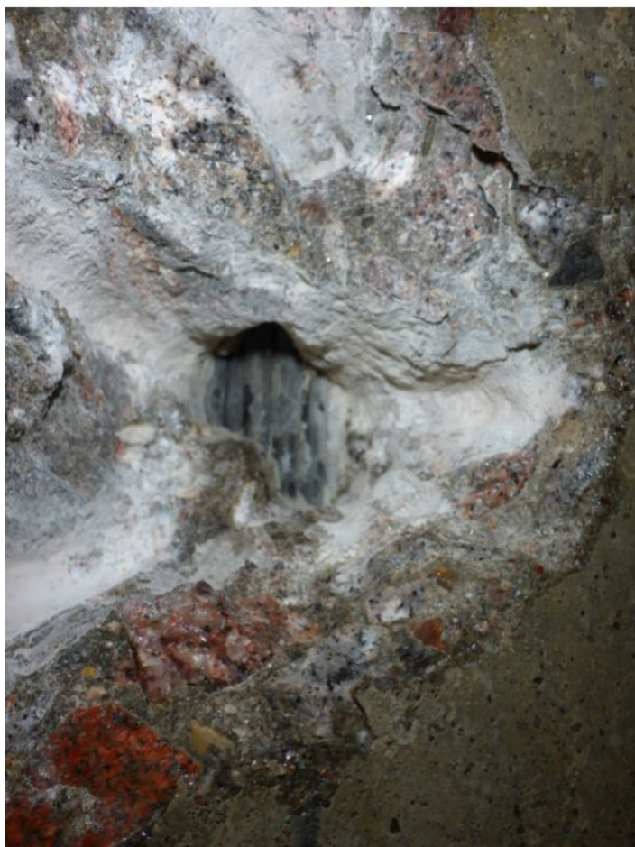
263 Sonda do kabelového kanálku k předpínací výztuži - pole 1
