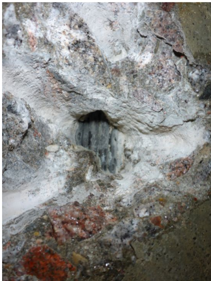
262 Sonda do kabelového kanálku k předpínací výztuži - pole 1
