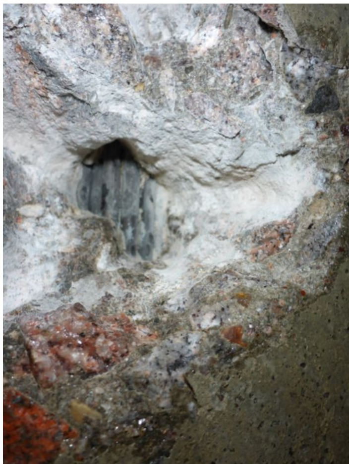
261 Sonda do kabelového kanálku k předpínací výztuži - pole 1
