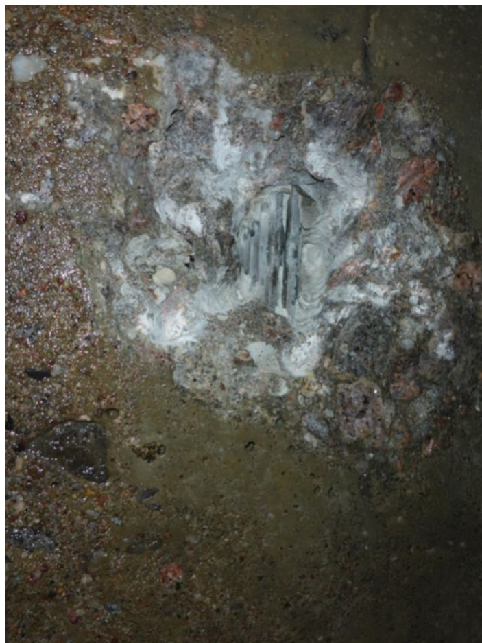
258 Sonda do kabelového kanálku k předpínací výztuži - pole 1
