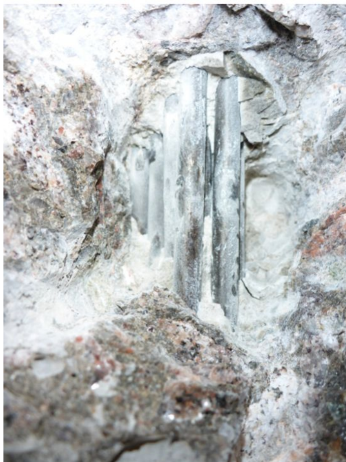
260 Sonda do kabelového kanálku k předpínací výztuži - pole 1
