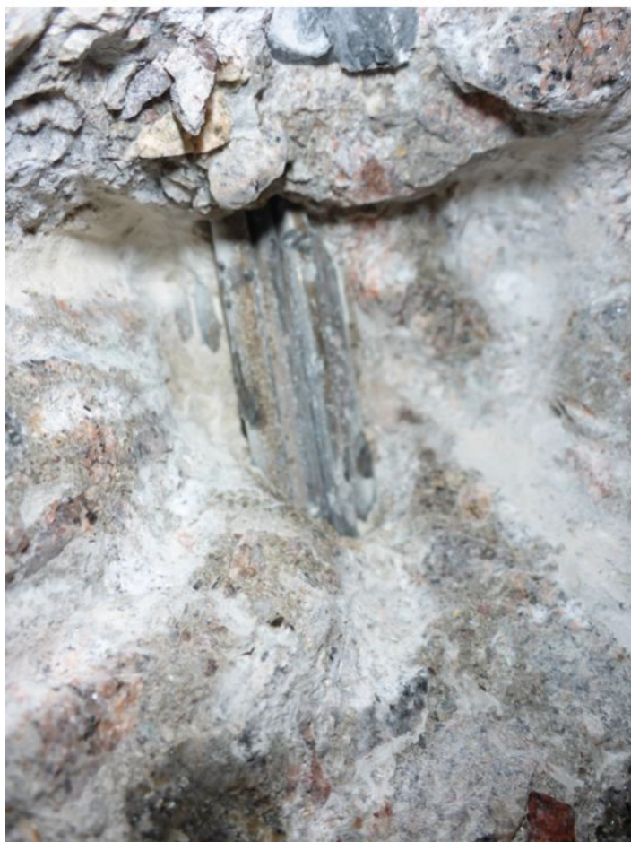
271 Sonda do kabelového kanálku k předpínací výztuži - pole 3
