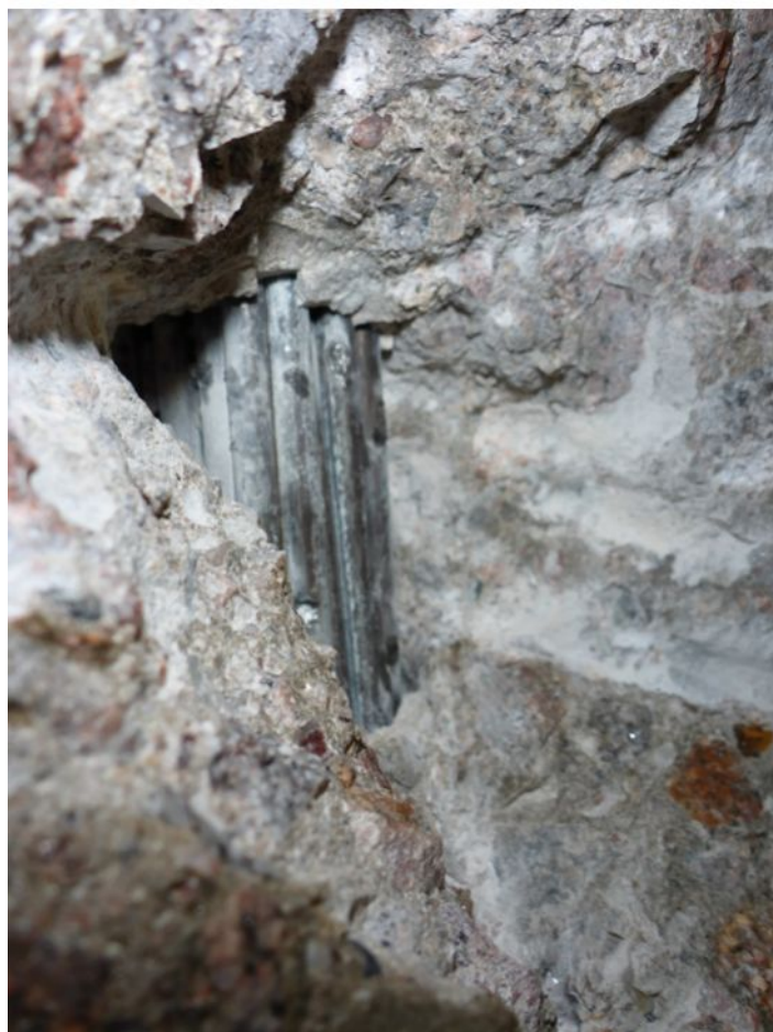
272 Sonda do kabelového kanálku k předpínací výztuži - pole 3
