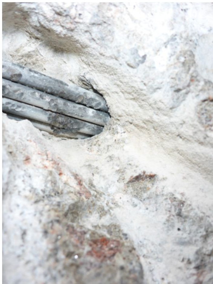
270 Sonda do kabelového kanálku k předpínací výztuži - pole 3
