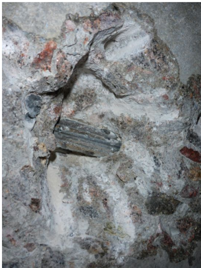
266 Sonda do kabelového kanálku k předpínací výztuži - pole 3
