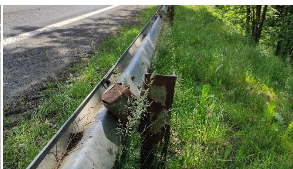
Poškozená svodidla
