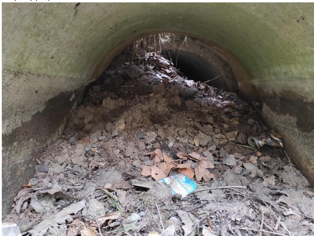
Propadlý propustek na levé straně ve směru staničení
