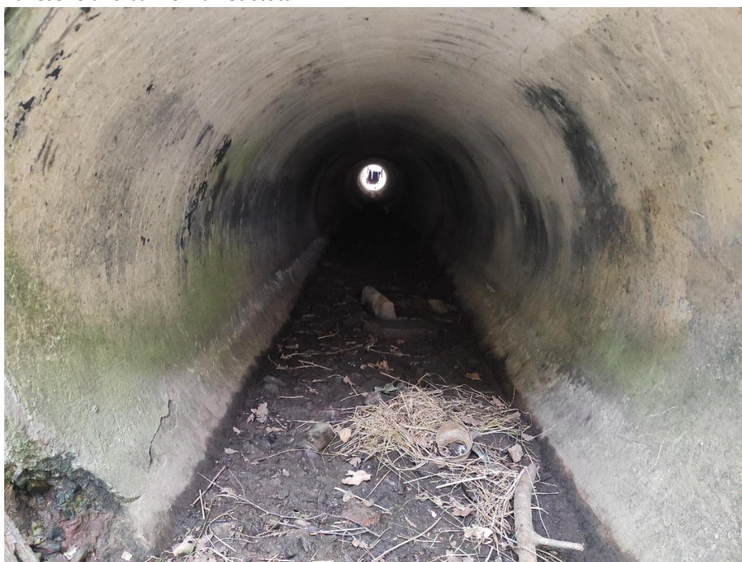
Zanesené dno bahnem a nečistotami.
