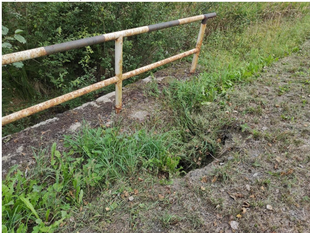
Propadlé místo na propustku na levé straně ve směru staničení
