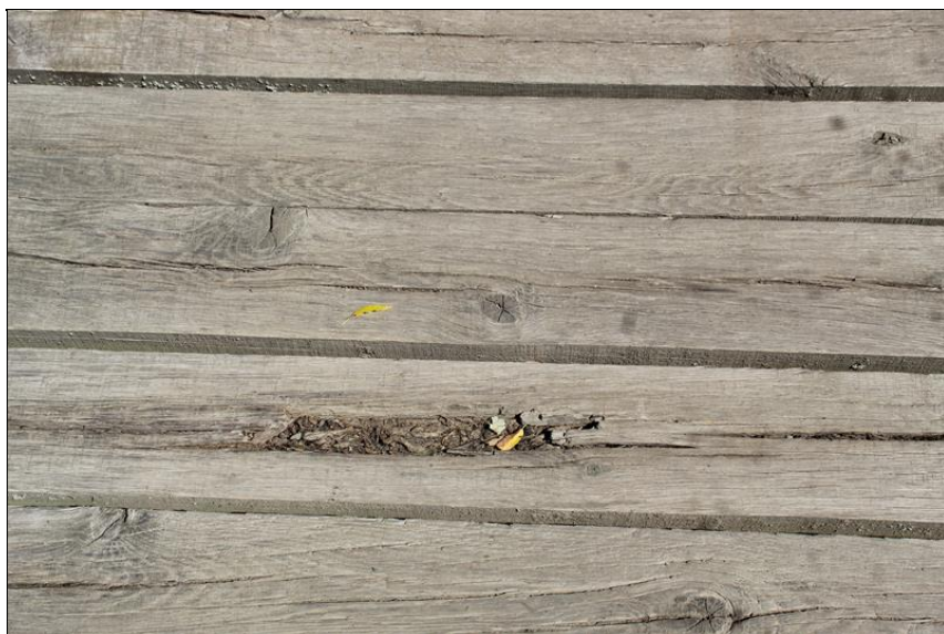
lokální hnilobný rozpad trámů mostovky
