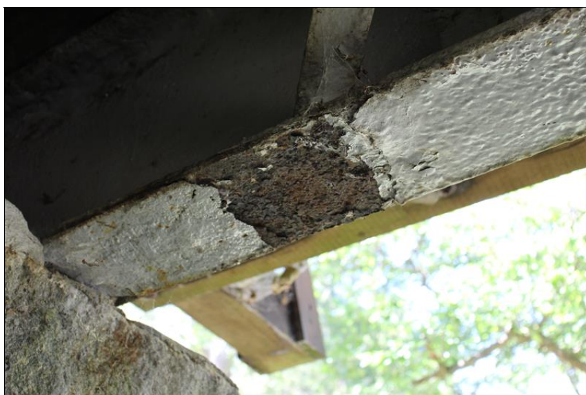
koroze spodní pásnice levého nosníku u OP1
