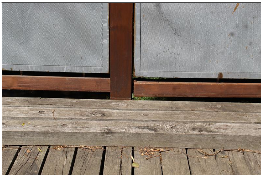
svislá deformace zábradlí vlevo
