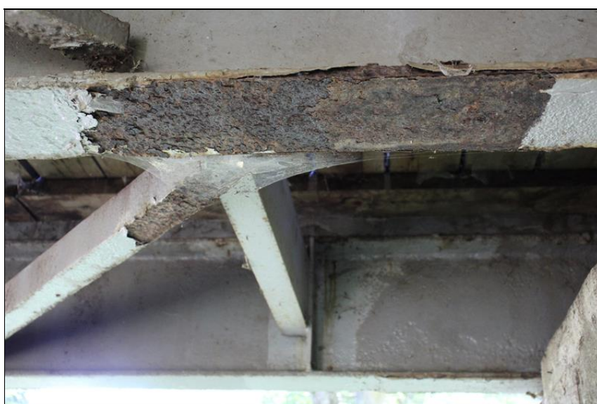
koroze pásnice 2. nosníku zprava a zavětrovacího profilu
