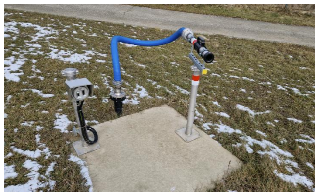
Obr. 2 dispenzor stacionárního systému rozstřiku těžké pěny
