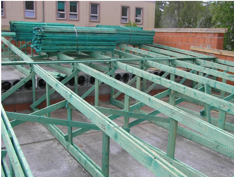
Dřevěné střešní vazníky
