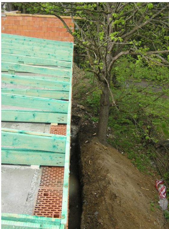
Ukončení vazníků u okapní hrany
