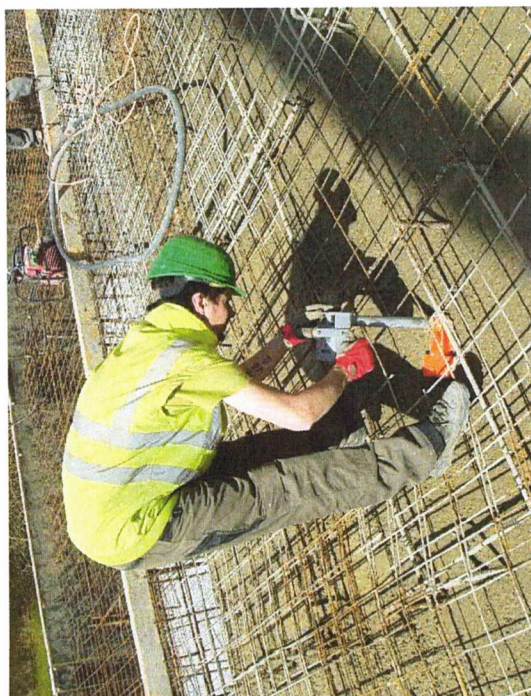
Obr.5 Radiometrická kontrola zhutněného čerstvého betonu v bednění ve stropě
