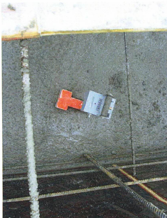
Obr.4 Radiometrická kontrola zhutněného čerstvého betonu v bednění ve stěnách
