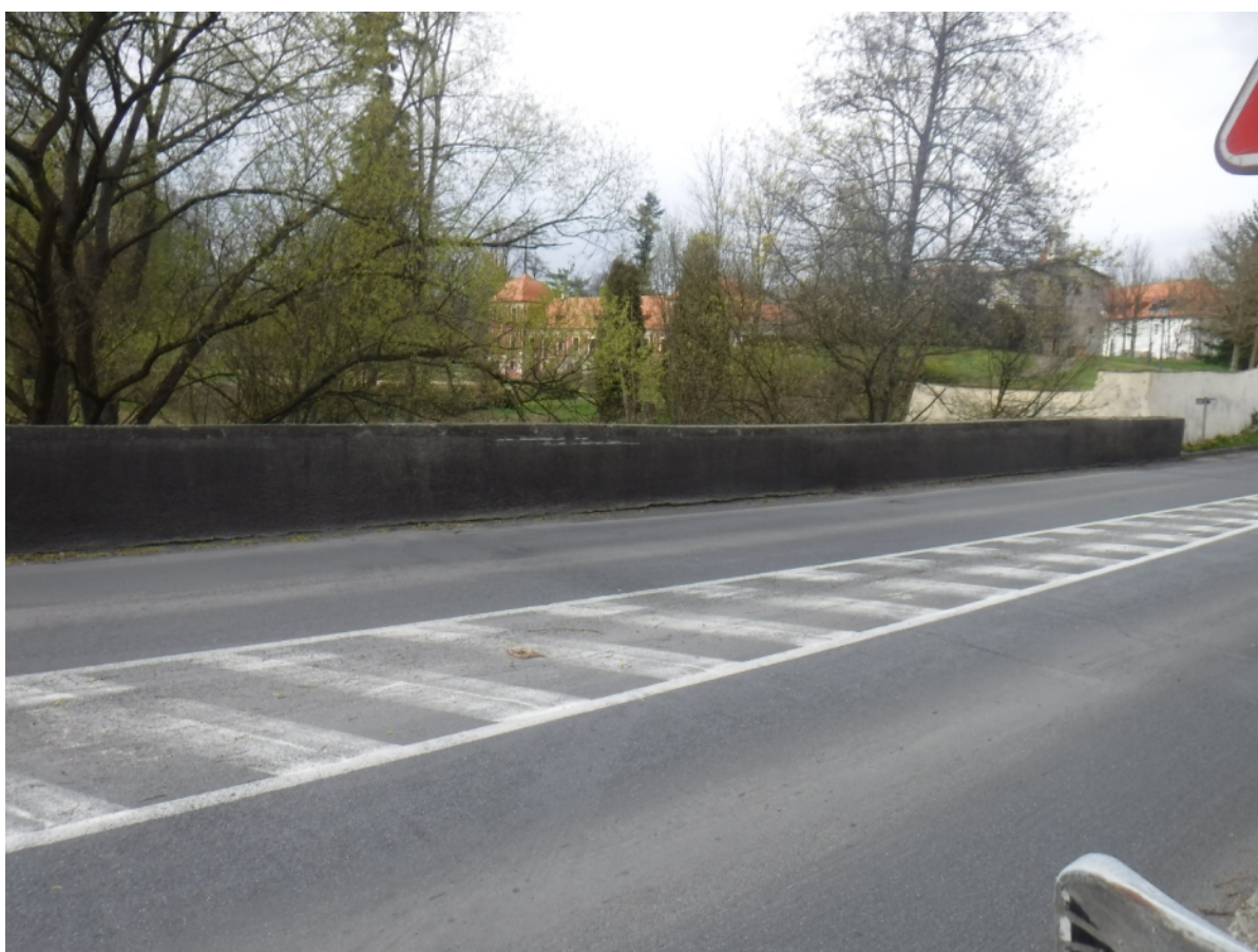
50 Poruchy poprsní zdí - zábradlí - spára nad úrovní vozovky
