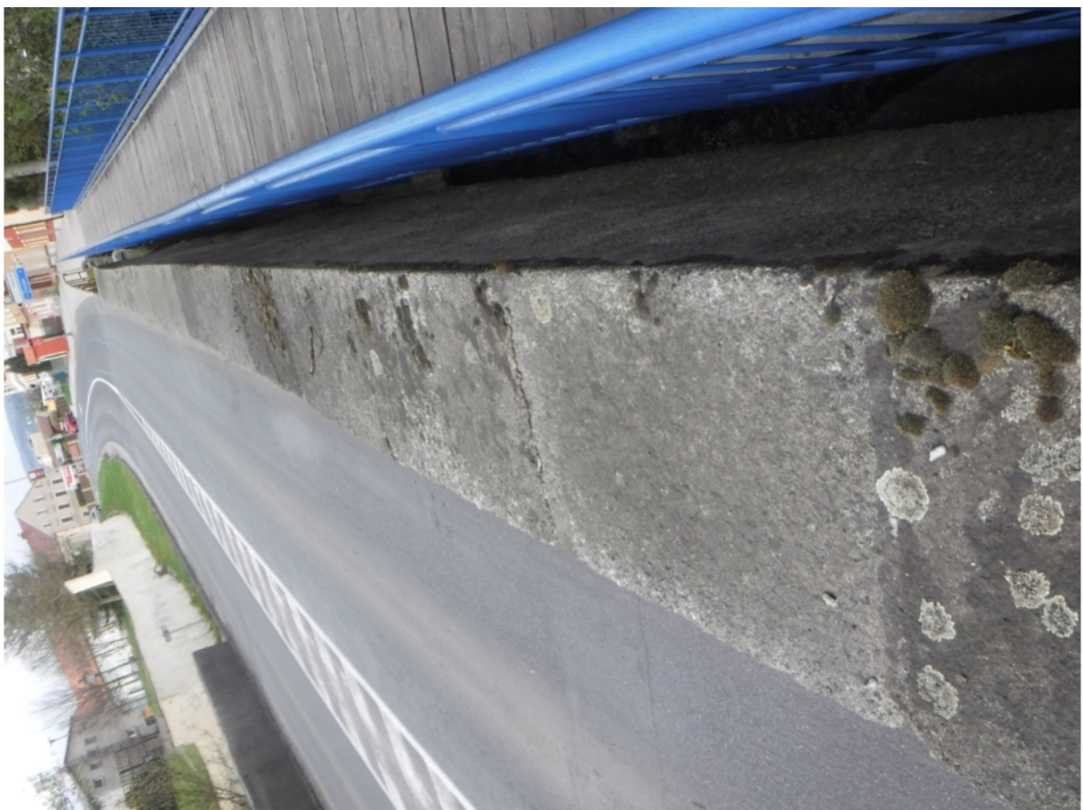
54 Poruchy poprsní zdí - zábradlí
