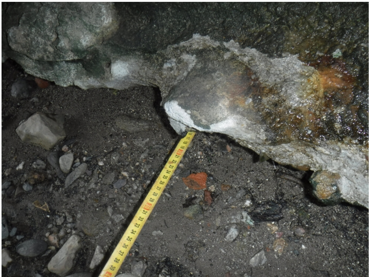
39 Opěra 2 - Odplavený materiál v patě opěry
