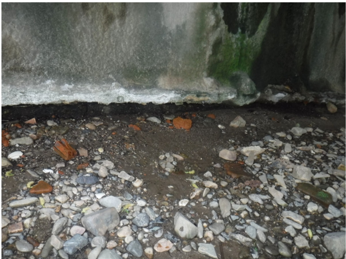
38 Opěra 2 - Odplavený materiál v patě opěry
