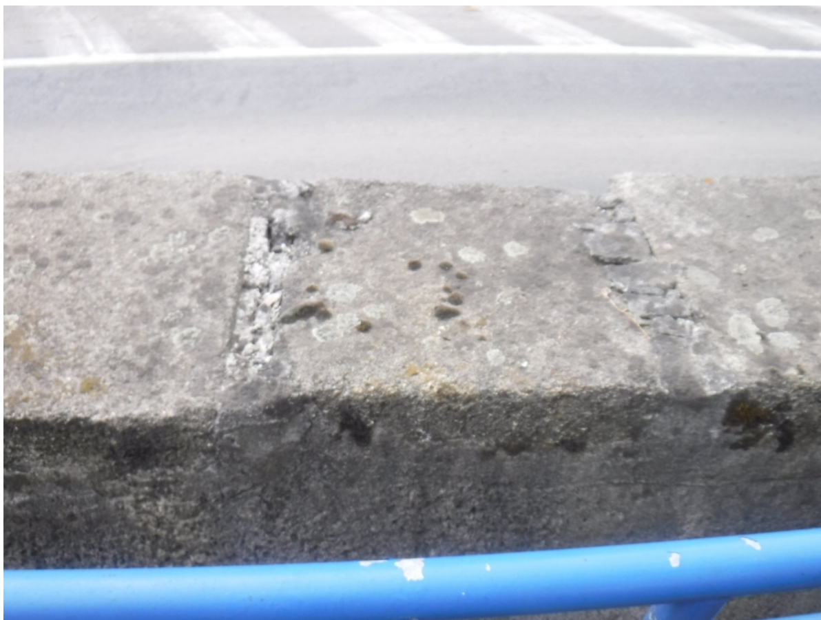
55 Poruchy poprsní zdí - zábradlí
