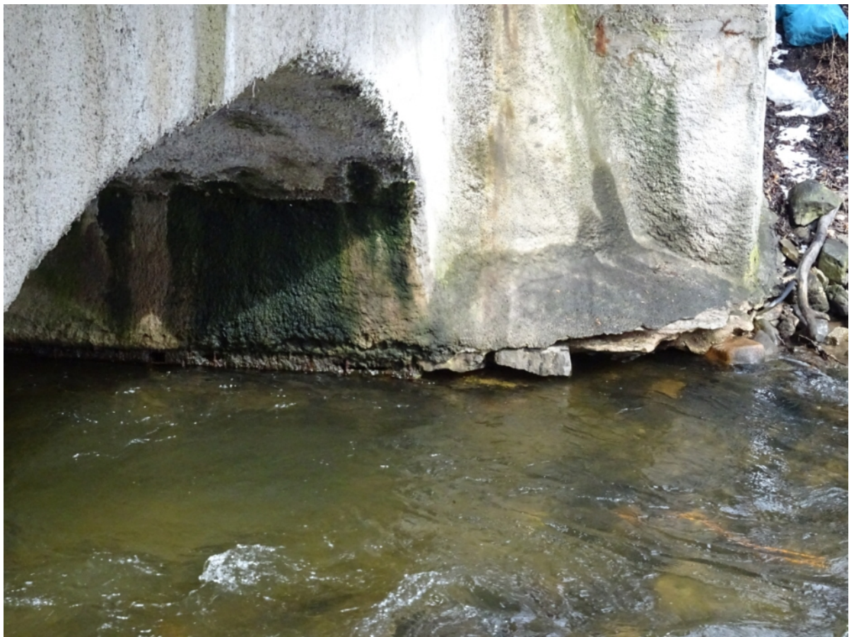
25 Pohled na opěru 1 z povodní strany - detail - odplavený materiál v patě
