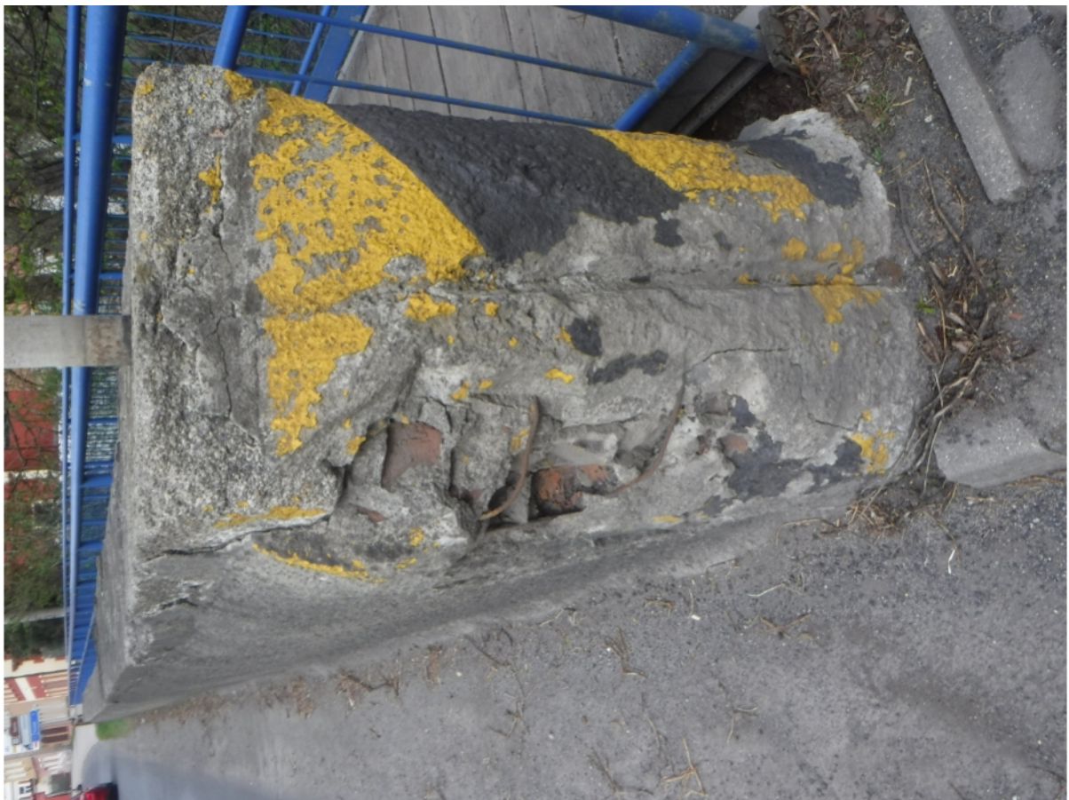
51 Poruchy poprsní zdí - zábradlí - poškození v důsledku ostřiku
