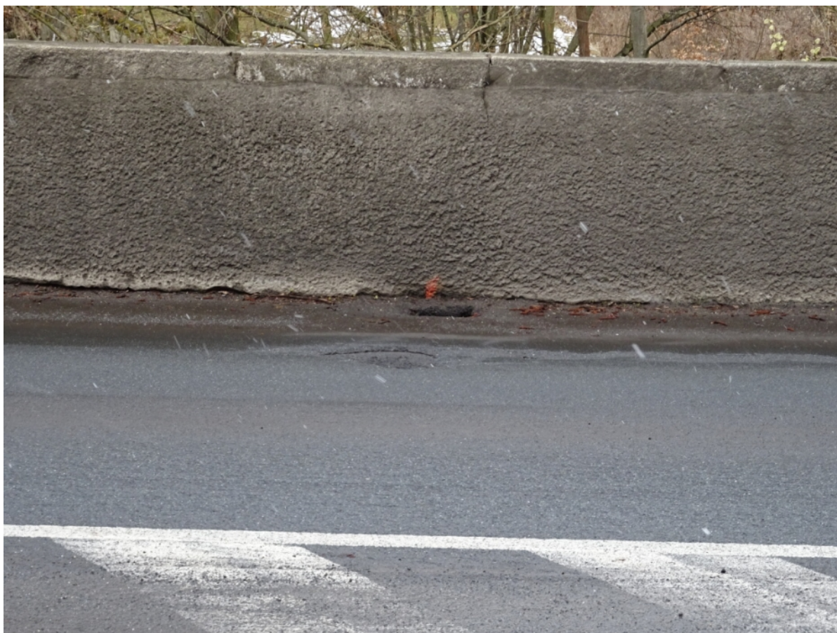
49 Poruchy poprsní zdí - zábradlí - spára nad úrovní vozovky - výtluk
