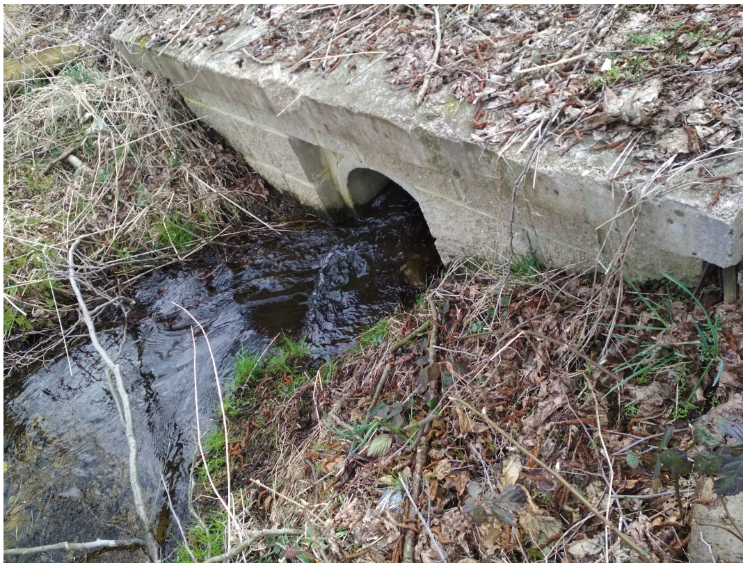
Obrázek 1 Propust km 2,500 Pohled na vtok
