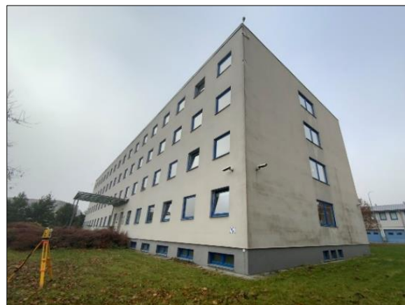
Budova B z úrovně terénu
