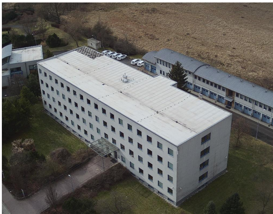
Budova B, letecký pohled
