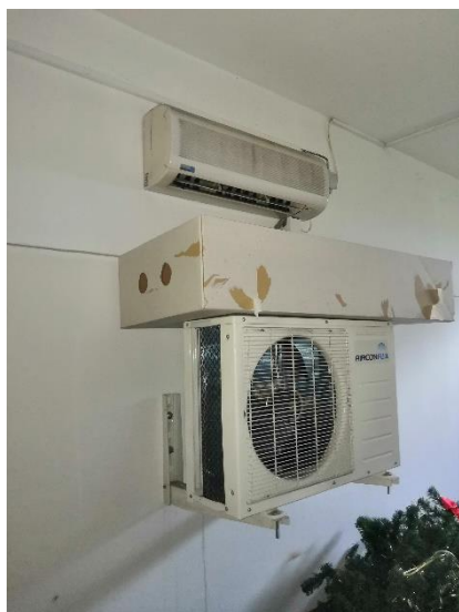
Obr. č. 13 – Atypické provedení vnitřní a vnější klimatizační jednotka pro odvlhčování suterénu
