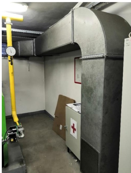
Obr. č. 9 – Rozvody VZT v kotelně
