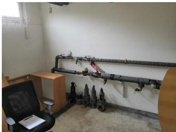
Obr. č. 6 – Hlavní uzavěr vody a vodoměry pro objekt
