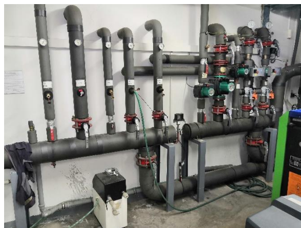
Obr. č. 3 – Pohled na rozdělovač/sběrač
