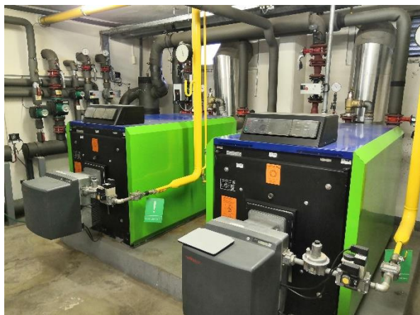
Obr. č. 2 – Stávající plynové kotle a hořáky
