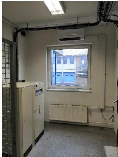
Obr. č. 11 – Vnitřní klimatizační jednotka
