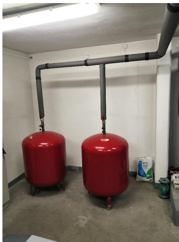
Obr. č. 5 – Expanzní zařízení v kotelně
