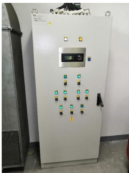
Obr. č. 16 – Rozvaděč MaR v kotelně
