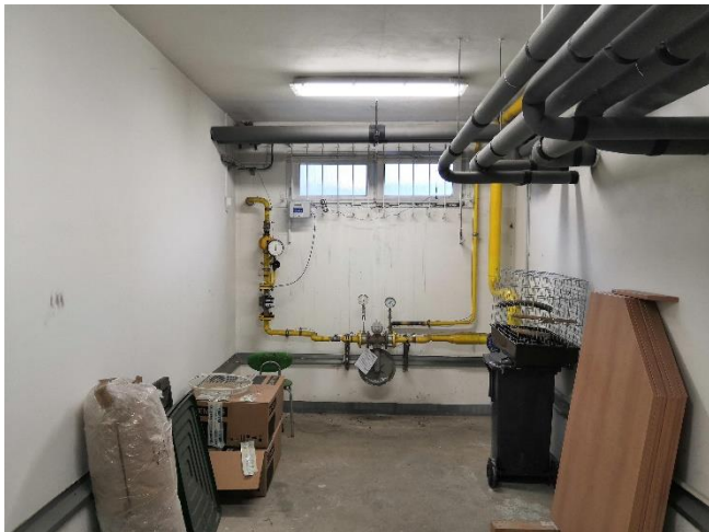
Obr. č. 14 – Místnost s regulátorem a plynoměrem
