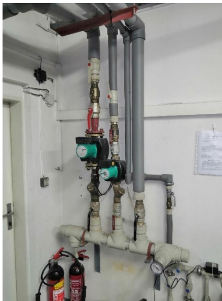
Obr. č. 8 – rozdělovač teplé vody
