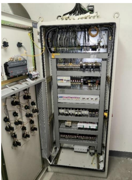
Obr. č. 17 – Rozvaděč MaR v kotelně
