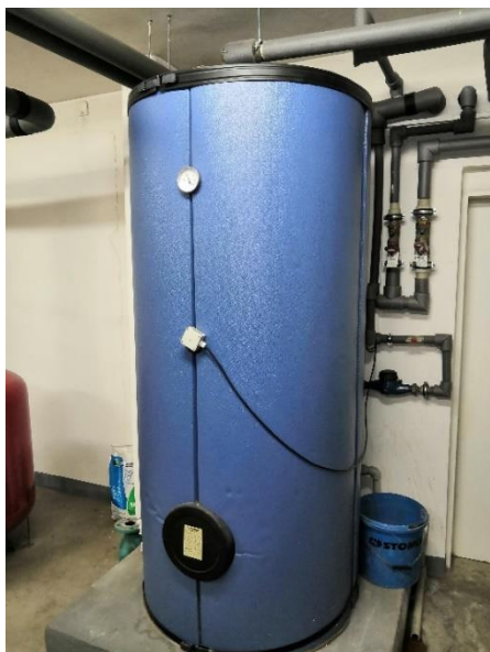
Obr. č. 7 – akumulační zásobníkový ohřívač
