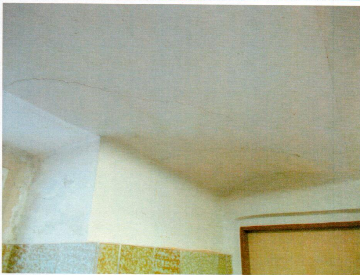
Trhliny v klenbě v JV rohu
