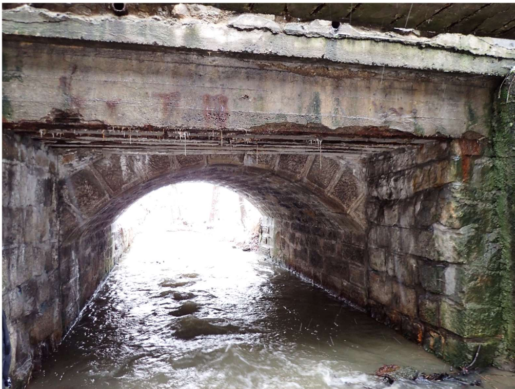
Obrázek č. 3: Pohled na most ze vtoku – zjevné je rozšíření mostu
