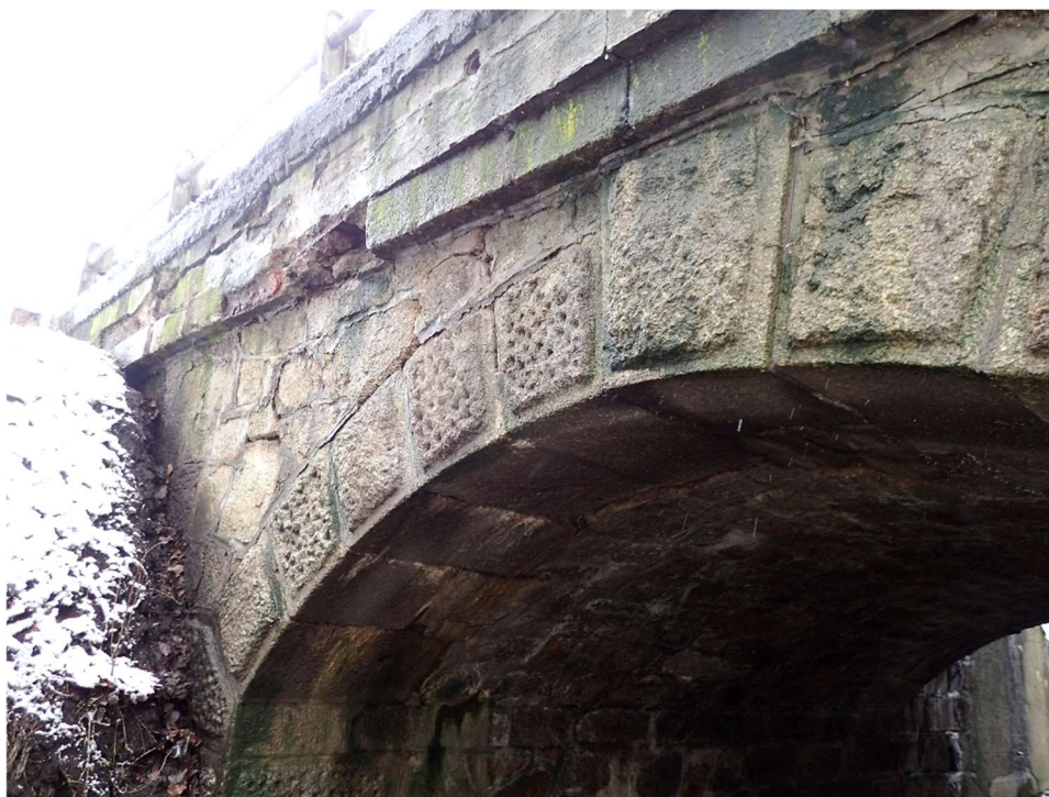
Obrázek č. 4: Pohled na most na výtoku – původní oblouková konstrukce mostu
