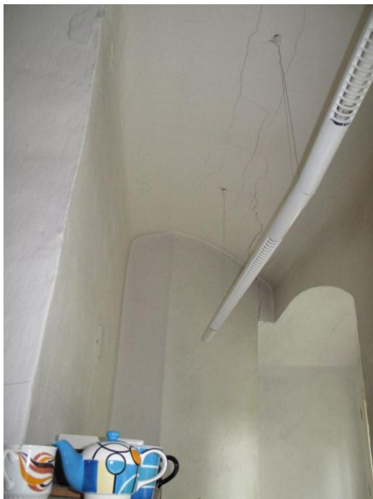
Pohled na podélnou trhlinu v klenbě
