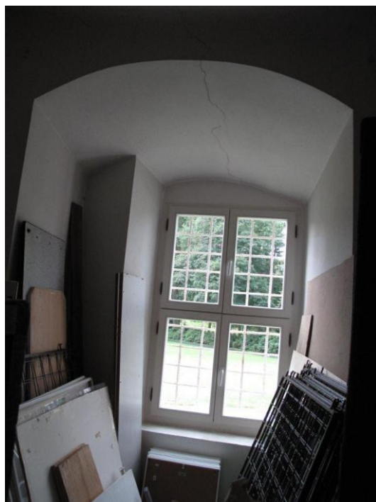
Pohled na trhlinu klenby nad okenním otvorem
