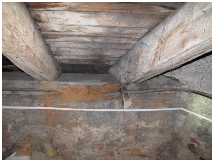
Pohled na napadené trámy krovu
