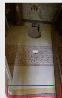
Obr. č.17 - 2.NP - původní dlažba 99% plochy, kromě prahu
