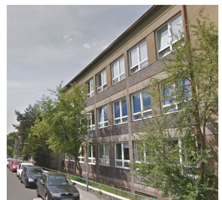
03 / Pohled na novodobou část školy, která bude v návrhu odstraněna a nahrazena novou výstavbou
