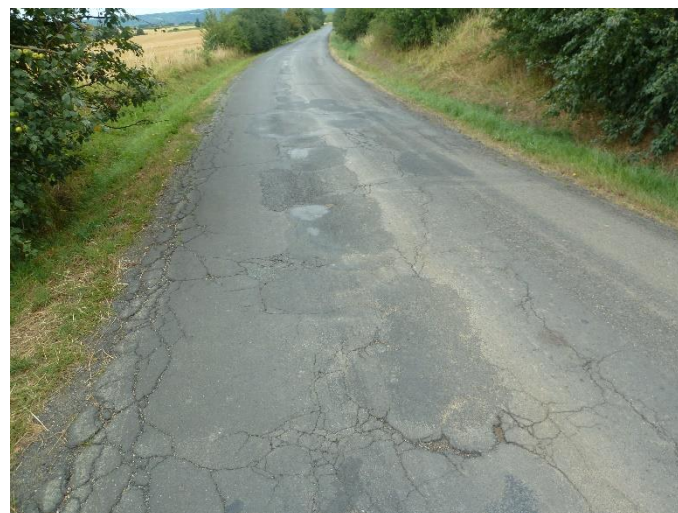
Detail poruchy vozovky
