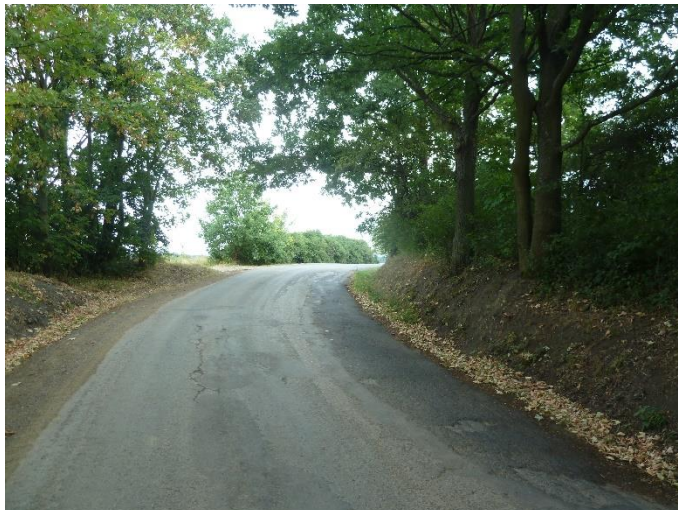
Detail poruchy vozovky
