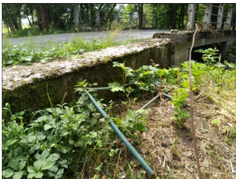
Chybějící zábradlí na levobřežním předmostí
