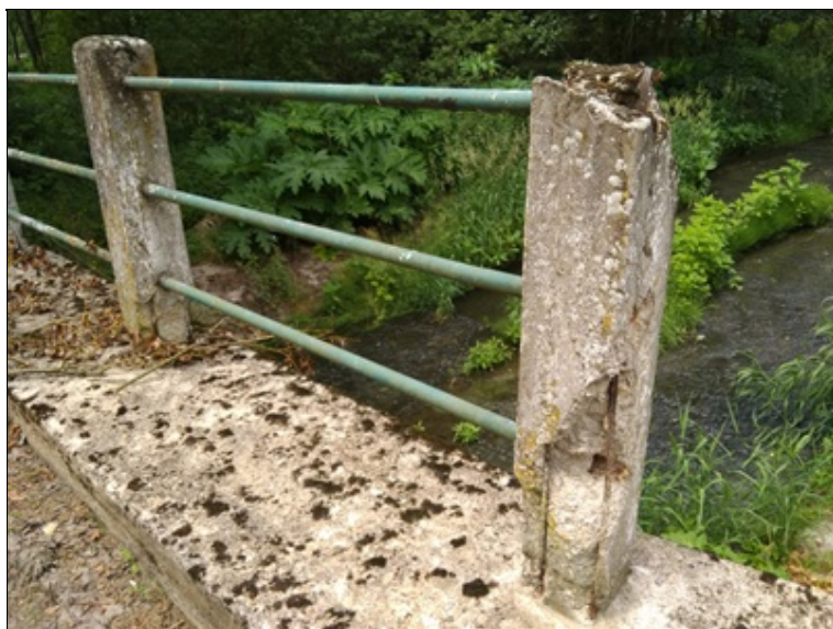
Poruchy sloupků zábradlí
