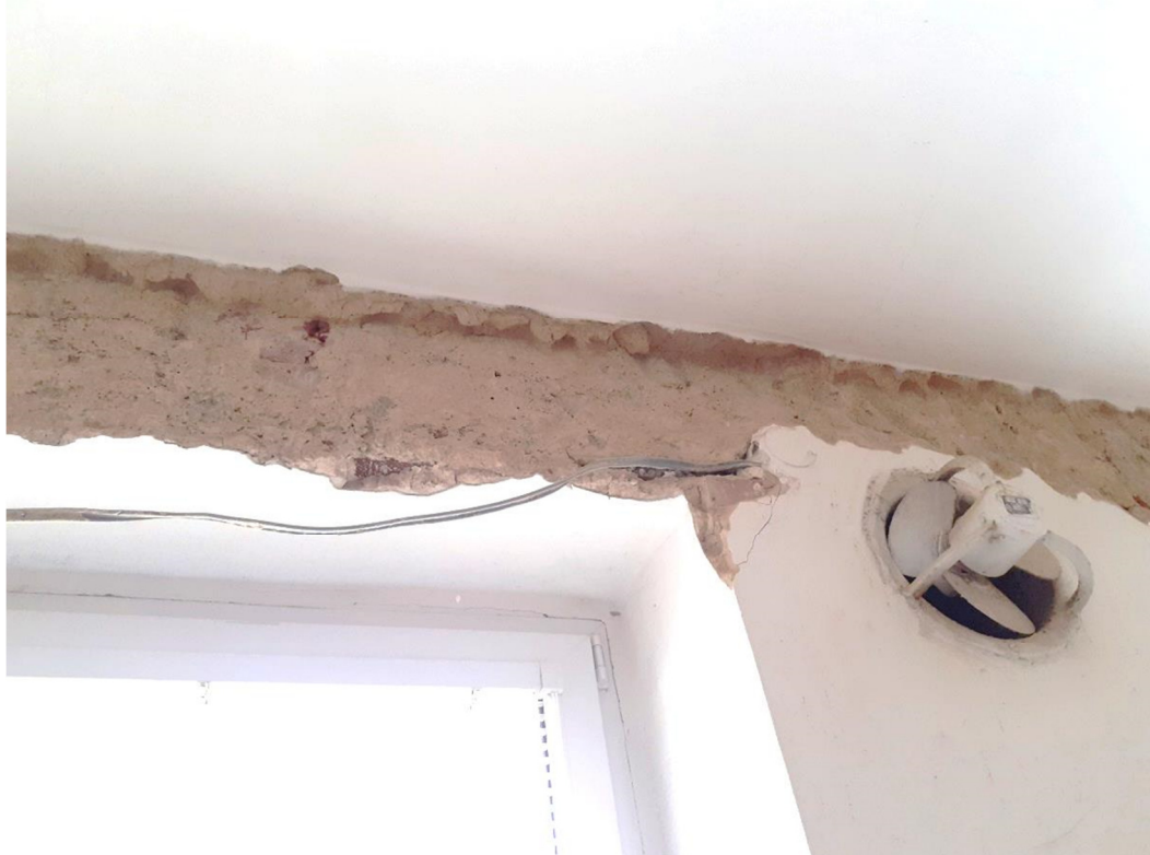
Obr.4: S5 – obvodové zdivo s ocelovými překlady
