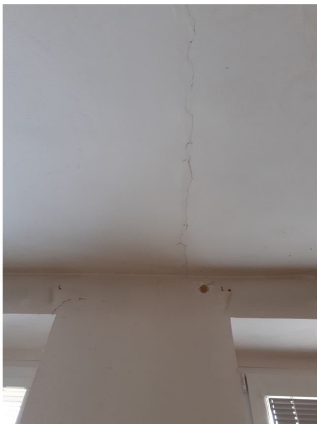
Obr.8: Trhlina přecházející do středního zdiva.
