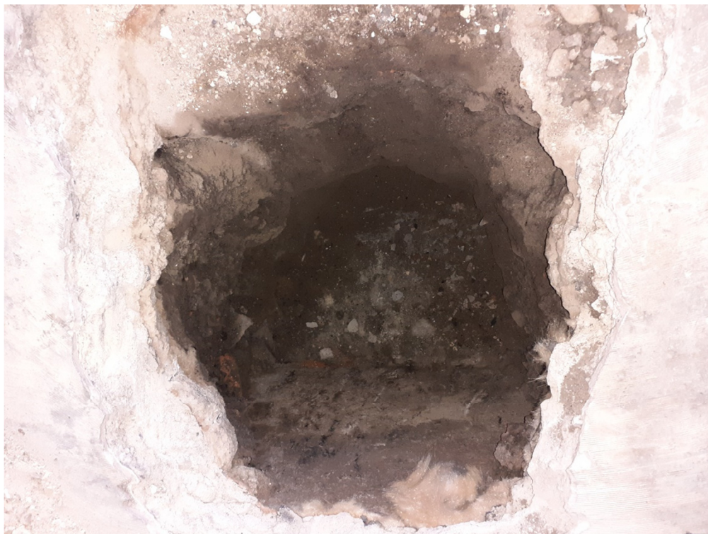
Obr.2: S3 – obvodový základový pas.
