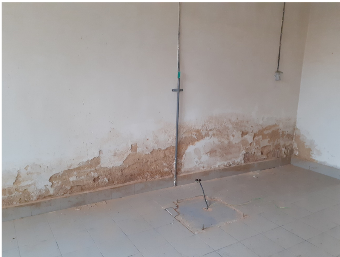
Obr.4: Zatékání do štítové stěny – degradovaná omítka.
