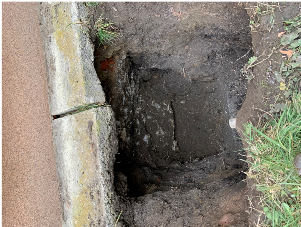
Obr.2: S3 – obvodový základový pas.
