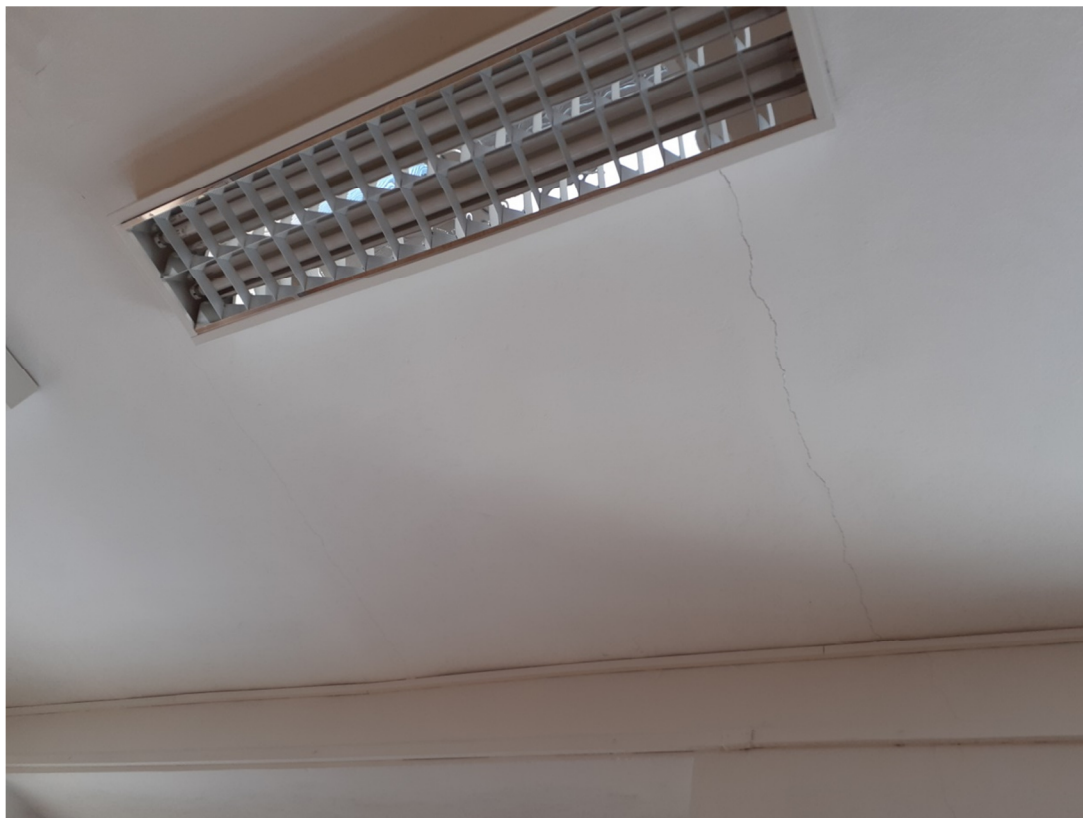
Obr.5: Prorýsované spáry stropních panelů.
