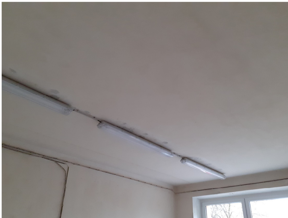
Obr.1: Zatečení do stropních panelů.
