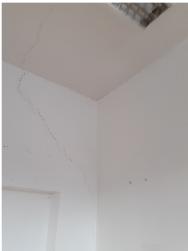
Obr.8: Trhlina přecházející do středního zdiva.
