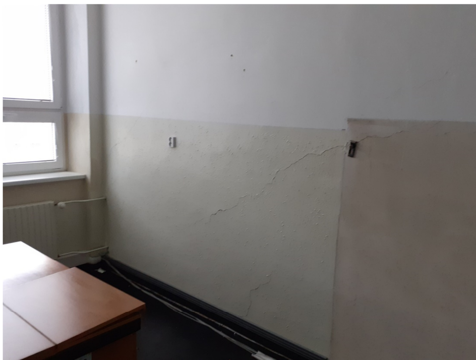
Obr.10: Prorýsaný obvod překlady okenního otvoru.
