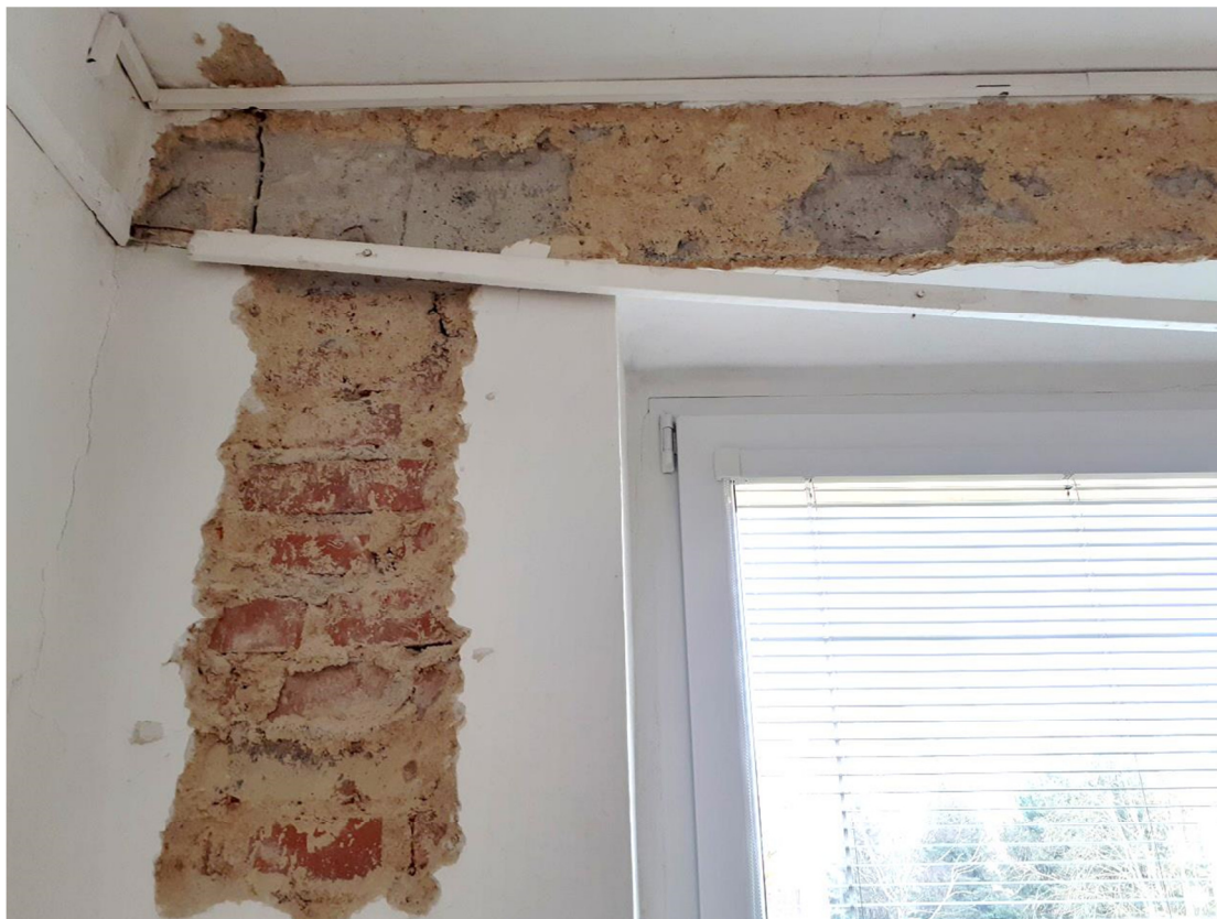
Obr.10: S6 - betonový překlad okna.
