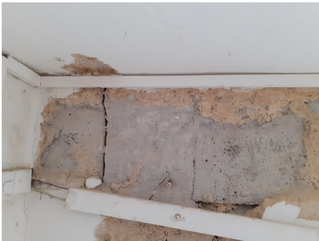
Obr.10: S6 - betonový překlad okna.
