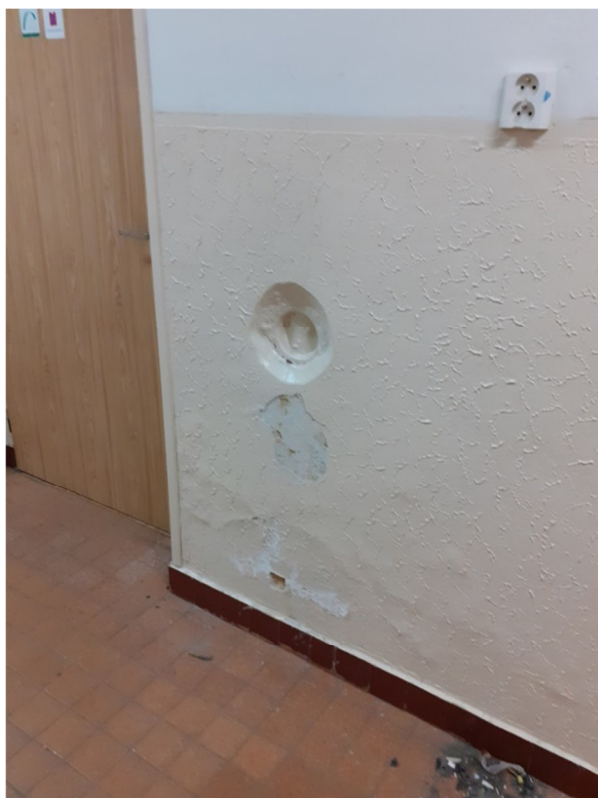
Obr.2: Detail čistícího otvoru dešťového svodu v chodbové stěně, porušená omítka.
