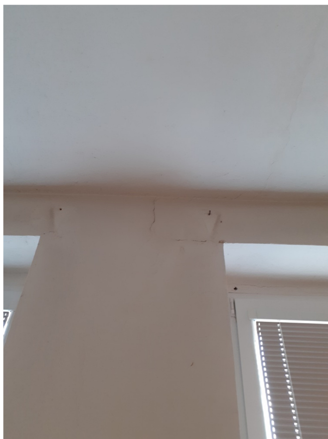
Obr.10: Prorýsaný obvod překlady okenního otvoru.
