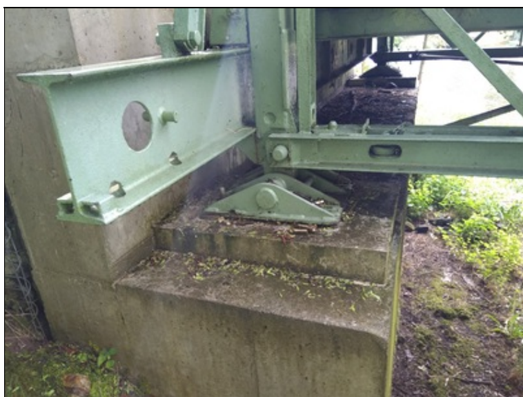
Uspořádání na úložném prahu pravobřežní opěry
