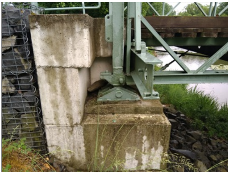
Uspořádání na úložném prahu pravobřežní opěry
