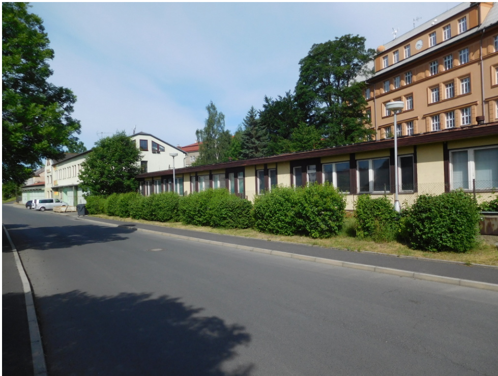
Pohled na objekt z jižní strany
