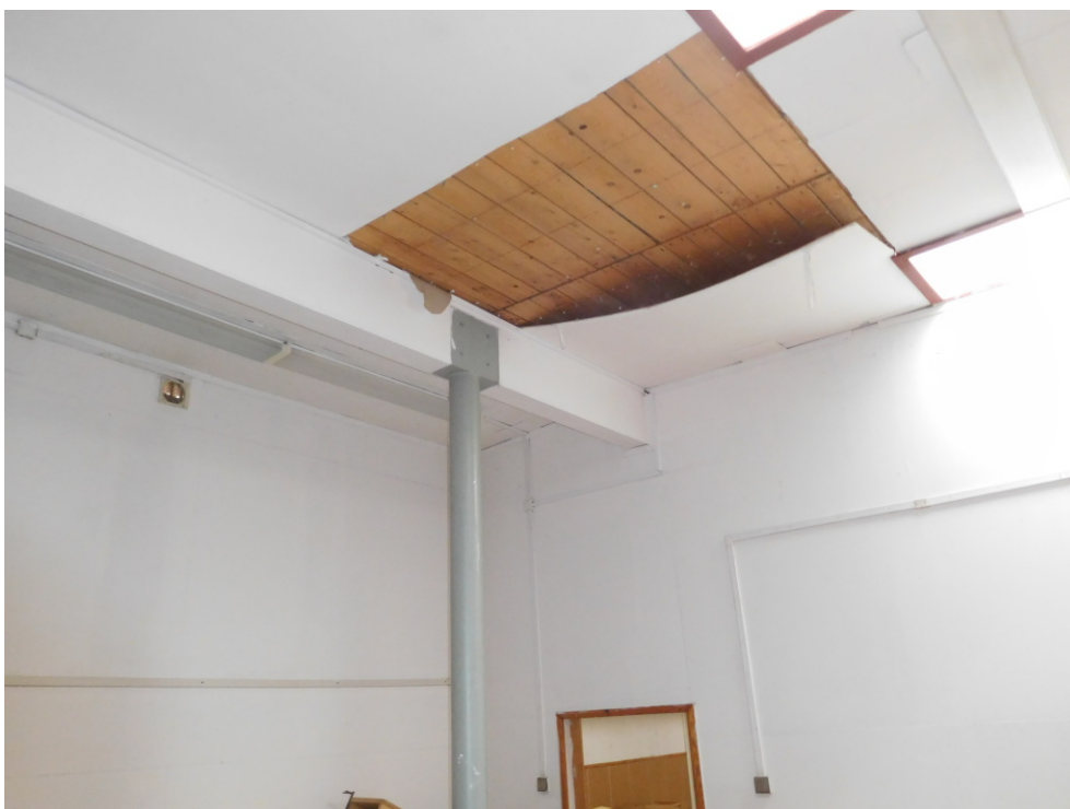
Pohled na konstrukci podhledu
