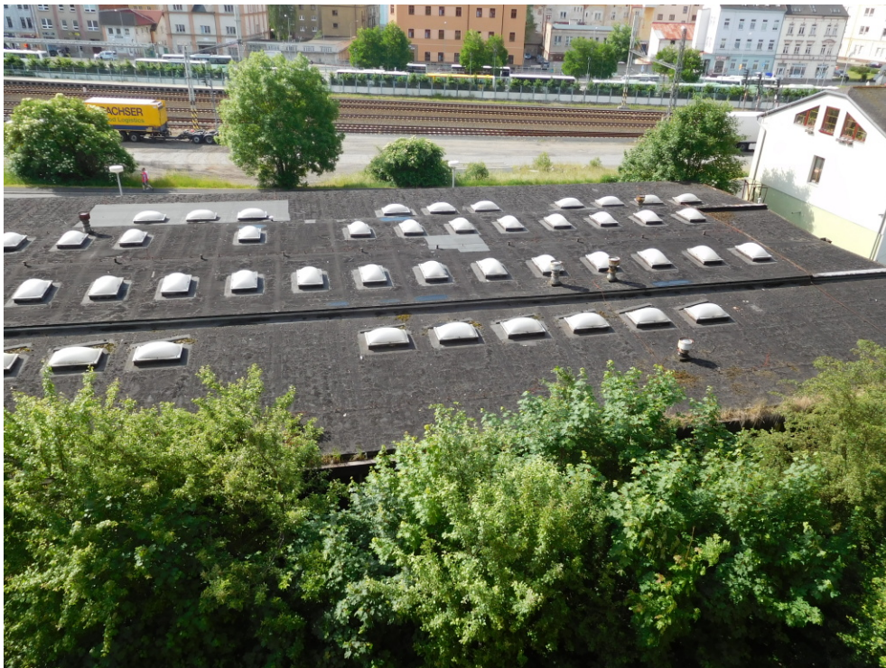
Pohled na střechu objektu ze severní strany
