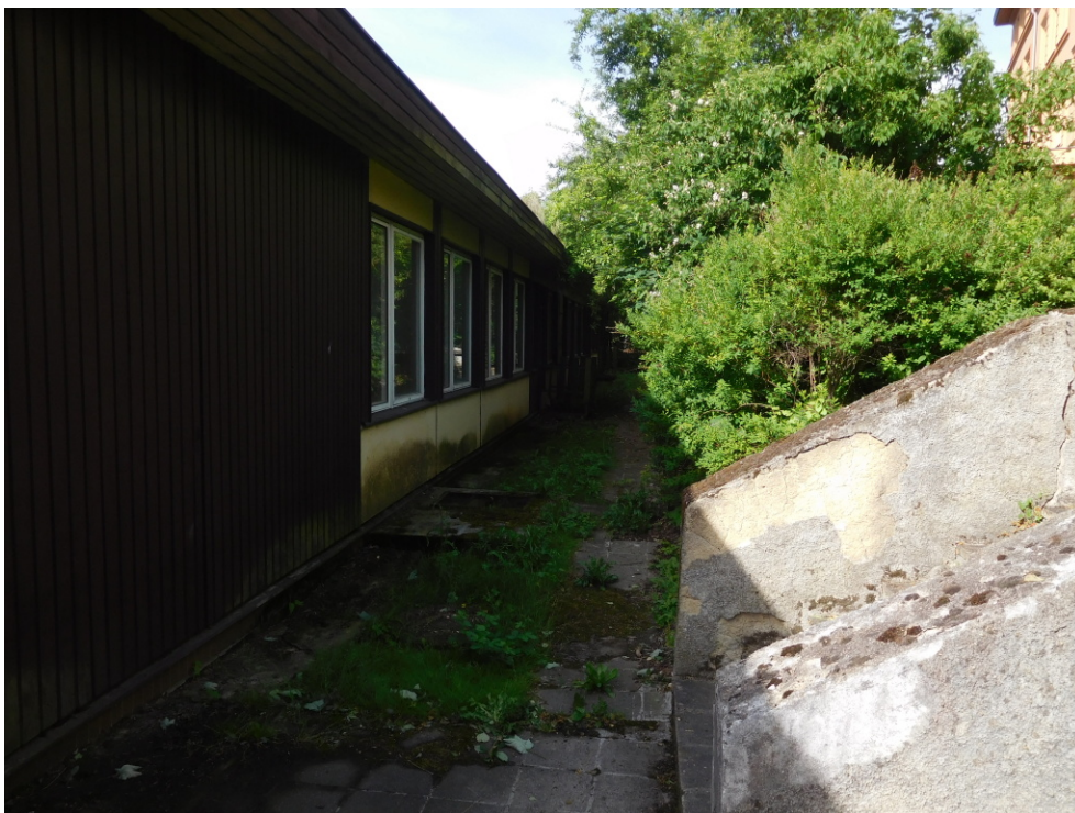
Pohled na objekt ze severní strany
