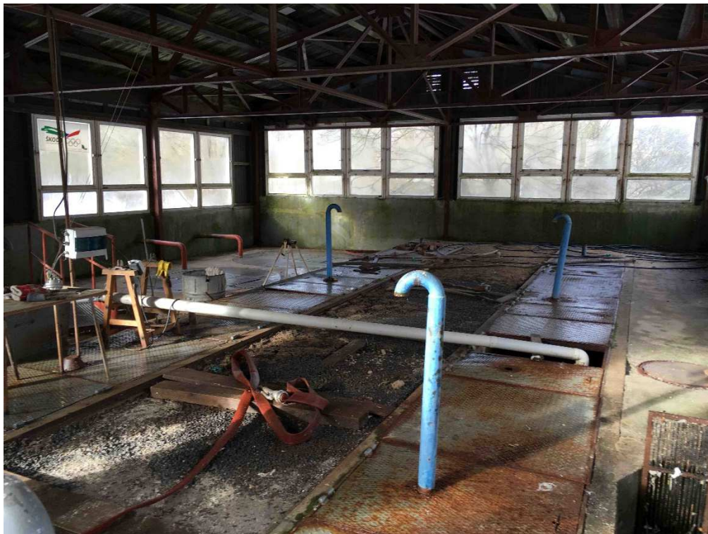
snímek pochozí části ČOV
