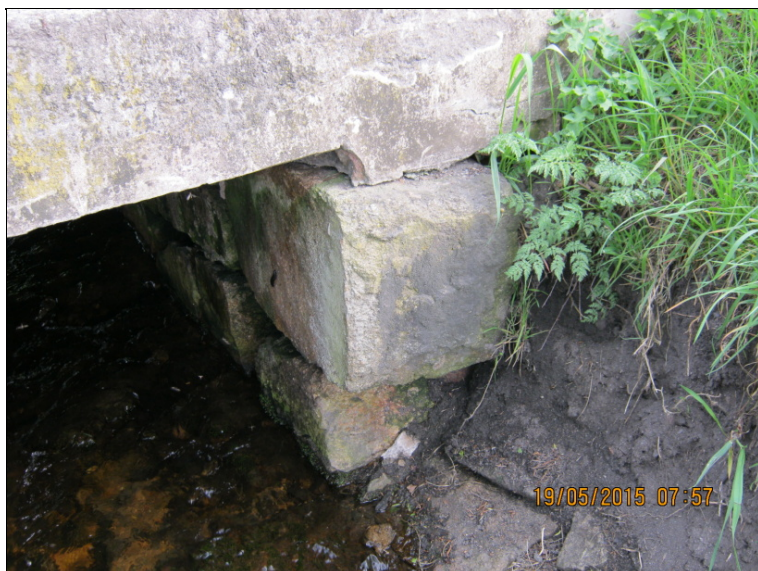
vyplavené spárování kamenných opěr vpravo u OP2
