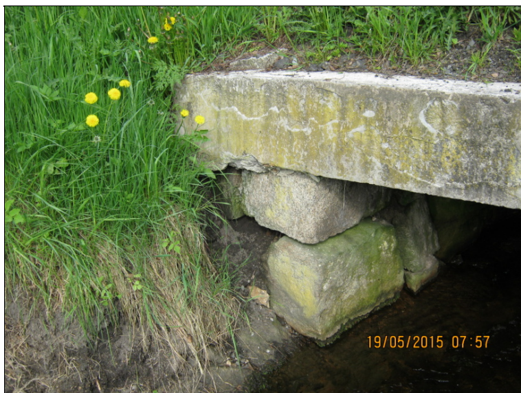
vyplavené spárování kamenných opěr vpravo u OP1
