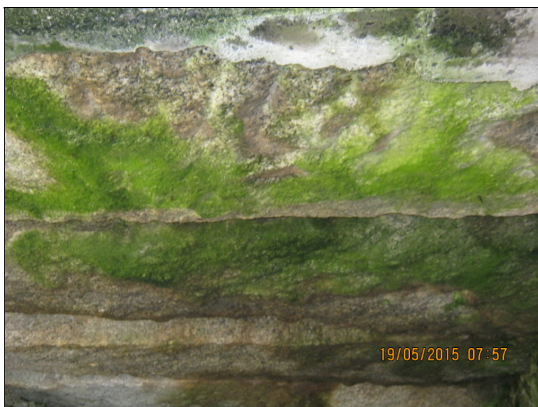
podhled NK - kamenné překlady, vlhké pokryté řasami
