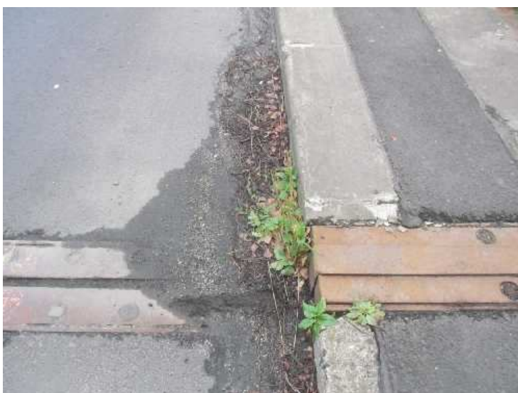
usazování nečistot a růst vegetace na kraji vozovky
