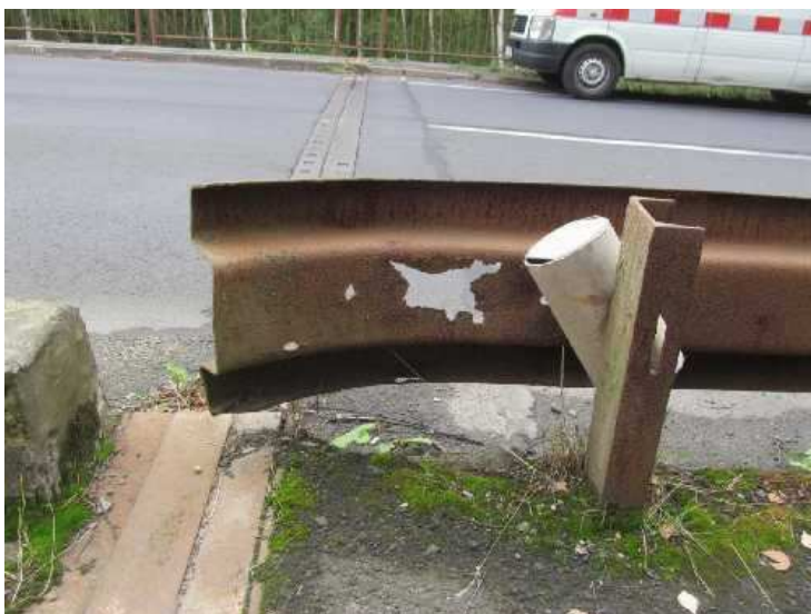
prokorodovaná svodnice levého svodidla na předpolí opěry OP1
