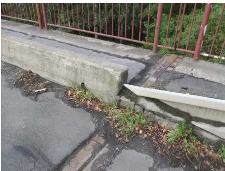
pohled na zvýšenou obrubu levého chodníku v místě mostního závěru nad OP4
