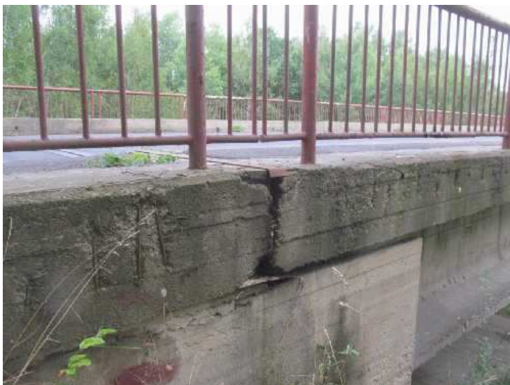
pohled na pravý bok opěry OP1, beton říms degradovaný, lokálně odpadá krycí vrstva výztuže
