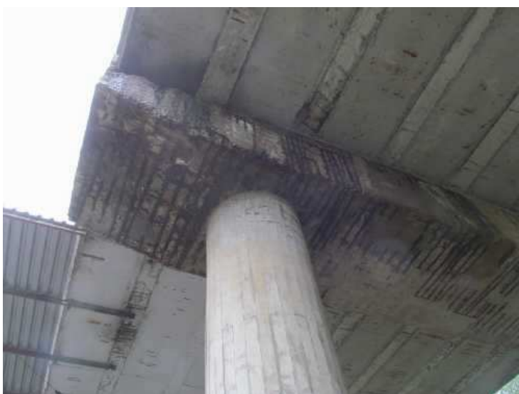
pohled na pravou část stativa podpěry P3, patrné stopy po zatékání na kci., degradace krycí vrstvy, koroze výztuže
