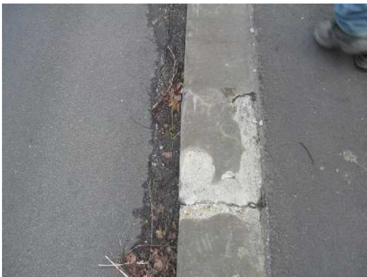
odpadlá sanační stěrka betonové obruby pravého chodníku
