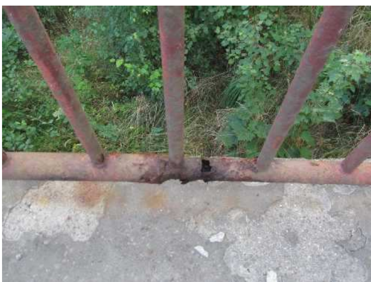
prokorodování dolního madla zábradlí
