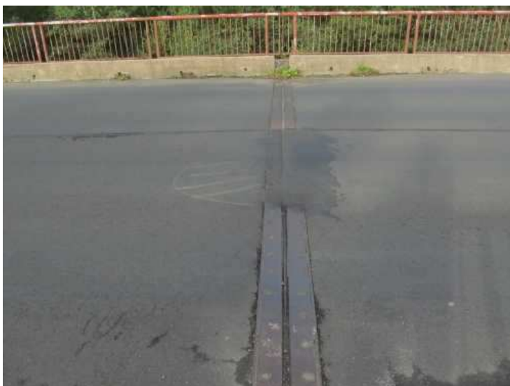
mostní závěr nad P3, částečné přeasfaltování závěru
