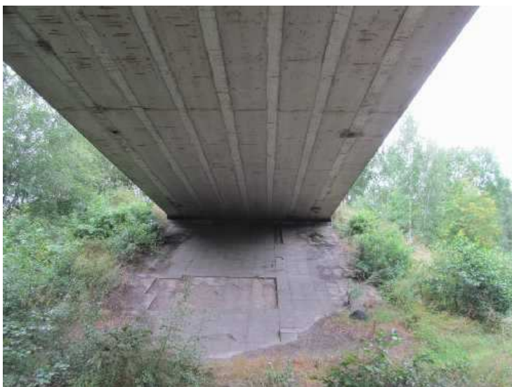
pohled na opěru OP4, rozebrané opevnění svahu
