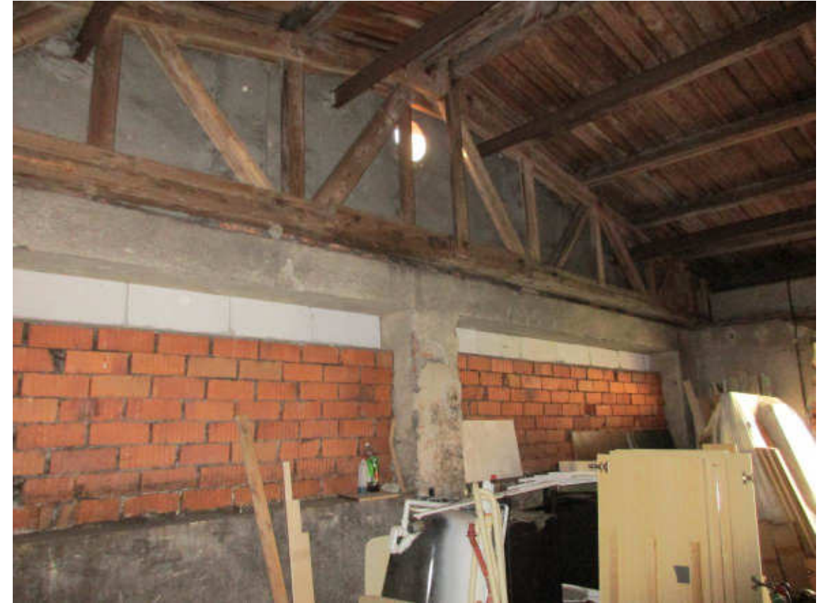
Vnitřní pohled na štítovou stěnu garáže
