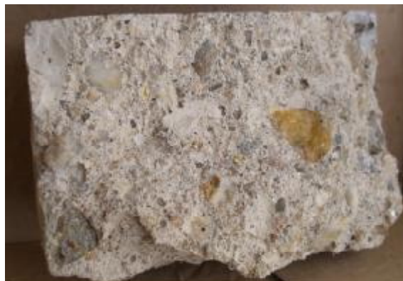
Foto 5: Vzorek betonu V 2.1
