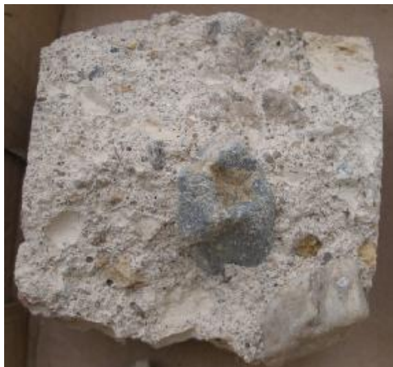
Foto 1: Vzorek betonu V 0.4
