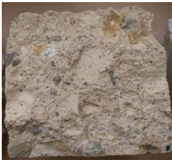
Foto 3: Vzorek betonu V 1.4
