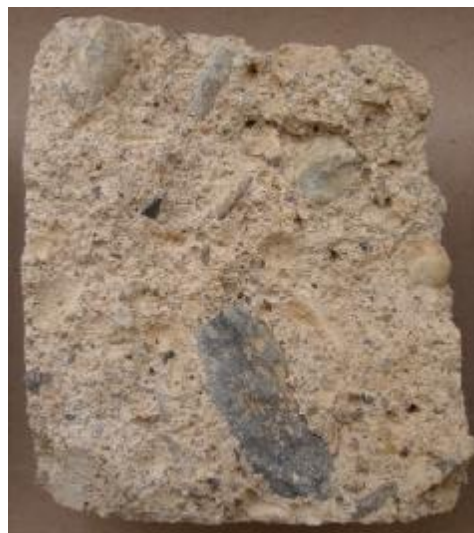
Foto 2: Vzorek betonu V 1.2
